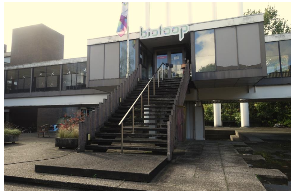
De uitbouw ter hoogte van het ketelhuis.
