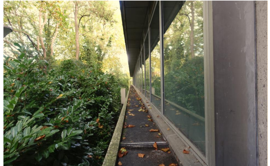
Door de aanwezigheid van de bakken lijken de puien van de langsegevels verdiept in de gevel te liggen.
