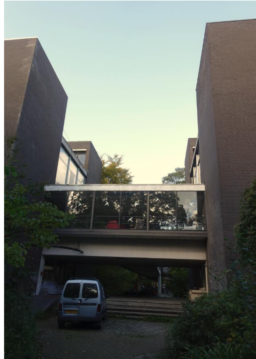
De loopbrug eindigt bij de zuidelijke aansluiting naar gebouw G en C.
