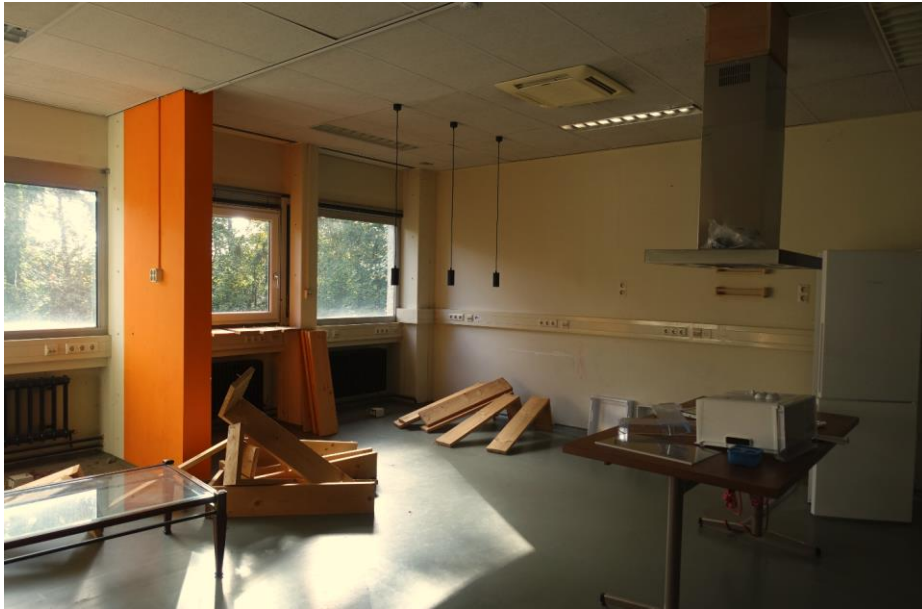
De afwerking van een ruimte in gebouw G.
