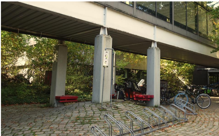
Een steunpunt van de loopbrug bestaat uit vier betonnen kolommen.
