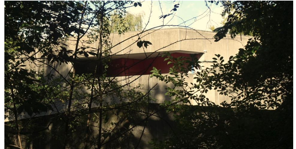
In de opbouw van de eerste verdieping van gebouw F is een inwendig balkon opgenomen.
