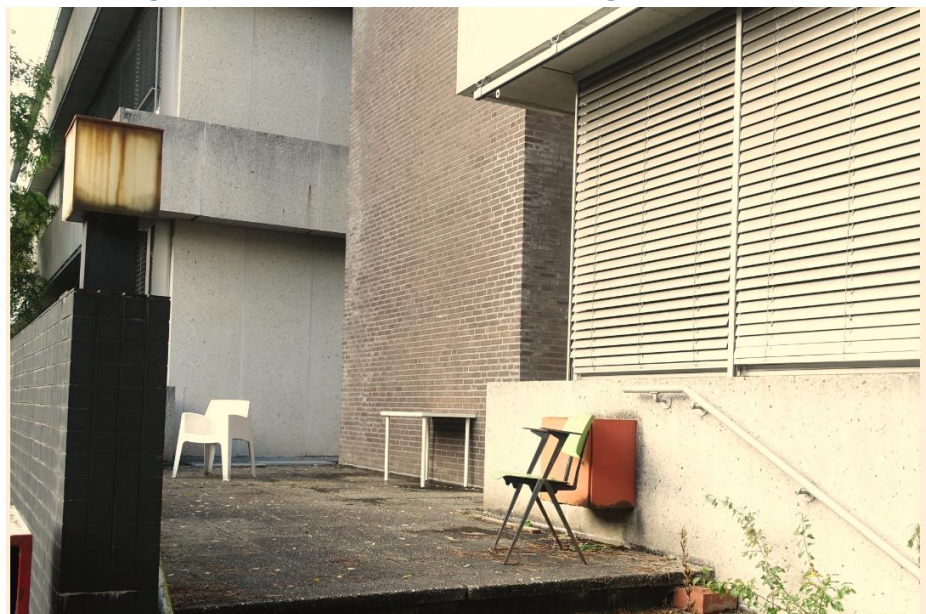
De middelste zuidtoeren bij gebouw A heeft een terras maar verder geen centrale toegang.
