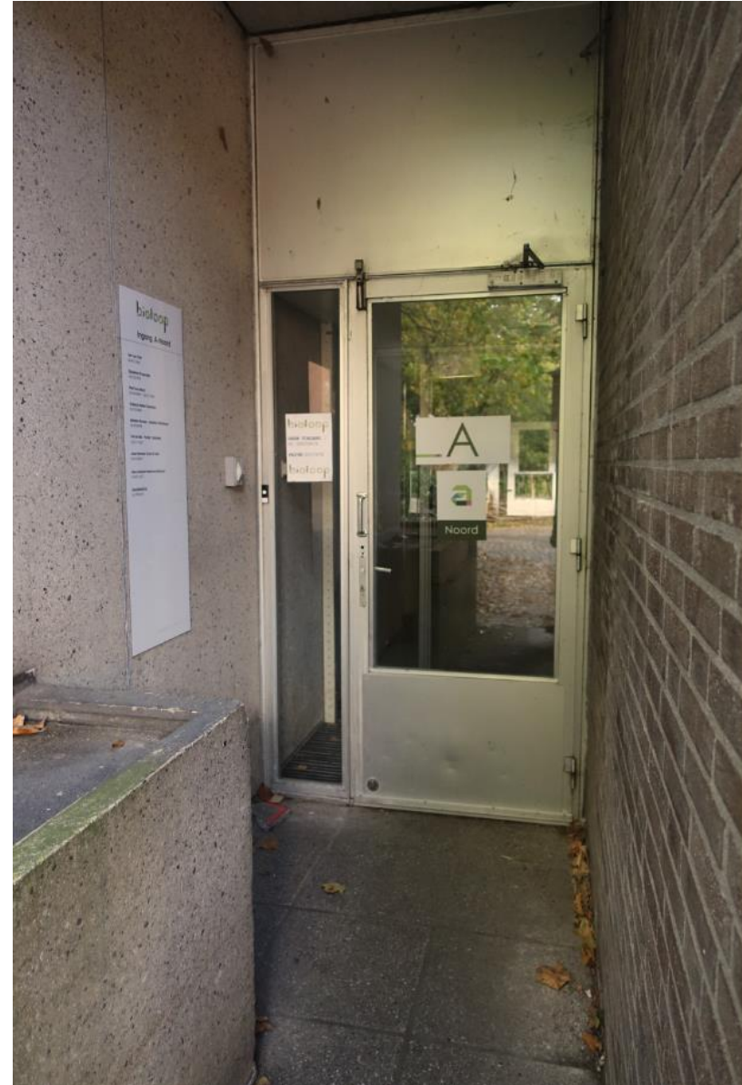
Bij de aansluiting tussen vleugel en toren is op de begane grond een toegang met aluminium deur geplaatst.
