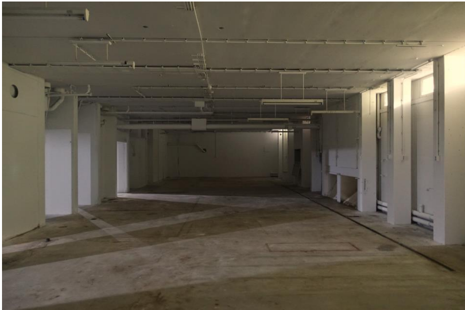
De betonnen kolommen van het skelet in de kelder van gebouw C.
