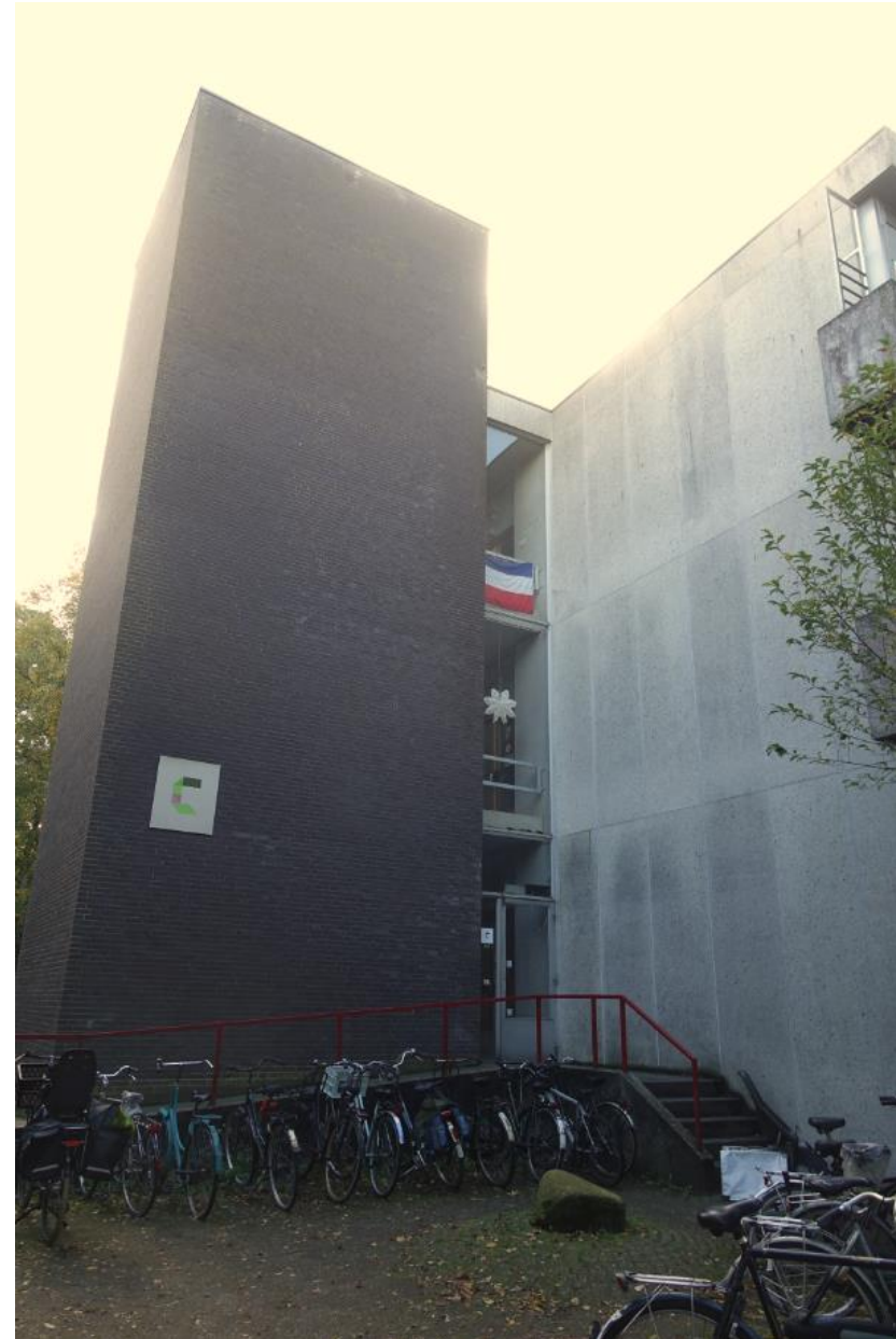
De toren aan de kopse zijde van gebouw C, voorzien van een bordes met helling en trapje.
