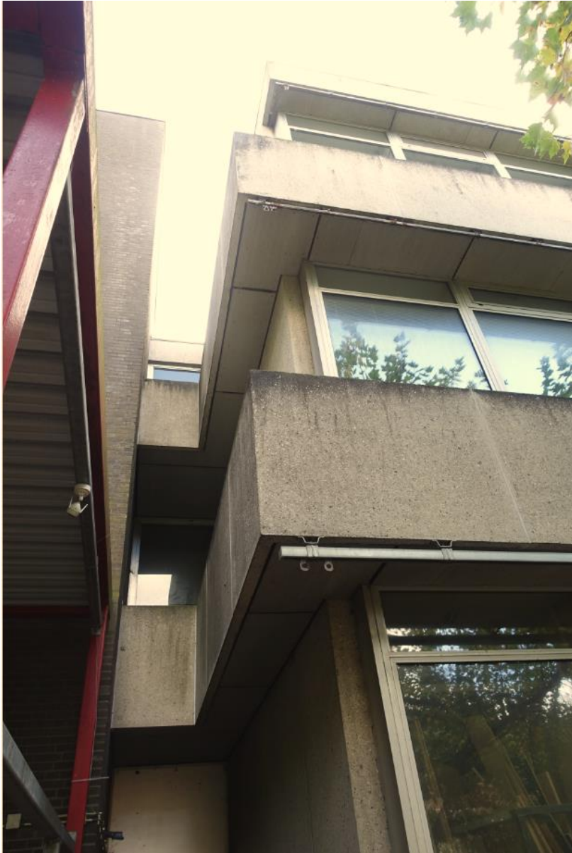
De aansluiting van vleugel A op de middelste noordtoren. De dakrand steekt minder ver uit als de bakken bij de borstweringen en is op de kopgevels niet omgezet zoals de bakken.
