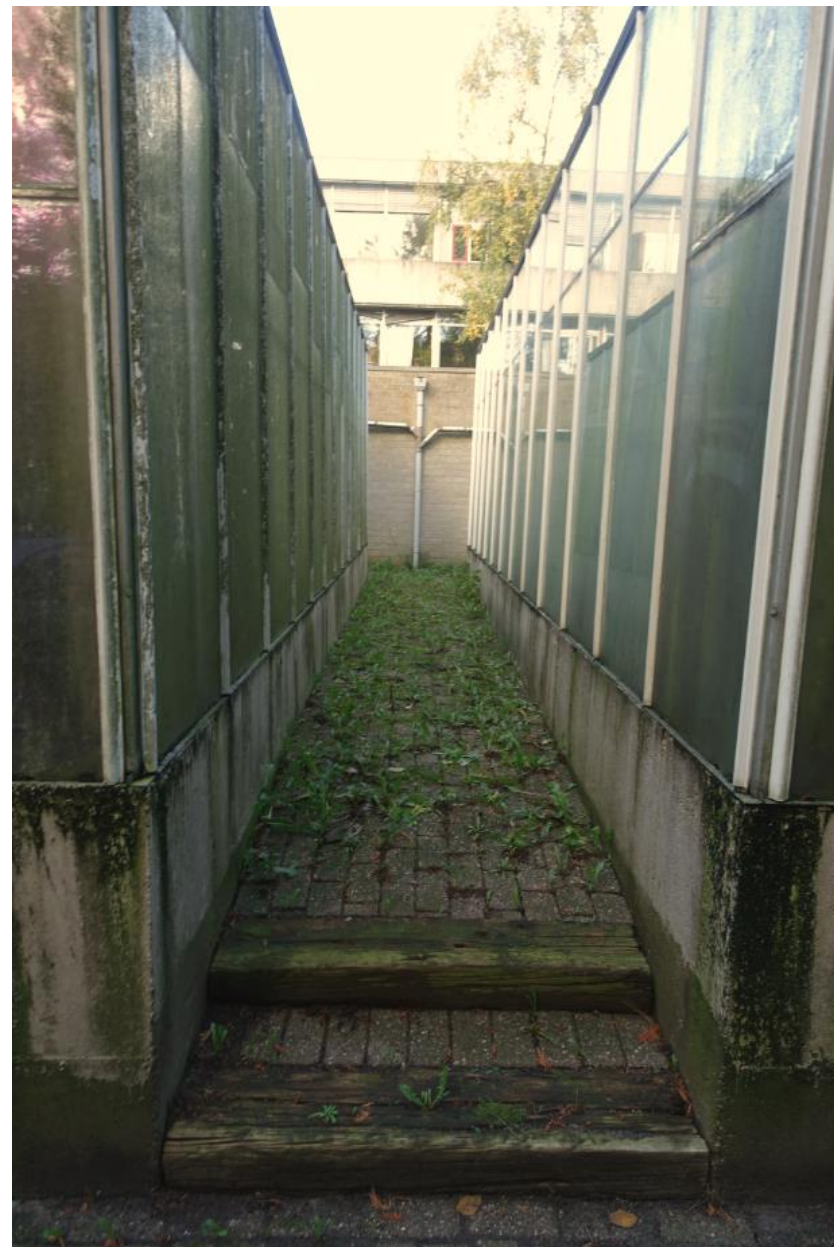
Zicht op de gevels van de kassen die aansluiten op de zuidgevel van gebouw C.
