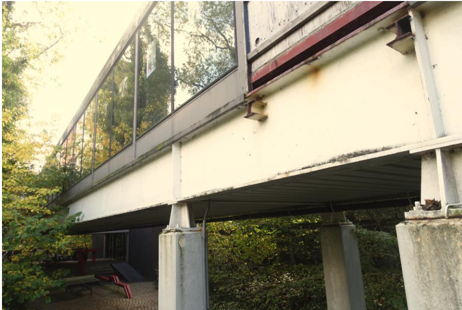
Zicht op de liggers van de loopbrug, die op stalen opleggingen zijn geplaatst.
