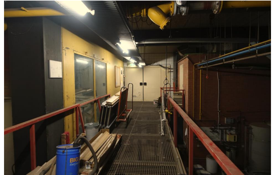
De loopbrug in het ketelhuis.
