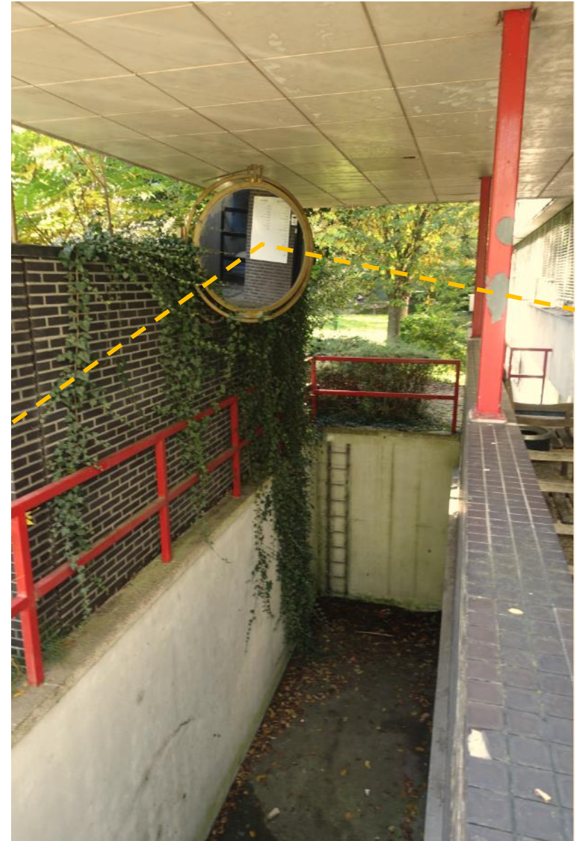
De spiegel waarmee de zonnestralen de gang van gebouw B in worden gespiegeld.
