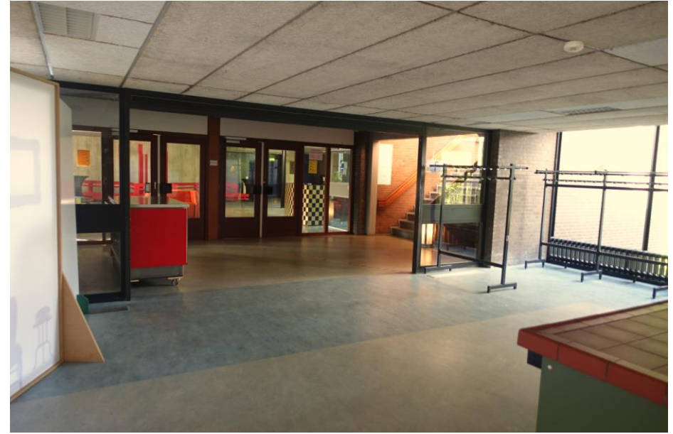
De aansluiting van de loopbrug op gebouw C.
