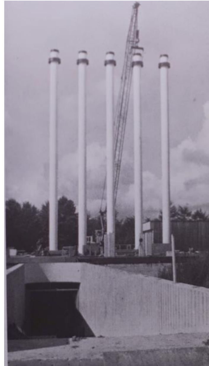
De vijf hoge ontluichtingskanalen van het ketelhuis. Schelte 1973, p.5.
