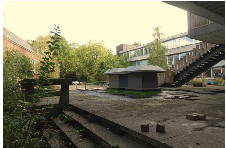
Het dak van het ketelhuis.
