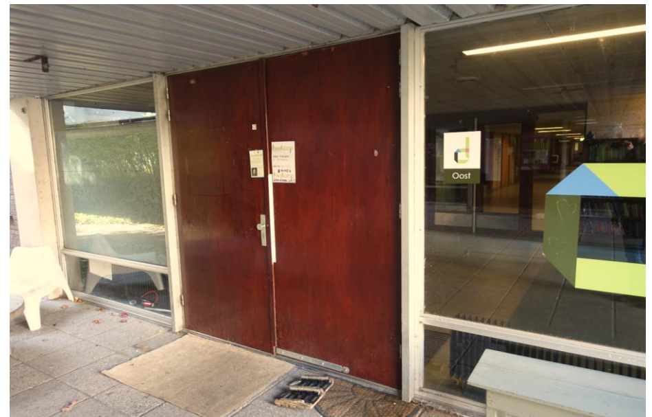
De entree tot gebouw D onder de loopbrug.
