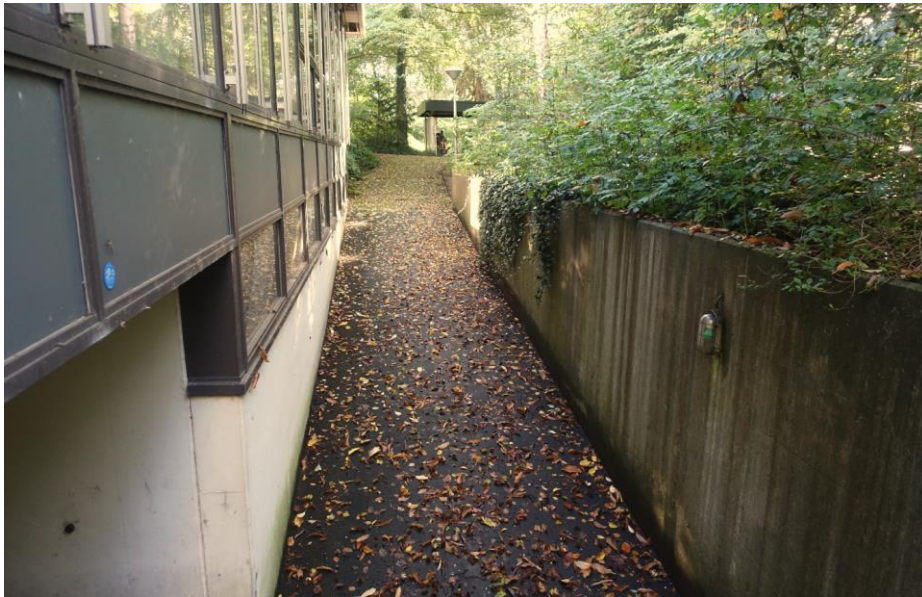
De hellingbaan naar de kelder aan de westzijde van gebouw F.
