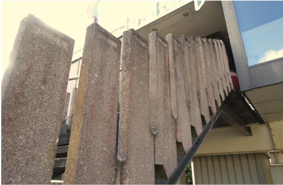
Detail van de sierbetonnen balustrade van de trap naar de loopbrug.
