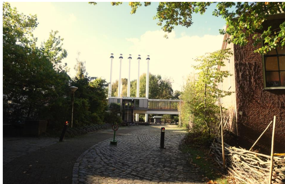
Zicht op het ketelhuis. Het terrein hier bestaat uit klinkers en kasseien.
