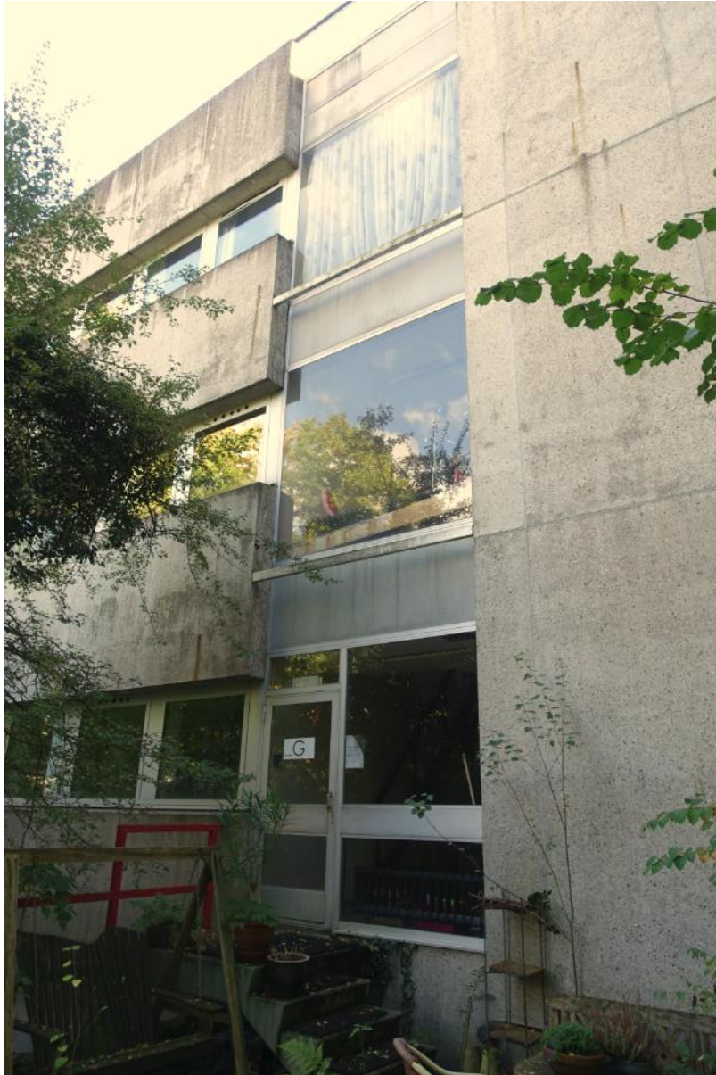
De horizontale geleding van de gevels wordt onderbroken door een verticale strook met toegang op de begane grond.
