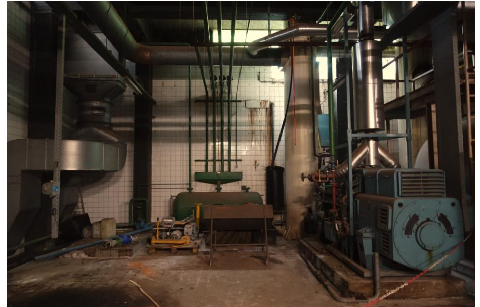
De ongedeelde kelderruimte van het ketelhuis.
