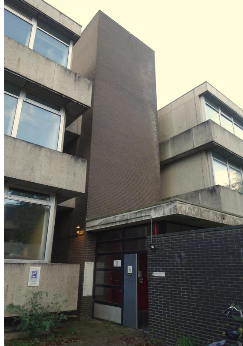
De entree tot gebouw B ter hoogte van de middelste toren, voorzien van moderne luifel uit 1990 en chemicaliënopslag. Ook hier is te zien dat de dakrand van de vleugels wel een duidelijke begrenzing vormt maar minder zwaar is uitgevoerd en minder overstek heeft dan de bakken voor de borstweringen.
