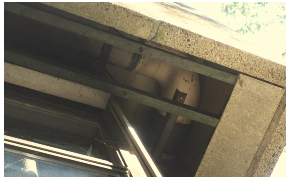
Detail van de grindbetonnen bakken waarin de leidingen zijn ondergebracht.
