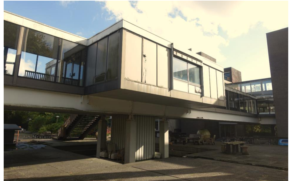
Het steunpunt ter hoogte van het ketelhuis is van binnen voorzien van damwandstaal.
