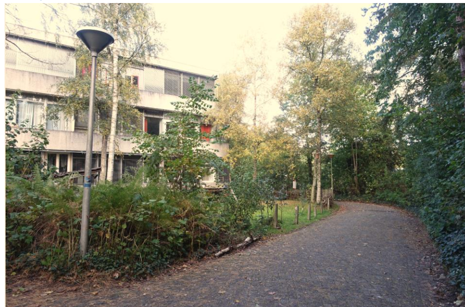
Aan de oostzijde van gebouwen A, B en C loopt een brede weg van betonklinkers.
