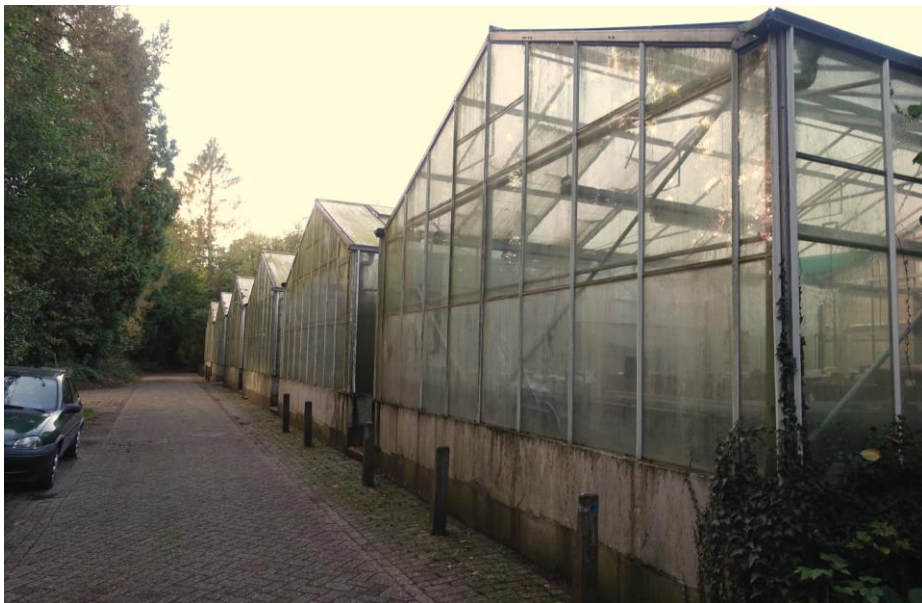
De kassen ten zuiden van gebouw C.
