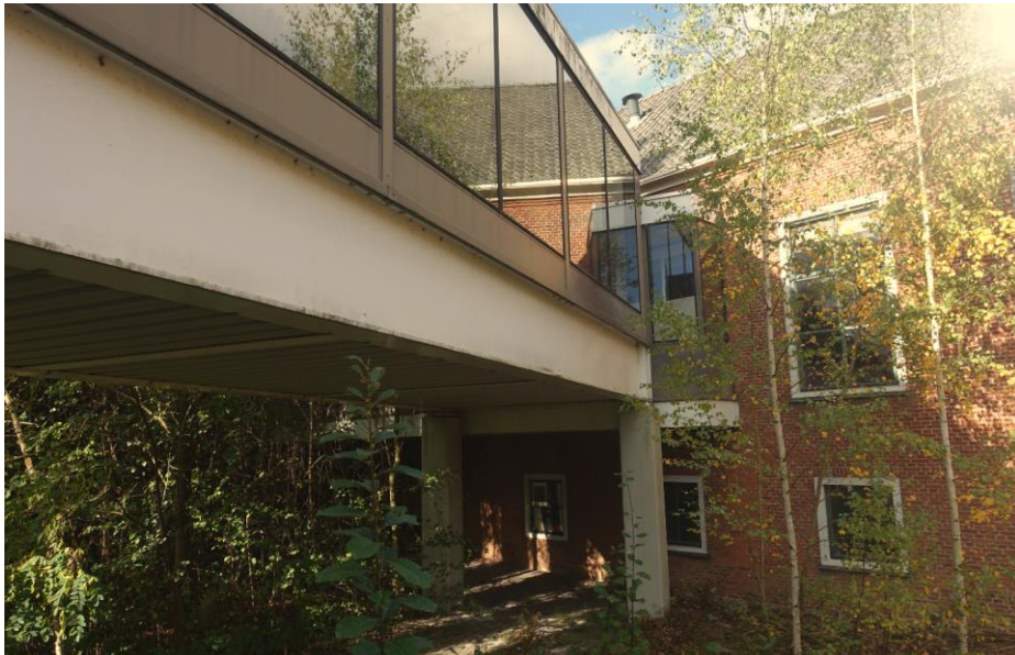
De aansluiting uit 1975 van de loopbrug op gebouw E.
