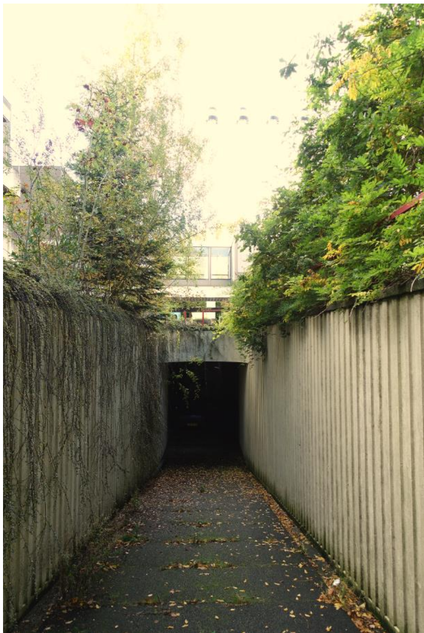
De hellingbaan naar het ketelhuis.
