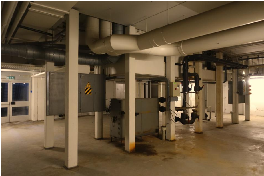
Betonnen kolommen van de begane grond vloer in gebouw G.
