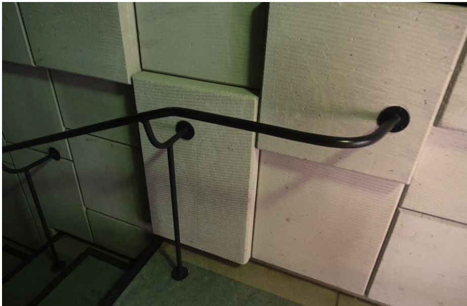
Detail van de wandafwerking met stalen leuning in de grote collegezaal in gebouw F.
