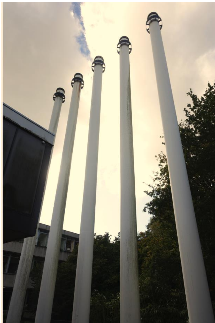
De vijf hoge stalen ontluftpipen op het dak van het ketelhuis.
