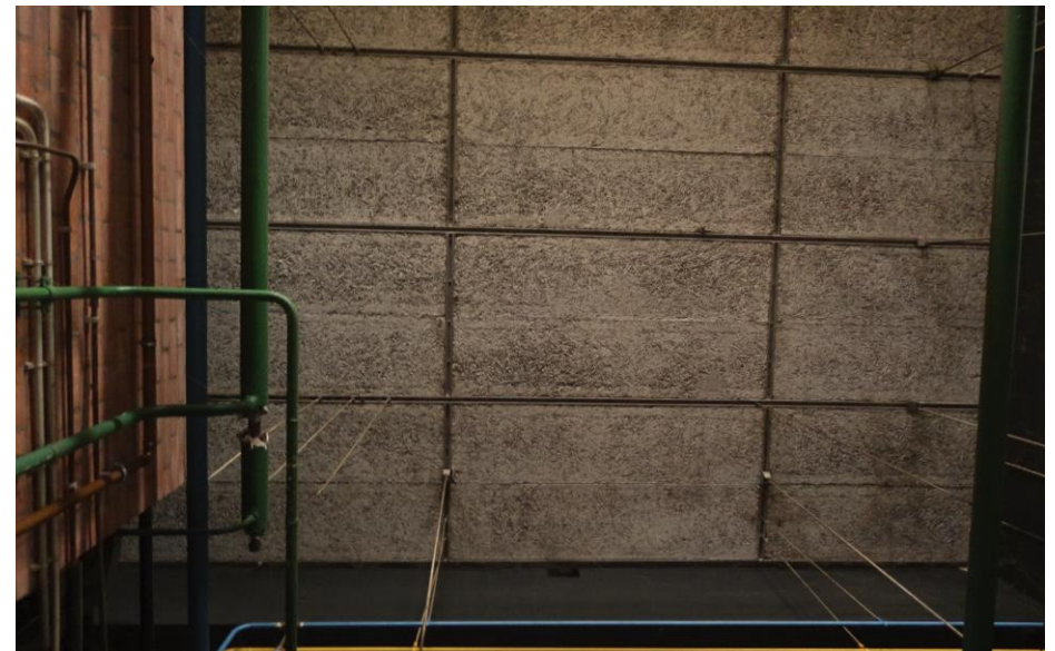
Het plafond van het ketelhuis is afgewerkt met houtvezelplaten.
