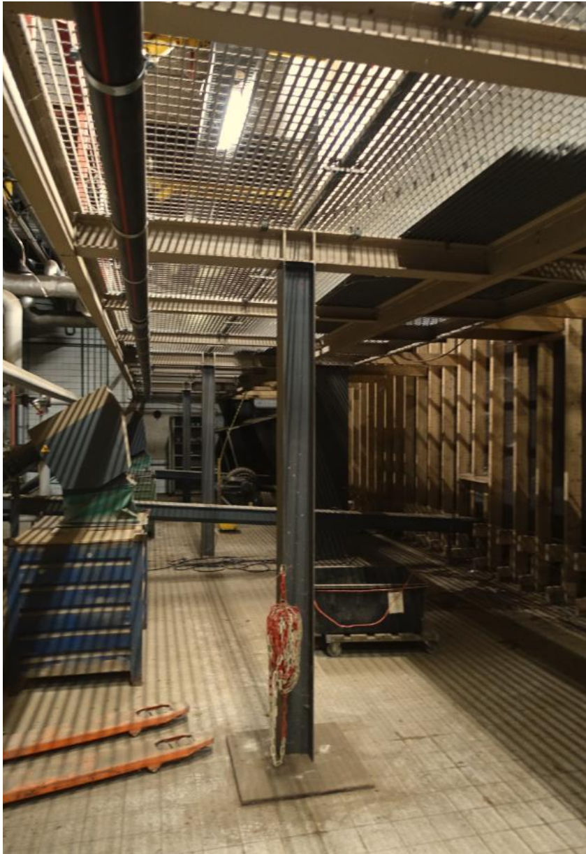
De stalen constructie van de loopbrug in het ketelhuis.
