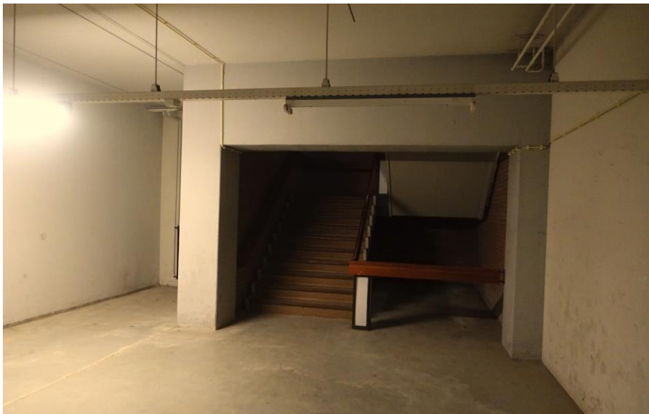
Het trappenhuis in gebouw G op kelderniveau.
