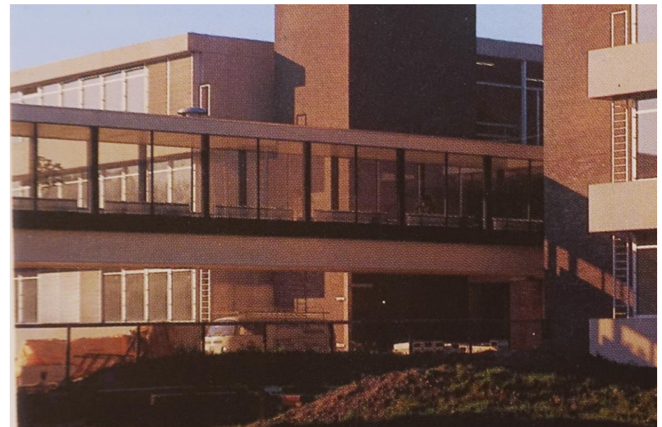
De loopbrug verdwijnt tussen twee vleugels. Via de torens konden de gebouwen vanuit de loopbrug worden bereikt. Schelte 1973, p.3.
