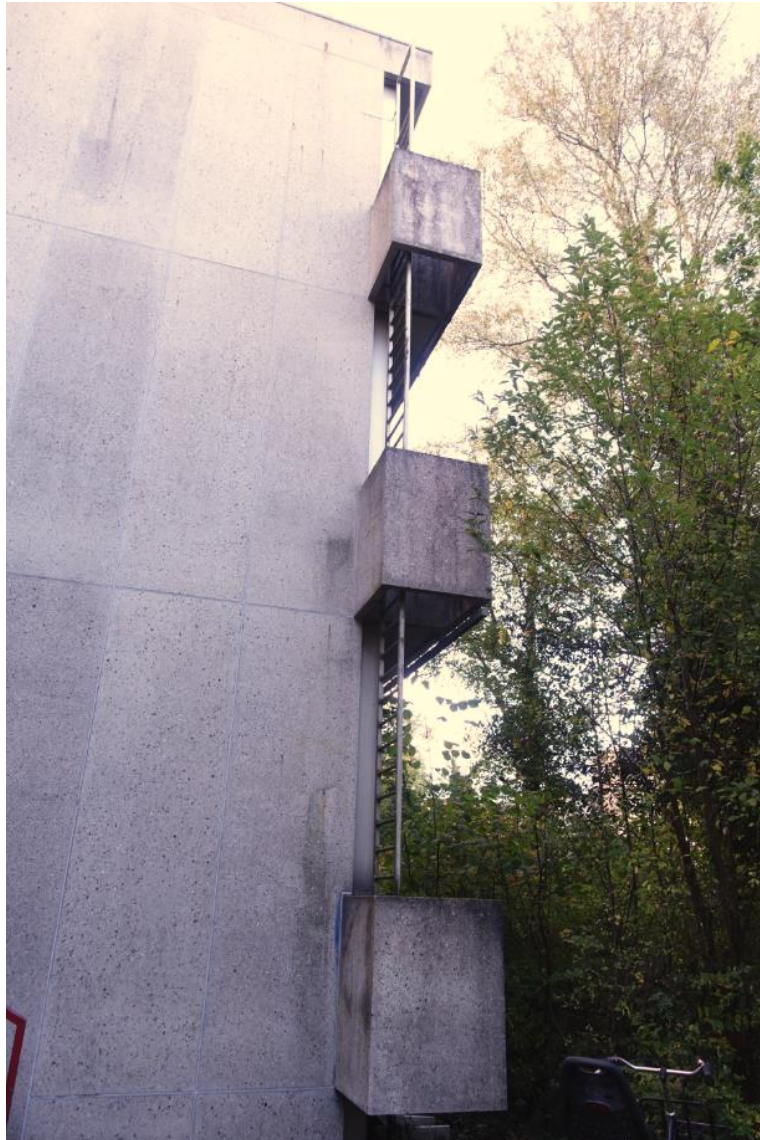
De bakken steken op het uiteinde van de langsgevel door en fungeren als brandtrap. De dakrand hoekt om en heeft hier geen overstek, alleen een naad scheidt deze zone hier van de gevel eronder.
