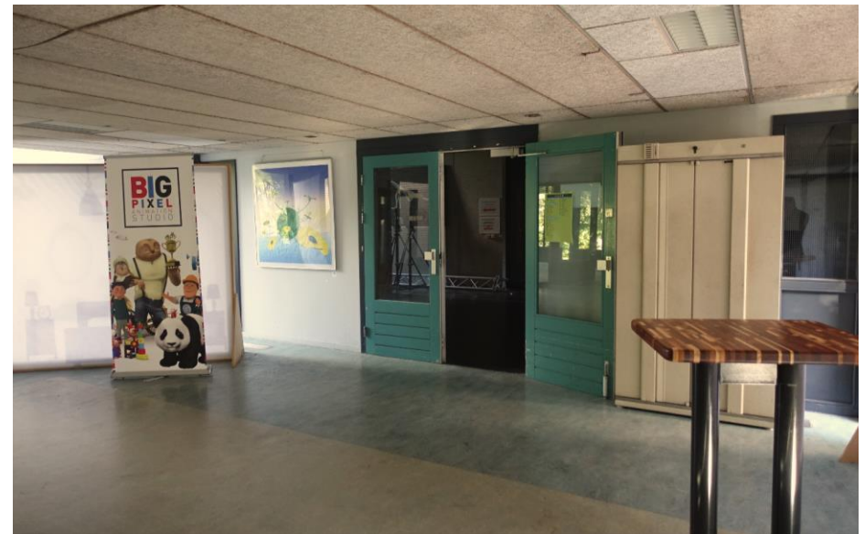
De aansluiting van de loopbrug op gebouw G.
