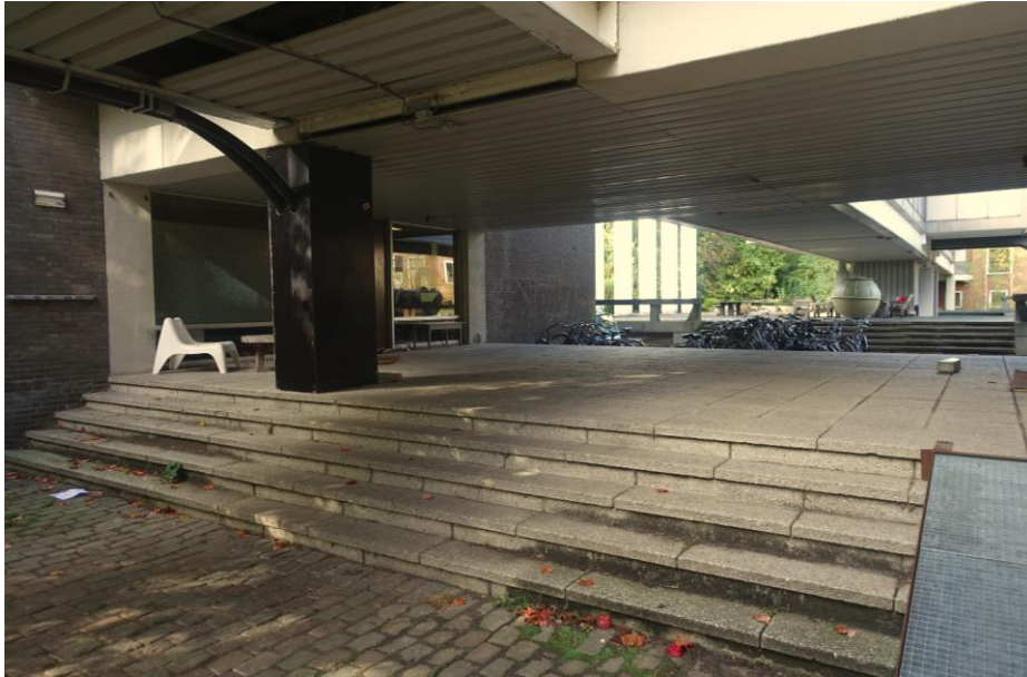
Het terras onder de loopbrug tussen gebouw A en D.
