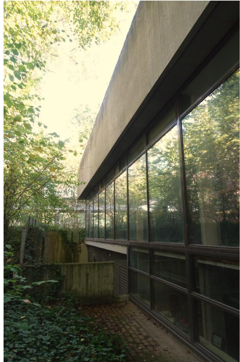
De begane grond van gebouw F.
