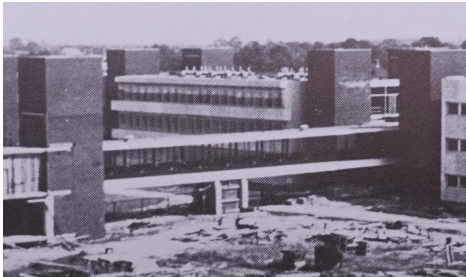
Zicht op de loopbrug die alle gebouwen met elkaar verbindt. Schelte 1973, p.15.
