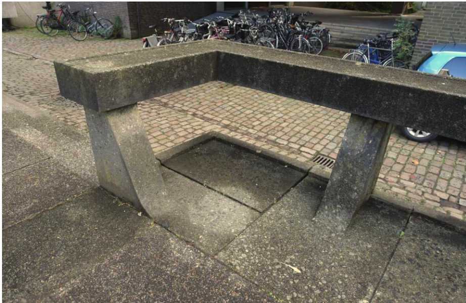
Detail van de betonnen reling langs het dak van het ketelhuis.
