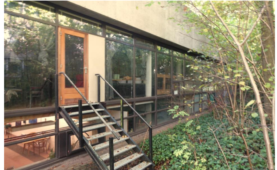
Op begane grond niveau zijn secundaire toegangen gemaakt die toegankelijk zijn via stalen trappen.
