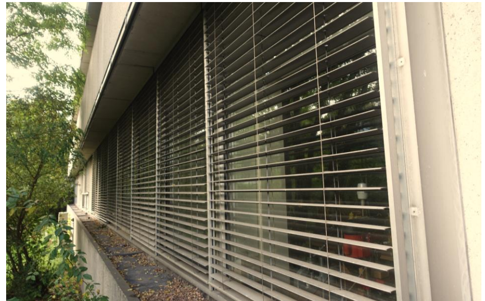
De oorspronkelijke jaloezieën voor de ramen in de langsegevel van gebouw A.
