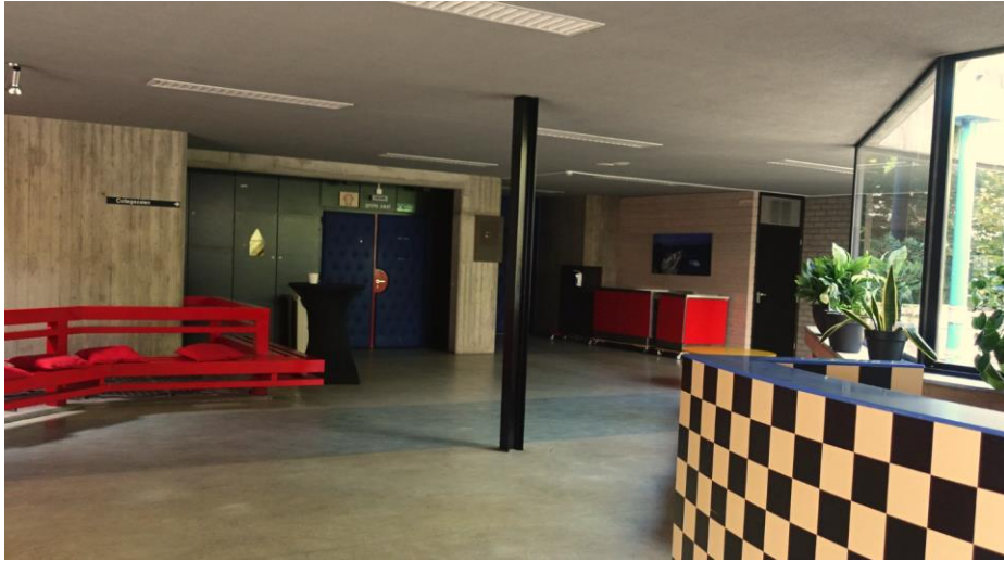
Een ondersteunende kolommen van de verdiepingsvloer in gebouw F.
