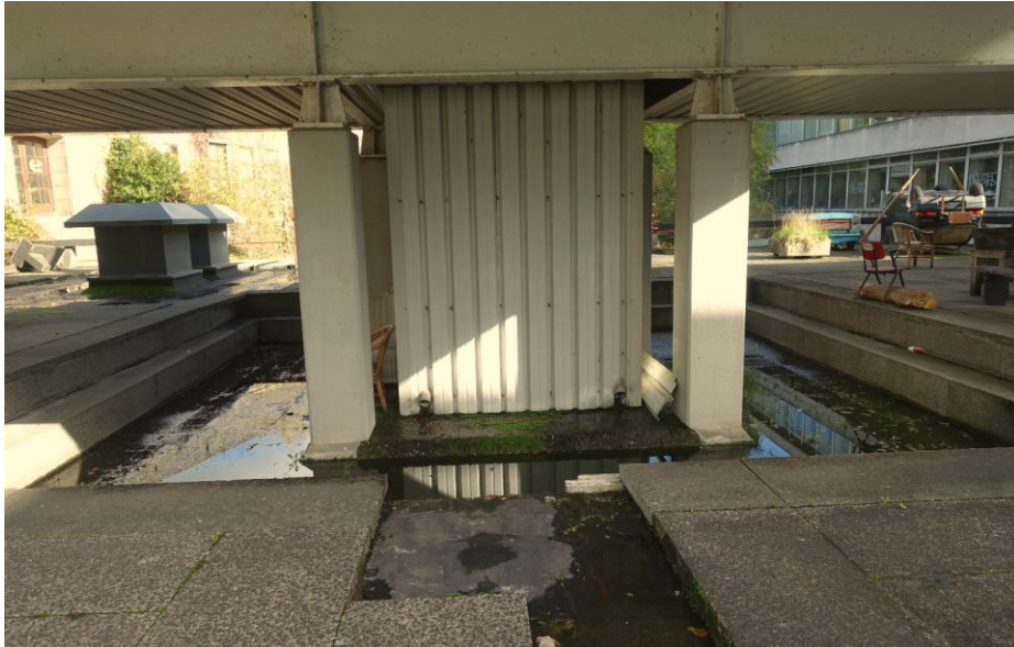
Op het dak van het ketelhuis zijn betonnen kolommen van de loopbrug gesitueerd.
