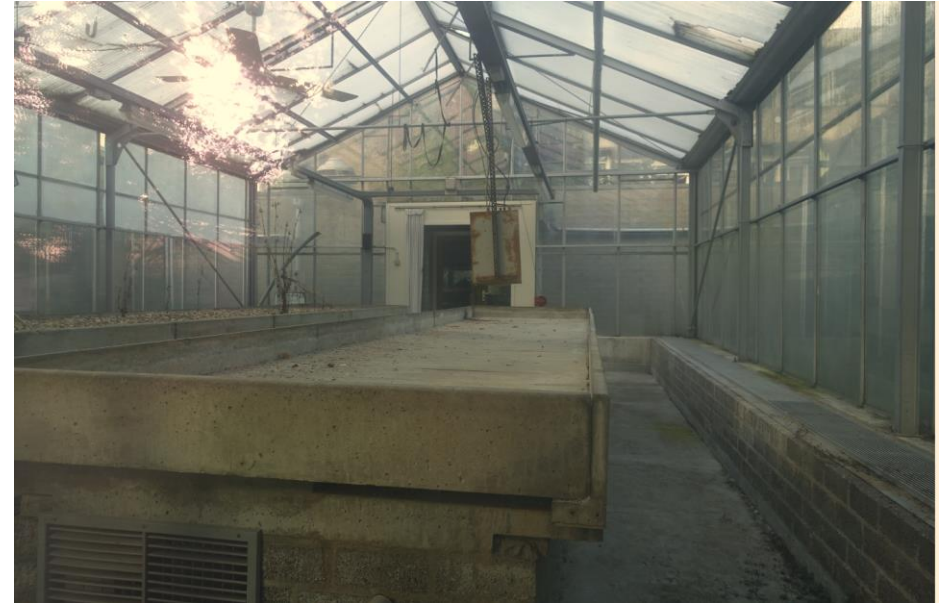
De kassen staan via een gang met elkaar en gebouw C in verbinding.
