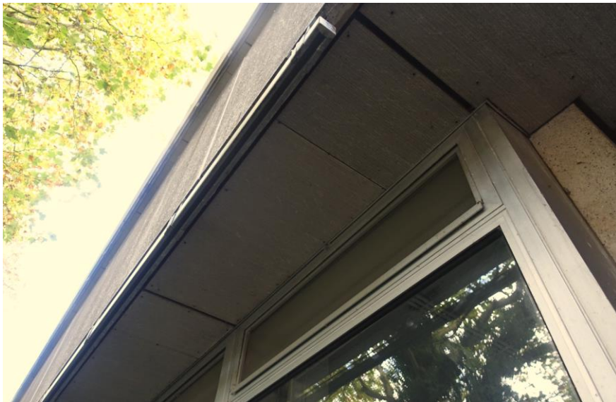
De onderzijde van de bakken voor de borstwering van de lange gevels van gebouw A.
