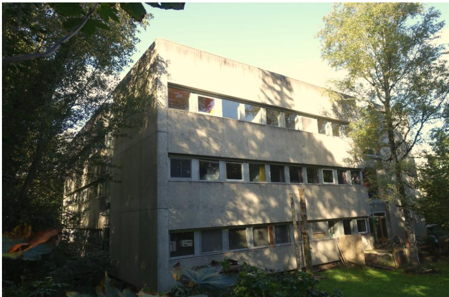
Gebouw G gezien vanuit het zuiden.
