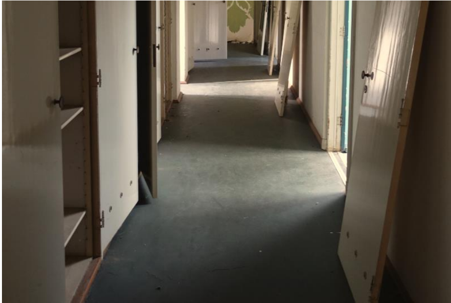
Een groene linoleumvloer in de gang op de zolder van het hoofgebouw.
