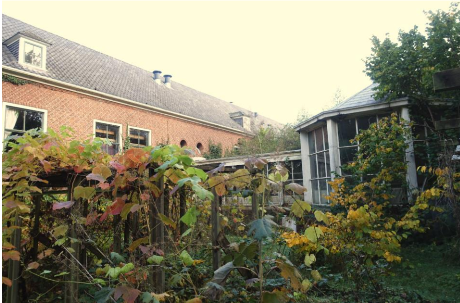
Verscholen in het groen is het achthoekige insectarium te zien dat via een gang aansluit op de zuidgevel van het hoofdgebouw.
