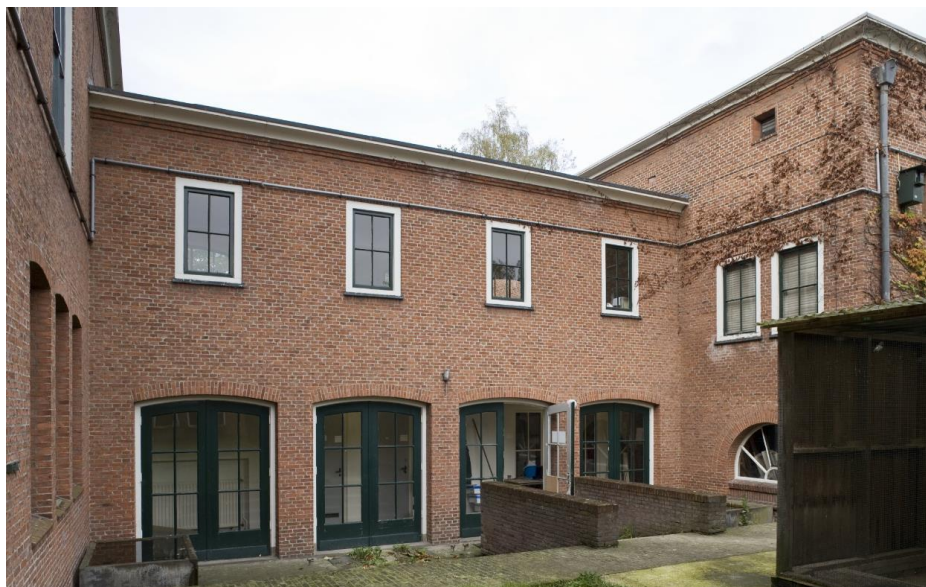
De aansluiting van de westelijke vierkante uitbouw op het hoofgebouw in 2008. RCE beeldbank, nr. 542.756.
