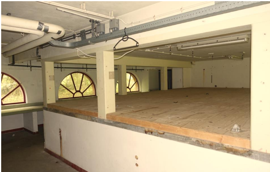
Het betonskelet in het souterrain van de westelijke uitbouw.
