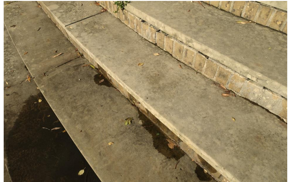
Detail van de dekking van Montanier natuursteen bij de traptreden van de bordestrap voor de hoofdentree.
