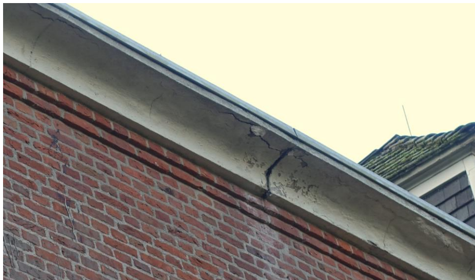
Detail van de betonnen goot, hier aan de noordzijde van het hoofdgebouw.
