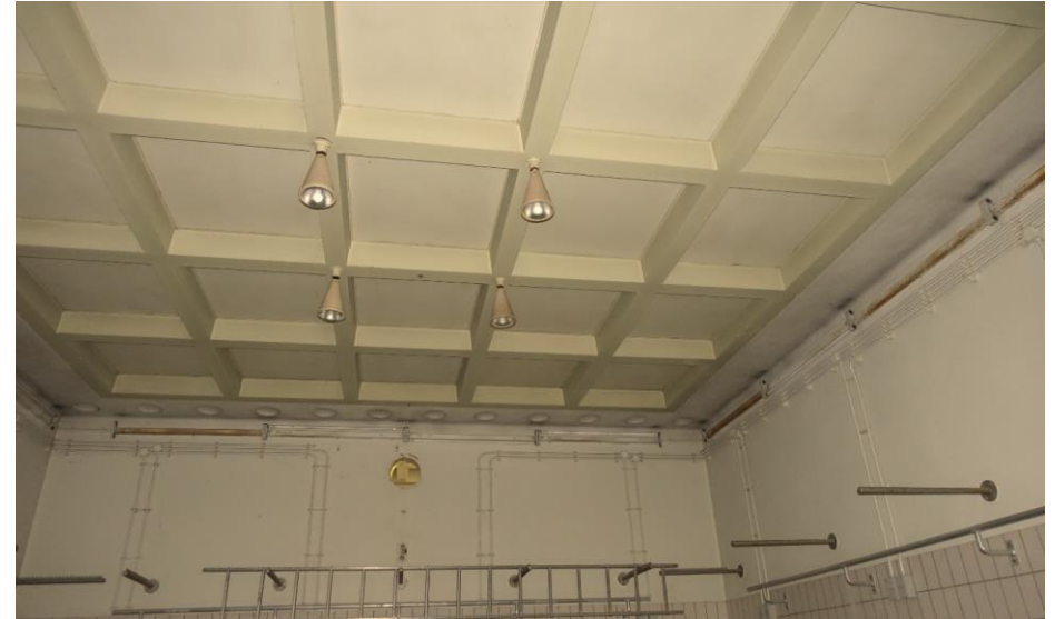
Dichtgezette daklichten boven de ruimte op de begane grond in de westelijke uitbouw.
