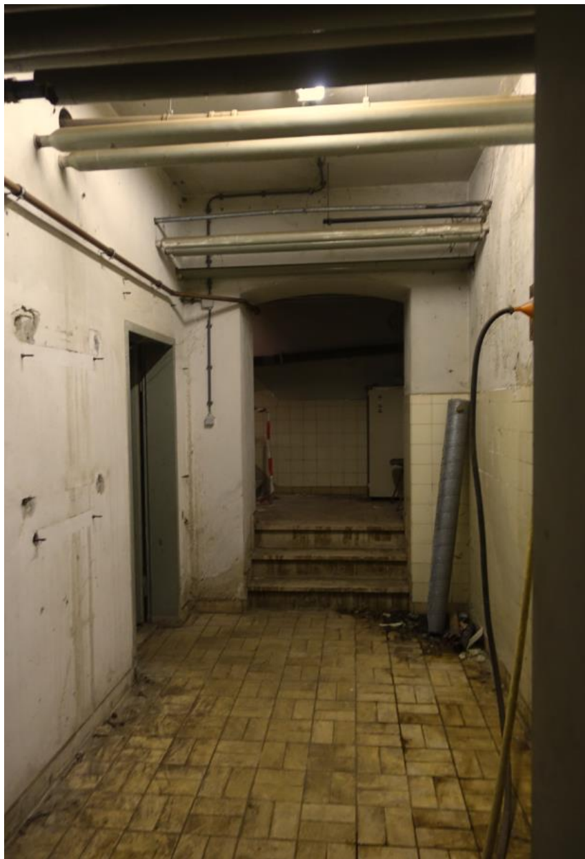
De gang waaraan de twee kelderruimtes zijn gelegen onder het hoofdgebouw.
