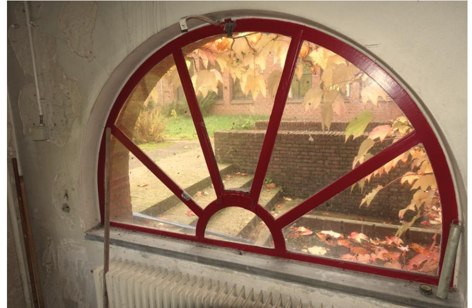
De binnenzijde van de vensters in het souterrain van de westelijke uitbouw.
