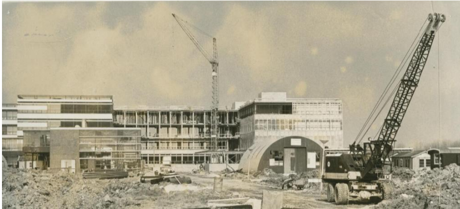
Scheikundecomplex in aanbouw in de nieuwbouwwijk Paddepoel. GA beeldbank, nr. NL-GnGRA_1785_8971.
