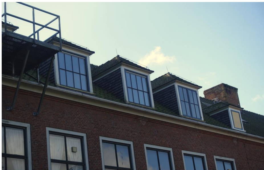
De oorspronkelijke dakkapellen met leienekking aan de noordzijde van het hoofdgebouw.
