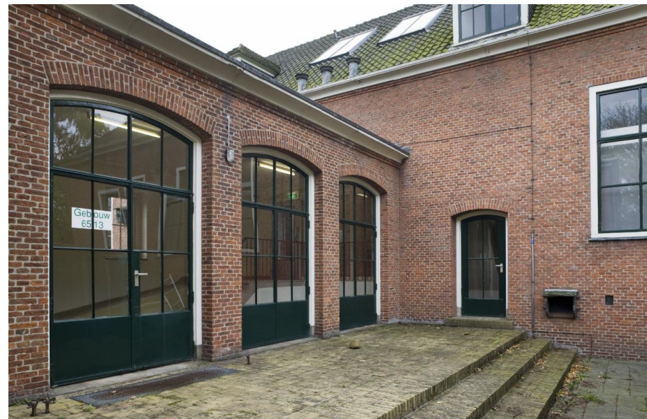
De aansluiting van de westelijke uitbouw op de noordgevel van het hoofdgebouw in 2008. RCE beeldbank, nr. 542.765.
