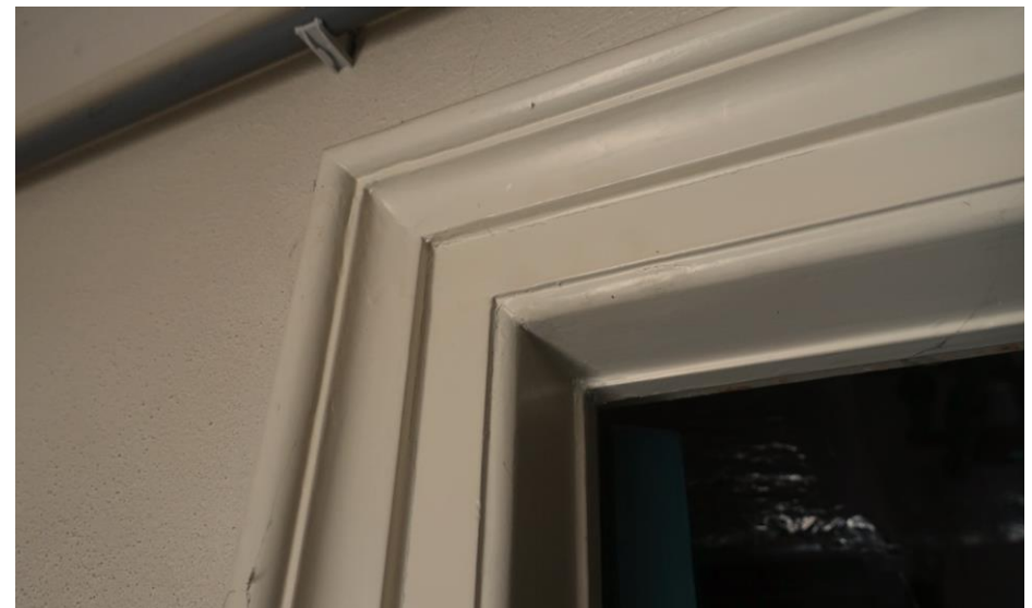
Detail van een oorspronkelijk deurkozijn. Een dergelijke profilering wordt ook veelvuldig toegepast in de 19de eeuw.
