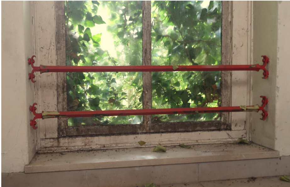
De raamijzers bij het trappenhuis naast de vestibule in het hoofdgebouw.
