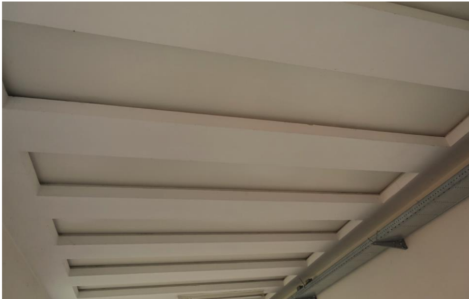
Het open betonplafond boven de gang op de begane grond in het hoofdgebouw.
