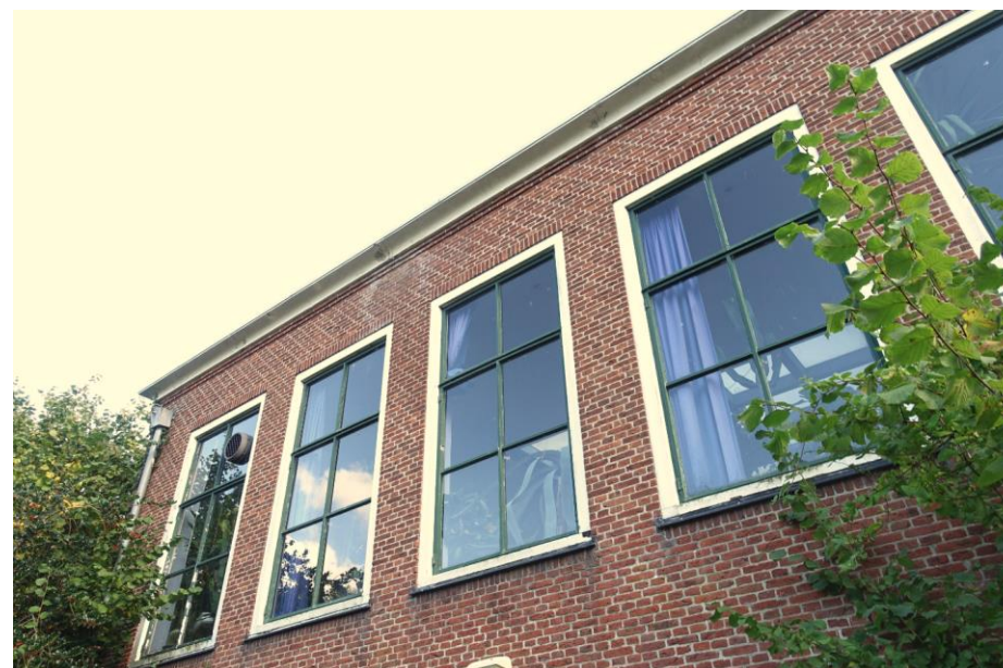
Voorbeeld van rechte vensters met rollagen aan boven- en onderzijde, hier in de westelijke uitbouw.
