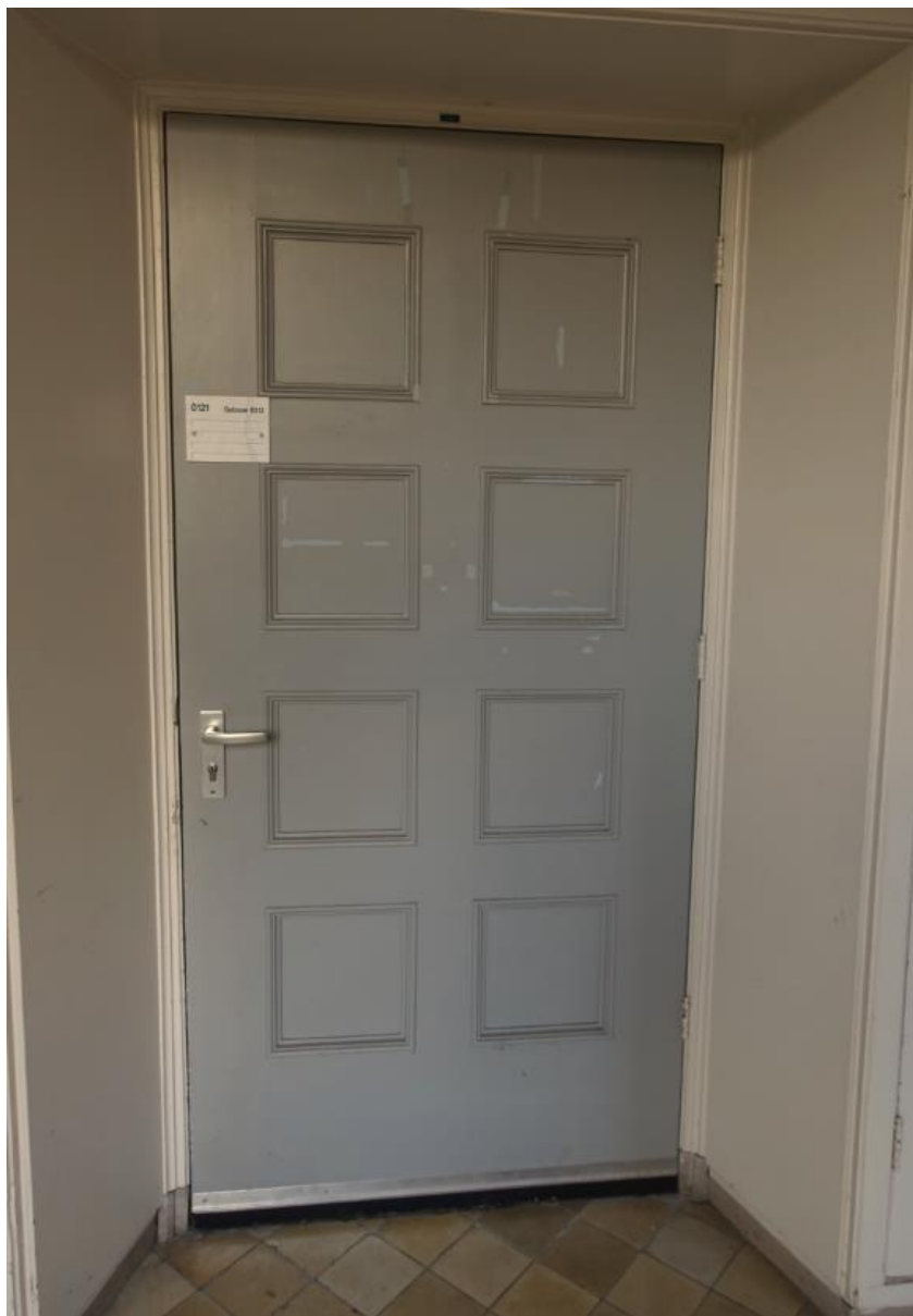
Oorspronkelijke deur met panelen, hier op de begane grond van het hoofdgebouw.
