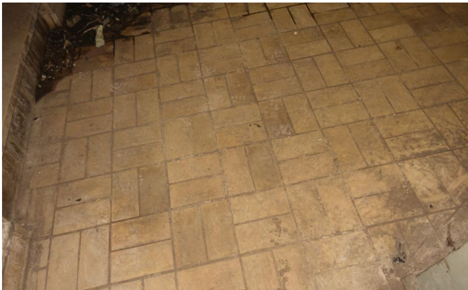
Vloer van bakstenen op zijn kant in de verwarmingskelder onder het hoofgebouw.
