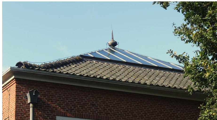
De bedekking van het dak van de oostelijke uitbouw bestaat deels uit ene harde dekking en deels uit glas. Centraal op het dak een piron.
