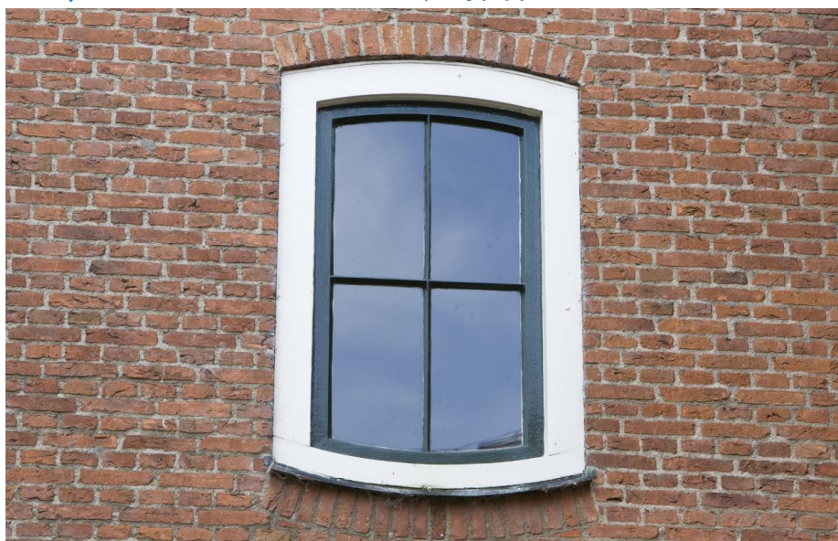
Detail van een oud venster met vulling in de noordgevel van het hoofdgebouw. RCE beeldbank, nr. 542.750.
