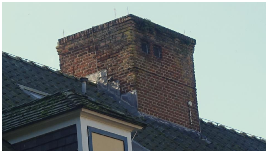
Detail van de brede schoorsteen die door de nok van het dak van het hoofdgebouw steekt.
