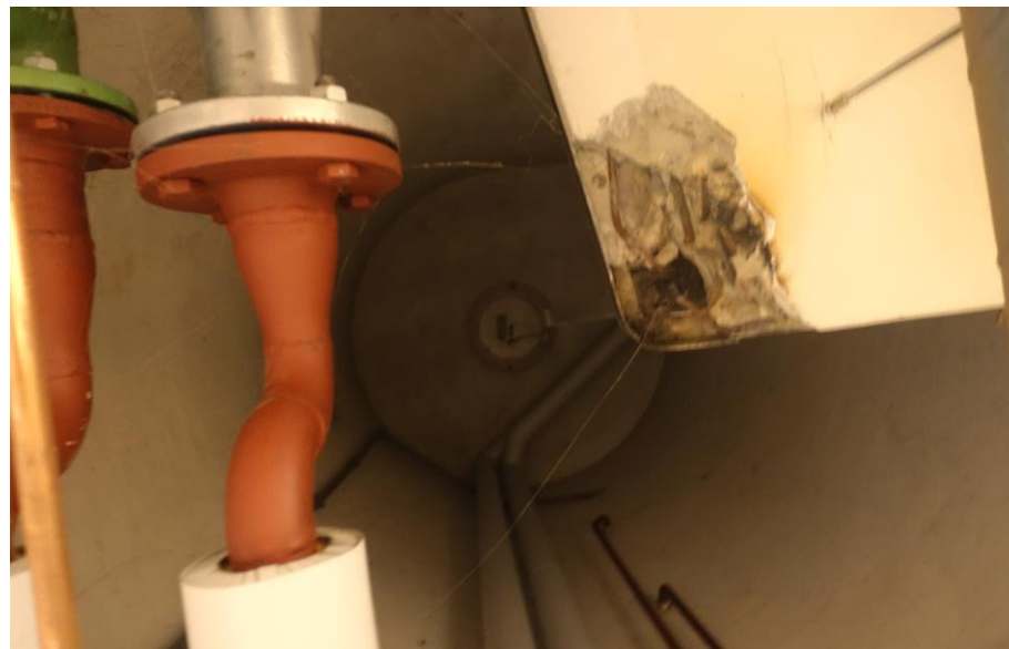
In de ruimte met de keldertrap naar de verwarmingskelder onder het hoofdgebouw is een koker aanwezig waar in 1950 een wenteltrap is gepland.
