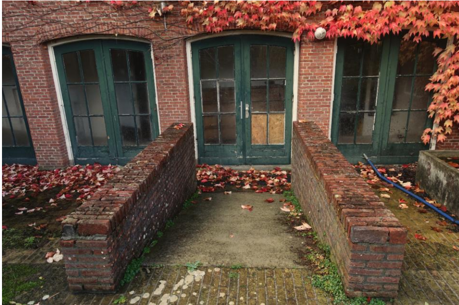
De toegangen in de gevel van de aansluitende gang tussen westelijke uitbouw en het hoofdgebouw.
