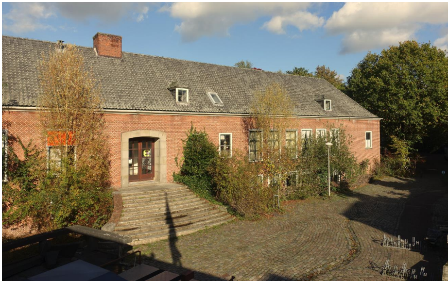
De zuidgevel van het hoofdgebouw gezien vanaf de luchtbrug.
