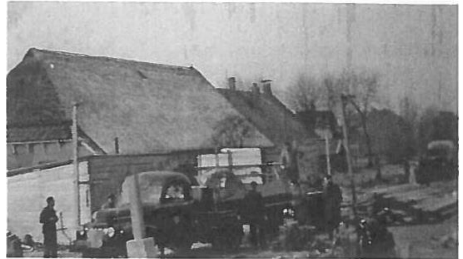
Boerderij de Lok tijdens de bouwwerkzaamheden aan het nieuwe zoölogische Laboratorium. Van Geest 2015, p.5.
