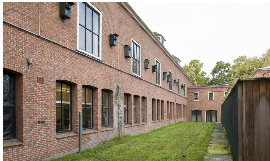
De noordgevel van het hoofdgebouw tussen de twee vierkante uitbouwen in 2008. RCE beeldbank, nr. 542.756.
