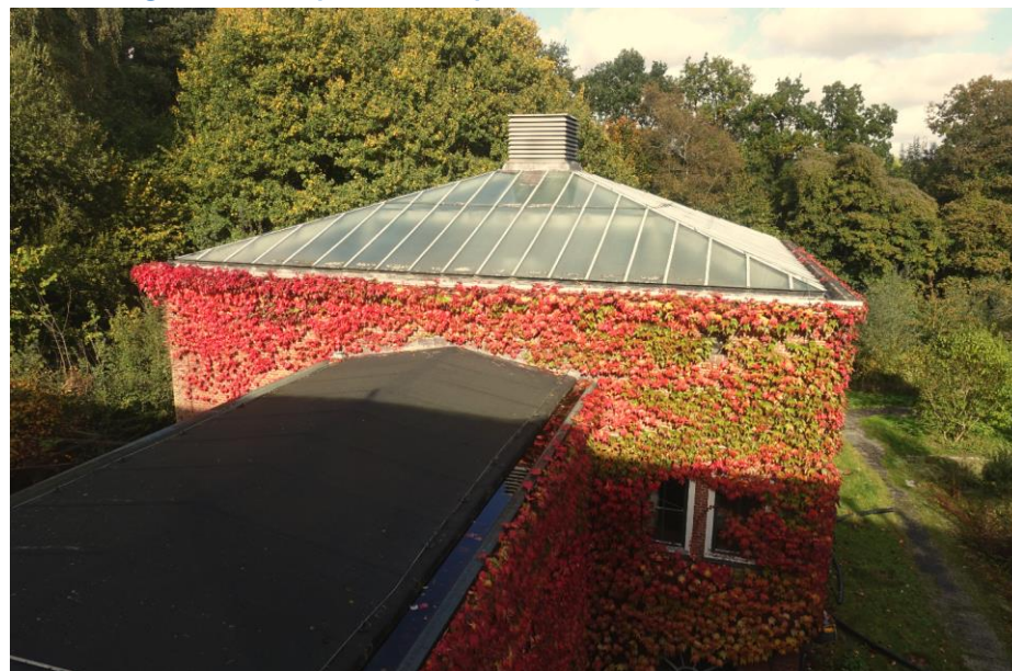
De bedekking van het tentdak van de westelijke uitbouw bestaat uit glas. De aansluitende gang is bedekt met bitumen.
