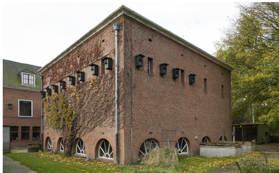
De gevels van de westelijke uitbouw in 2008. RCE beeldbank, nr. 542.761.
