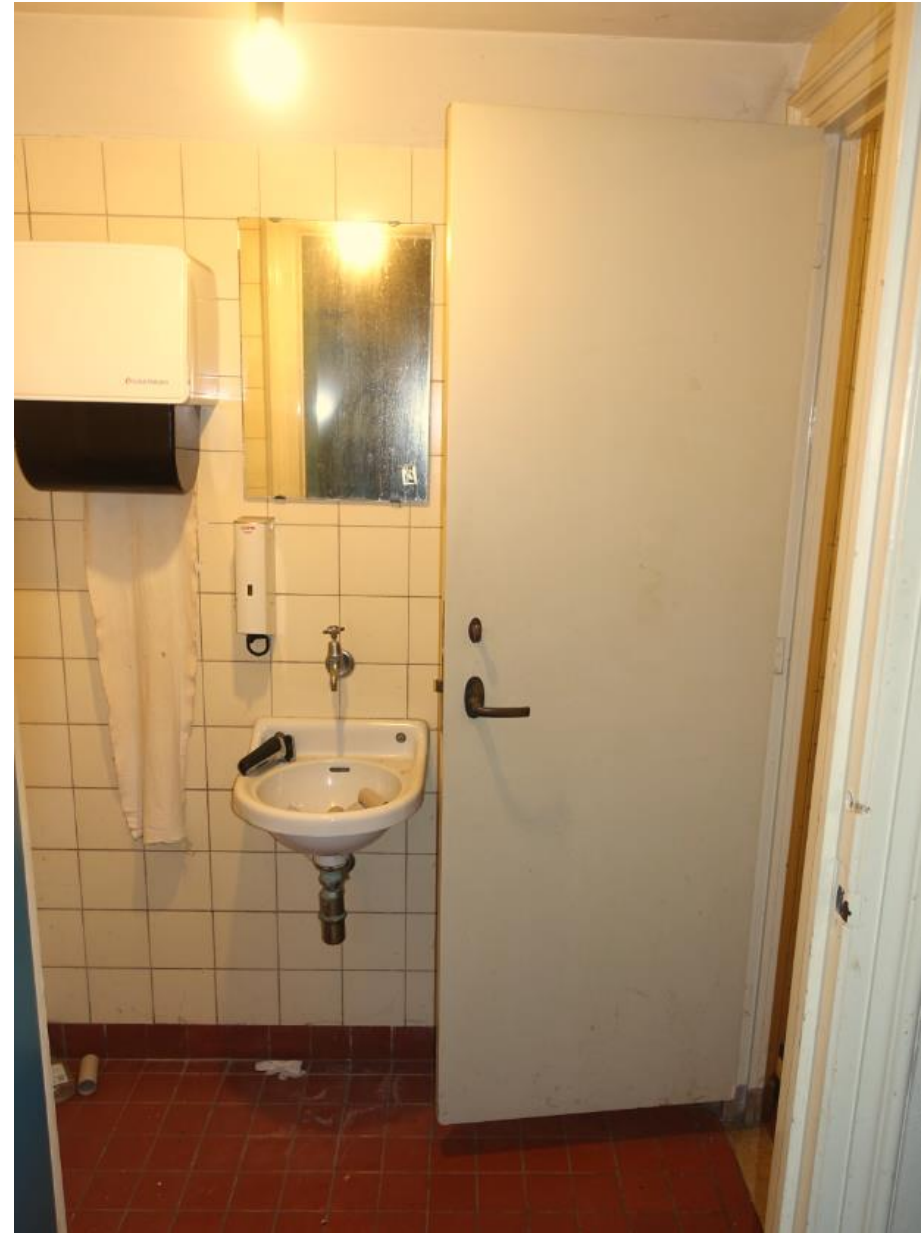
Technische en sanitaire ruimtes hebben een oorspronkelijke wandafwerking van tegels.
