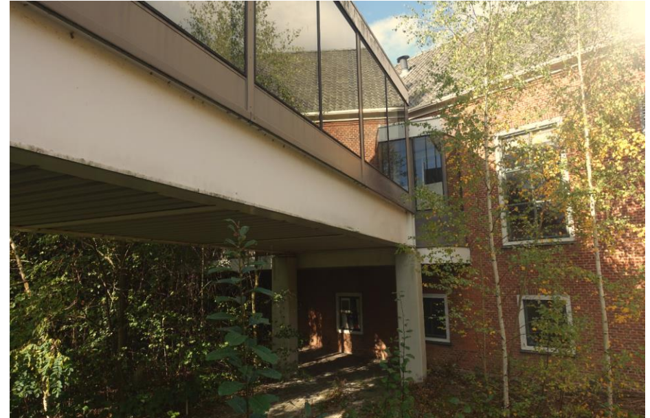
De aansluiting van de luchtbrug met de zuidgevel van het hoofdgebouw.
