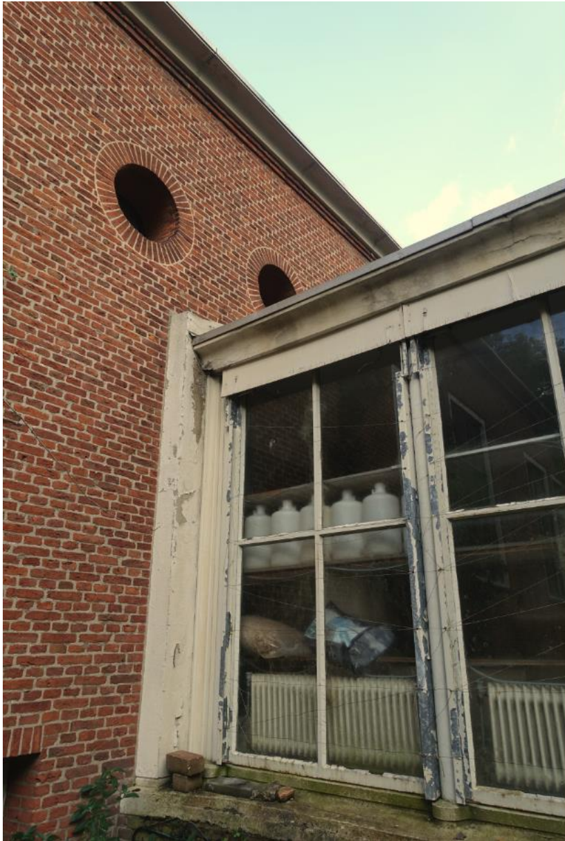
Bij de aansluiting van het insectarium op de zuidgevel van de hoofdbouw zijn drie rondvensters te zien.
