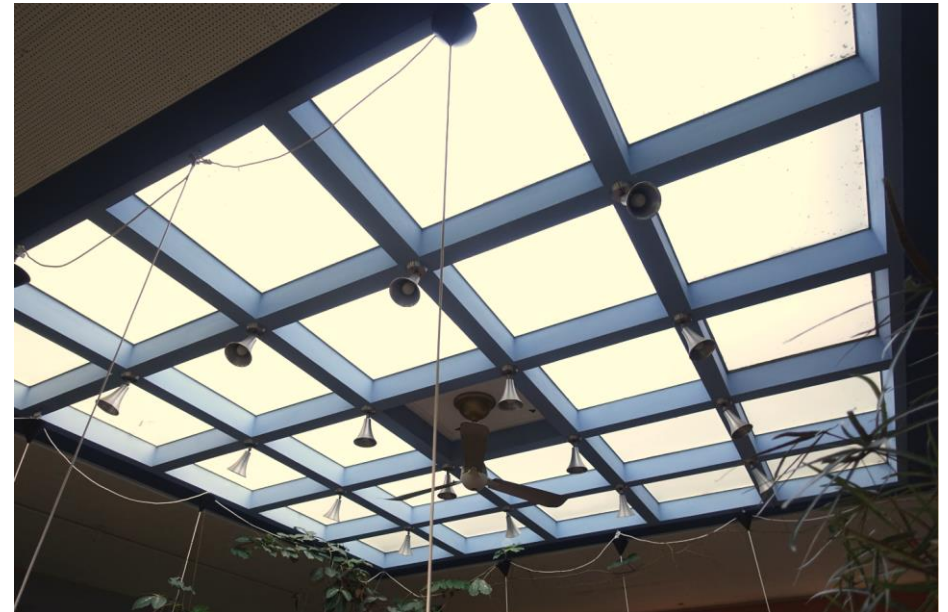
Oorspronkelijke daklichten boven de ruimte op de begane grond in de oostelijke uitbouw.
