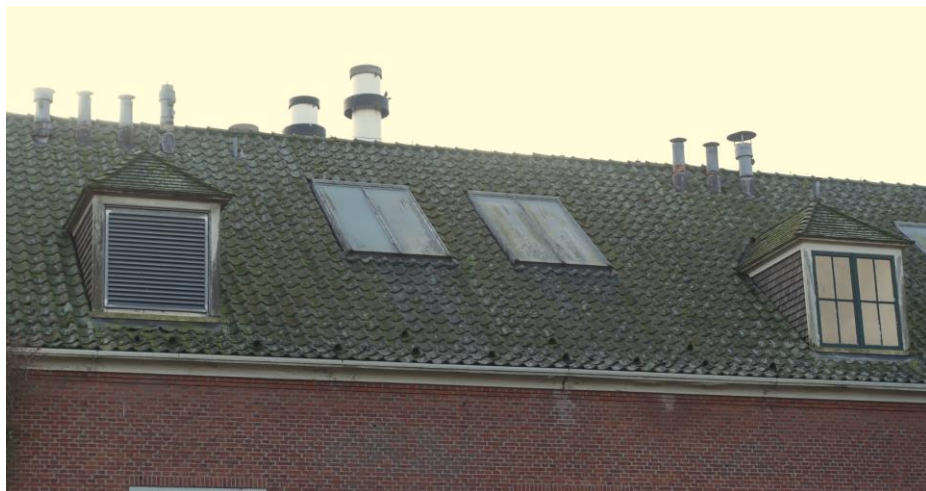
Dakvensters aan de noordzijde van het hoofdgebouw.
