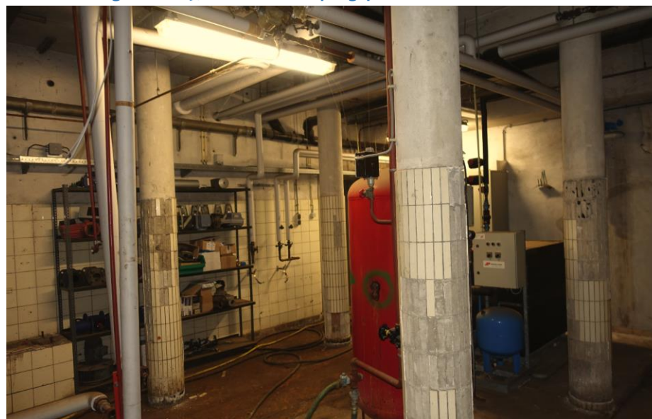
De kelderruimte onder het hoofdgebouw met het brede rookkanaal.
