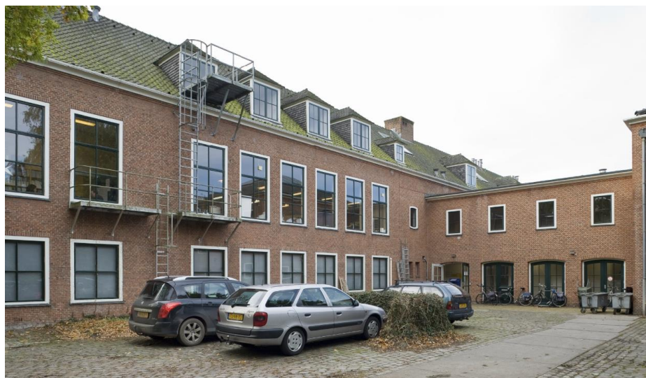
De noordzijde van het gebouw in 2008 met de aansluiting van de oostelijke vierkante uitbouw. RCE beeldbank, nr. 542.746.
