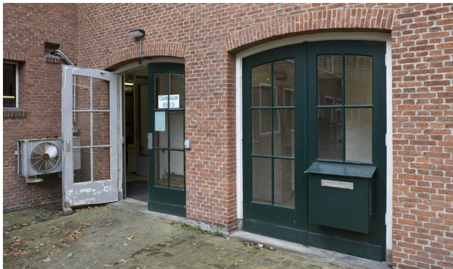
Detail van de doorgangen in de hal die de aansluiting vormt tussen het hoofdgebouw en de oostelijke vierkante uitbouw. RCE beeldbank, nr. 542.748.
