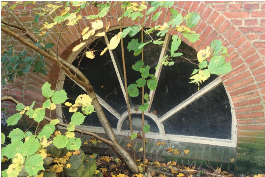
De vensters in het souterrain van de westelijke uitbouw.
