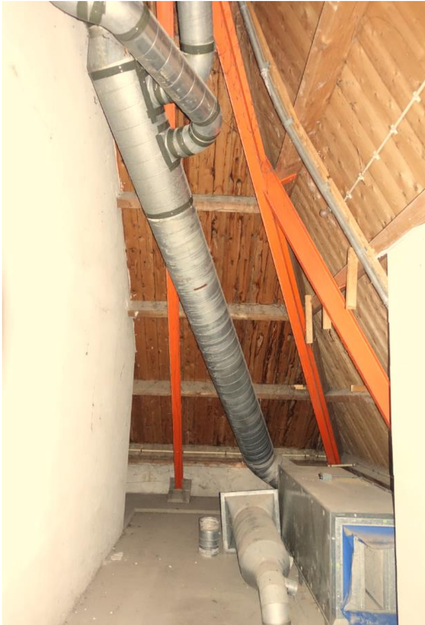
De stalen spanten boven het hoofdgebouw.
