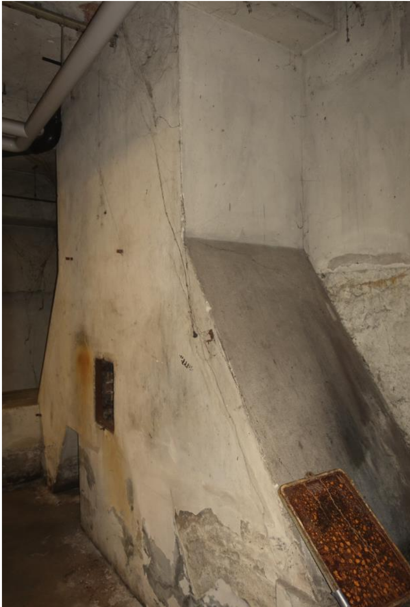
Het brede rookkanaal in een van de kelderruimtes onder het hoofgebouw.
