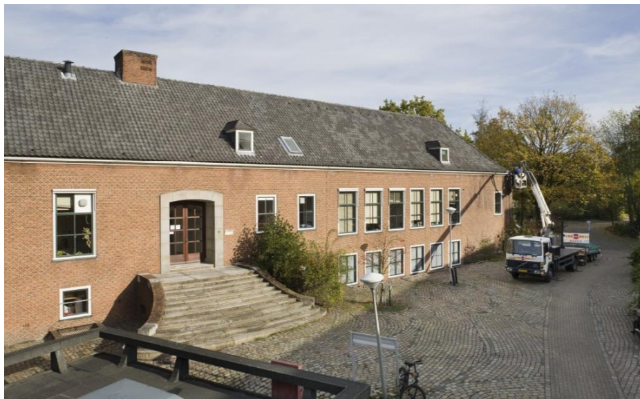
De zuidgevel van het gebouw in 2008. RCE beeldbank, nr. 542.740.
