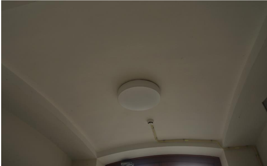
Getoogde plafond boven de vestibule achter de hoofdentree.
