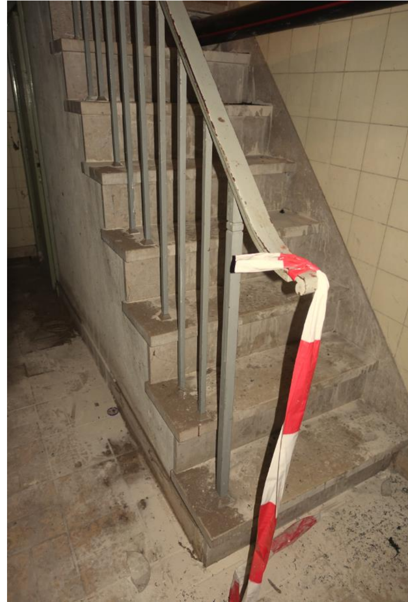
De afwerking van de keldertrap.
