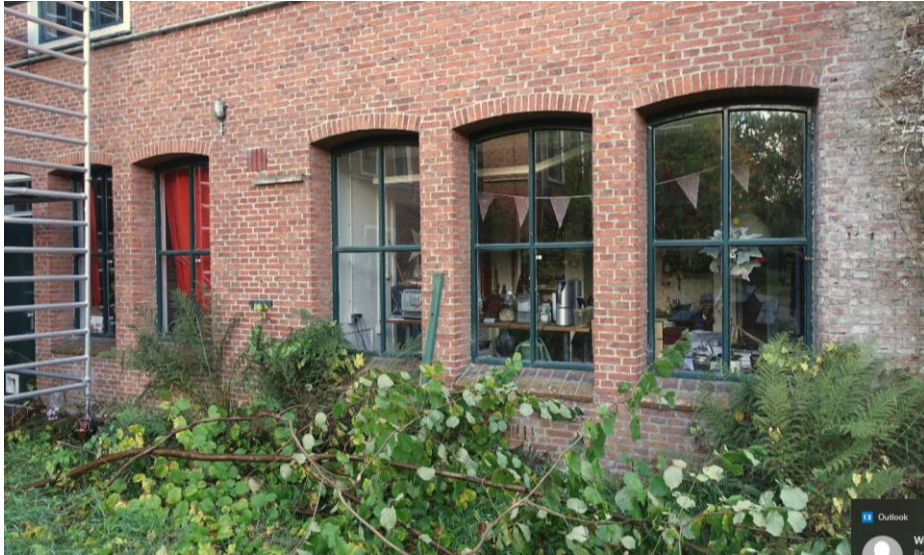
Vensters met getoogde bovenzijden, hier bij de noordgevel van het souterrain van het hoofdgebouw.
