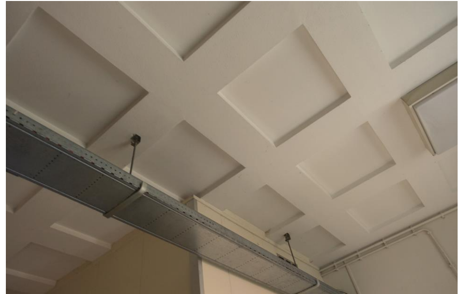
Cassetteplafond boven de hal achter de vestibule op de begane grond.
