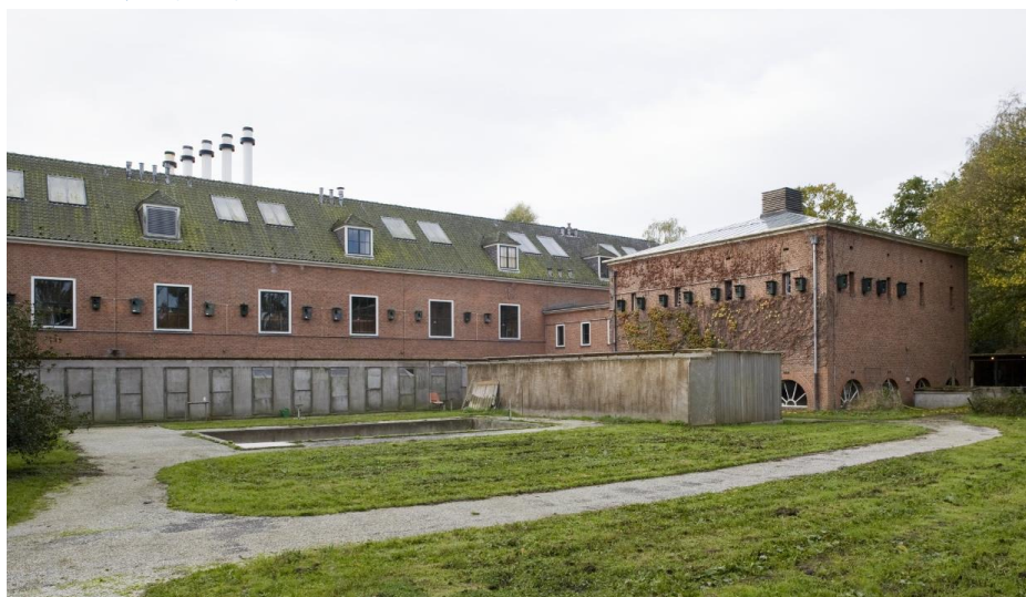
Zicht op het terrein tussen de twee vierkante uitbouwen in 2008. RCE beeldbank, nr. 542.758.
