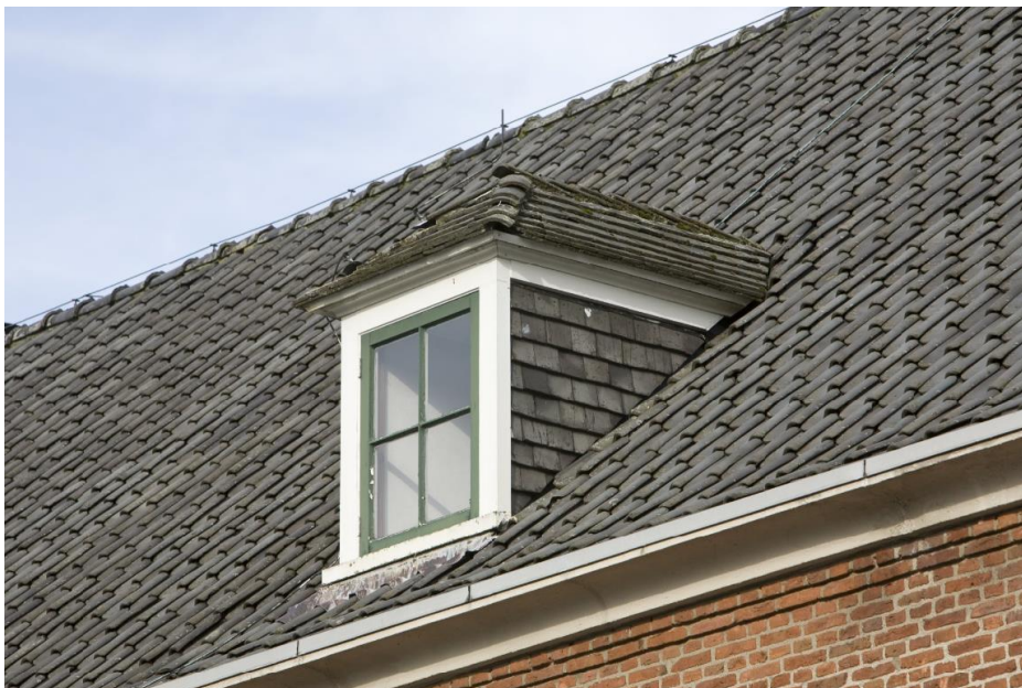
Detail van de dakkapel aan de zuidzijde van het gebouw. RCE beeldbank, nr. 542.742.
