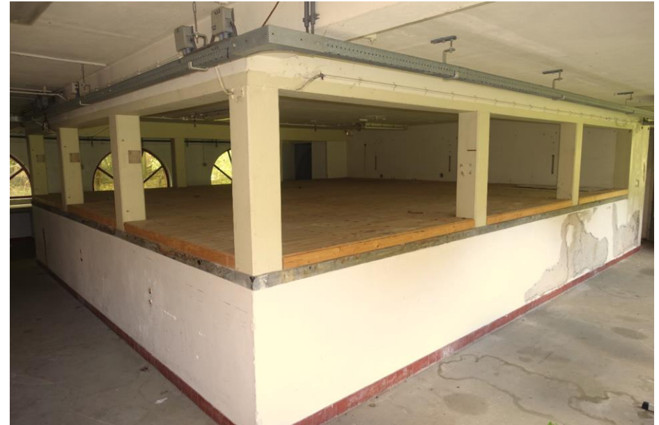
Het aquarium in het souterrain van de westelijke uitbouw.
