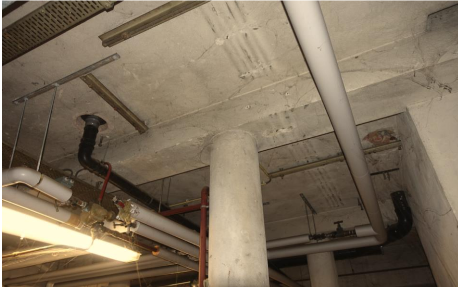
De betonvloer van het souterrain in het hoofdgebouw wordt ter plaatse van de verwamingskelder ondersteund door betonnen kolommen.
