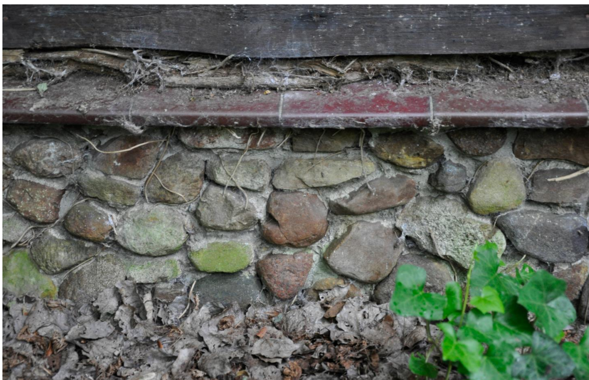
Detailopname van de borstwering gemaakt van veldkeien. Let op de raamdorpelstenen waarmee de bovenkant is afgedekt.
