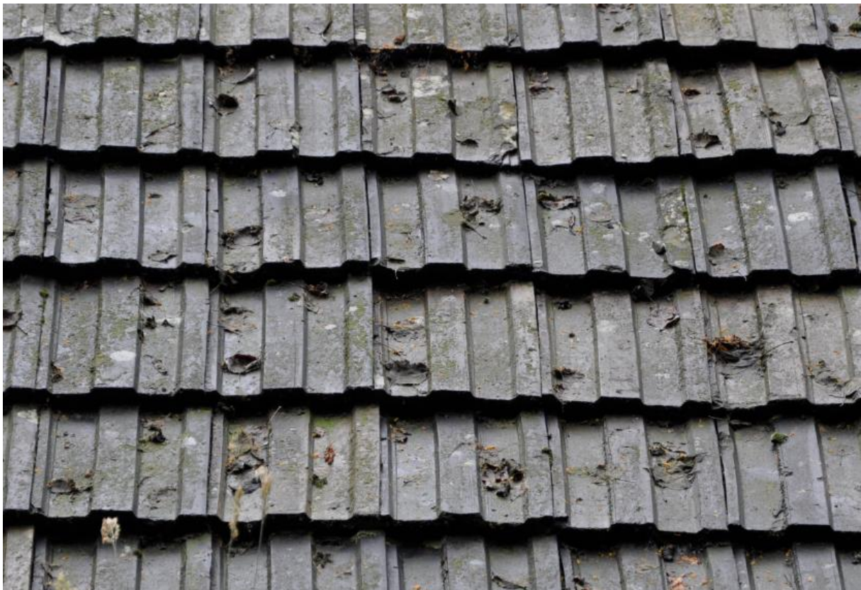
Een gedeelte van het pannendak.
