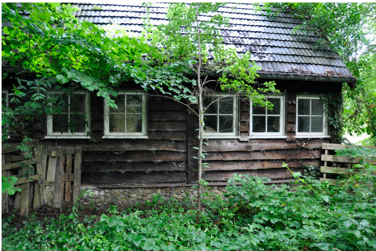
Opname van de linker zijgevel (zuid).
