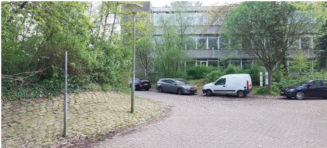
Met steen beklede glooiingen nabij gebouwdeel A.
