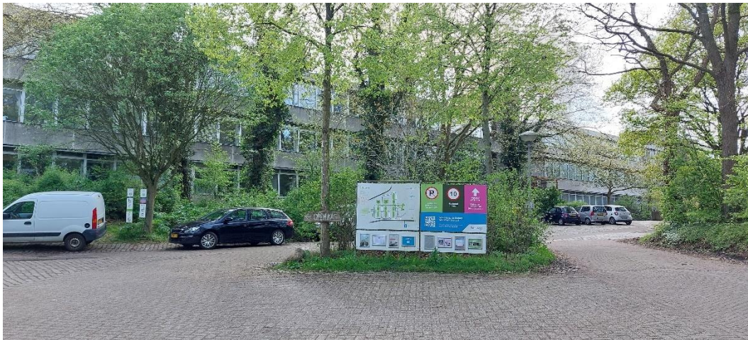
Zicht vanaf de entree op gebouwdeel A.
