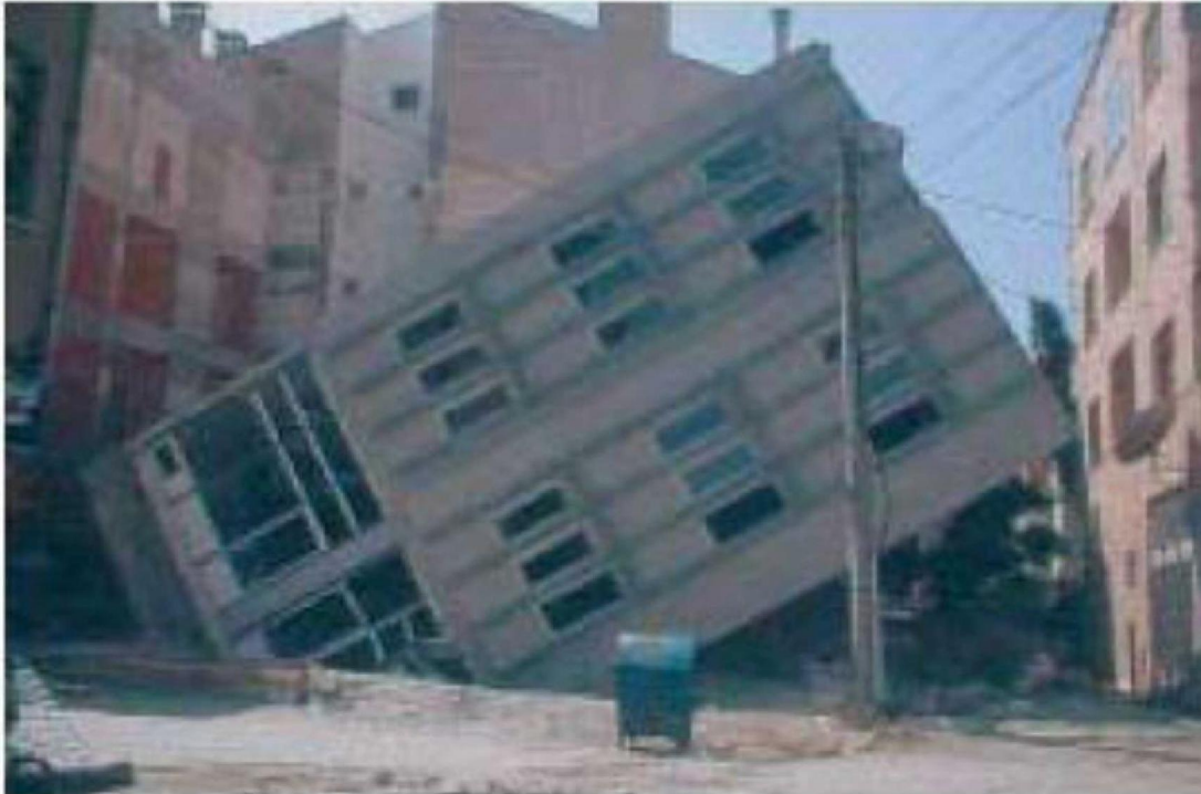
Figuur 5.2 Voorbeeld van liquefaction van onze Turkse collega's (aardbeving 1999 te Adapazari).
