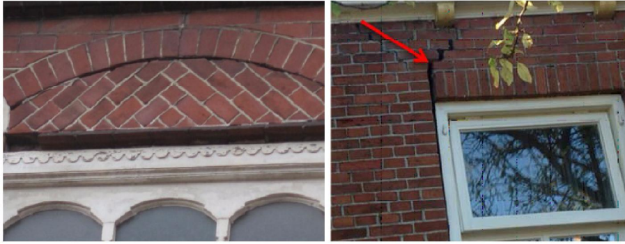
5. Beschadigde gevels door het gebrek aan verankering, doorponsen van elementen.
