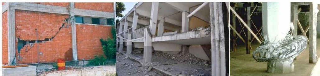
Figuur 5 voorbeelden constructieve risico's
