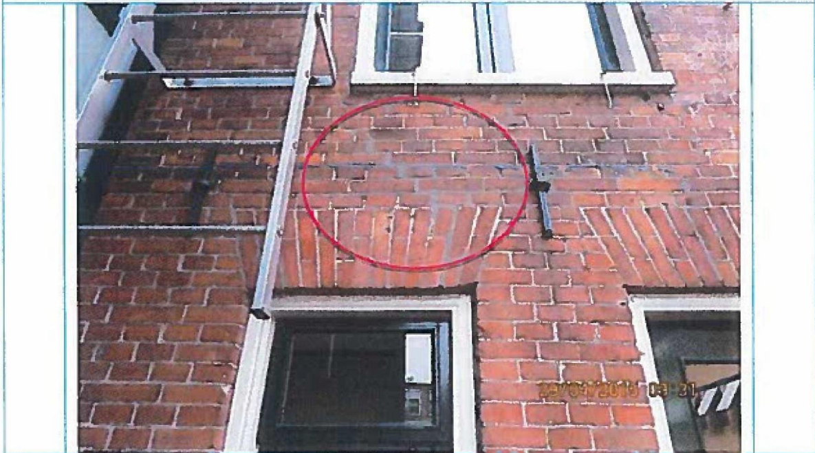
Foto 12. Detail foto 11. Reeds eerder hersteld voegwerk. Geen waarneembare schade.
