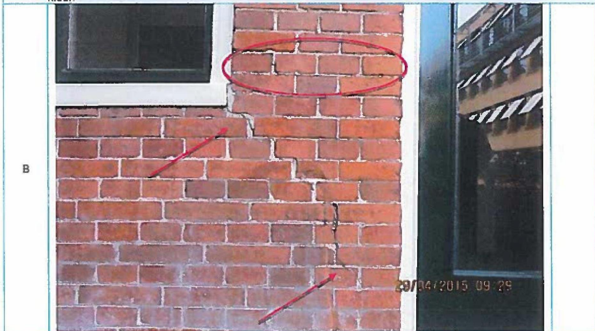
Foto 8. Detail foto 7. Verergerde scheurvorming in metselwerk. Gescheurde voegen diep uitkrabben en opnieuw aanbrengen. Voeg(mortel) toepassen die qua samenstelling, hardheid, kleur en uiterlijk gelijk is als rondom gelegen bestaande voeg.
