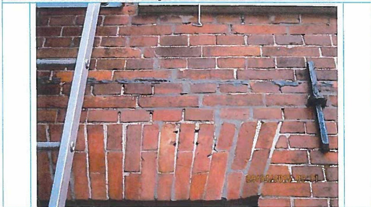
Foto 12. Detail foto 11. Reeds eerder hersteld voegwerk. Geen waarneembare schade.
