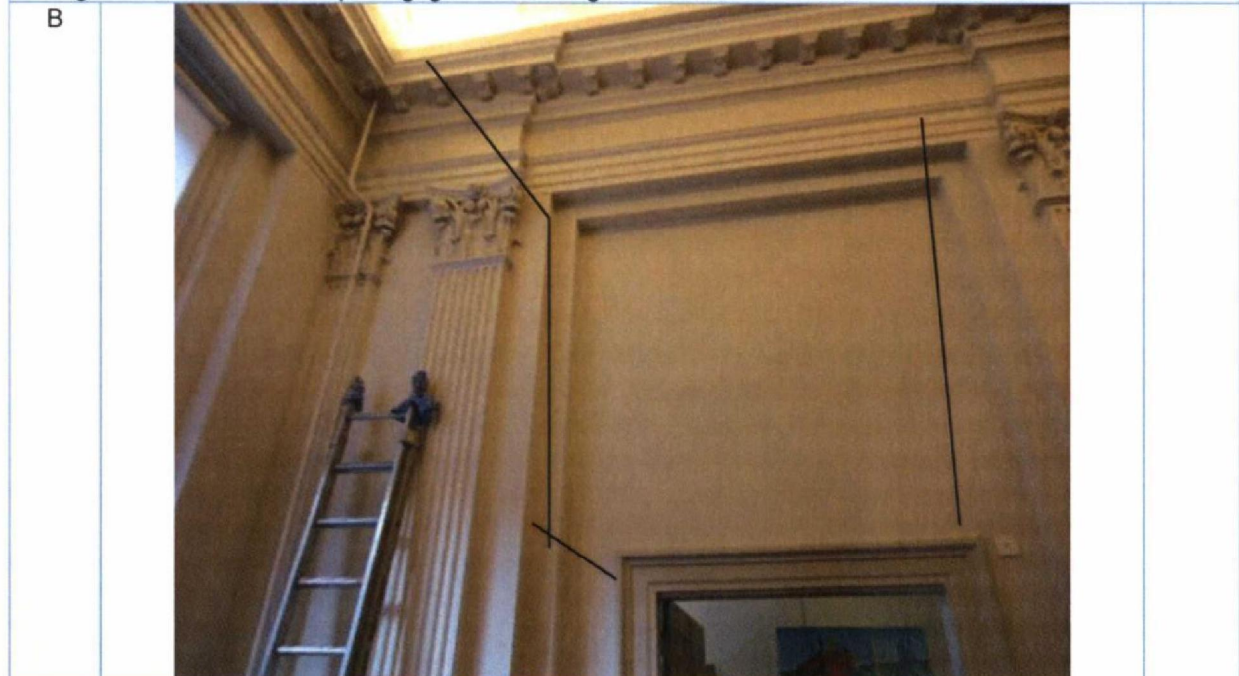
Foto 12: Hal 1 e verdieping. Scheuren in stucwerk. Scheuren uitkappen en loszittend stucwerk verwijderen. Scheur in achterliggend metselwerk herstellen met mortel van gelijke structuur en samenstelling als het omringende metselwerk. Wapeningsgaas aanbrengen en stucwerk en sauswerk herstellen.
