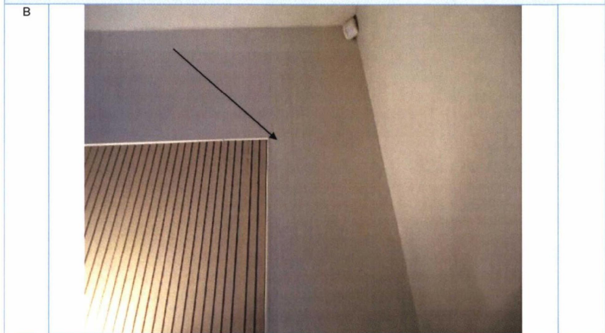
Foto 48: Begane grond. Wachtruimte. Scheuren in stucwerk. Scheuren uitkappen en loszittend stucwerk verwijderen. Scheur in achterliggend metselwerk herstellen met mortel van gelijke structuur en samenstelling als het omringende metselwerk. Wapeningsgaas aanbrengen en stucwerk en sauswerk herstellen.
