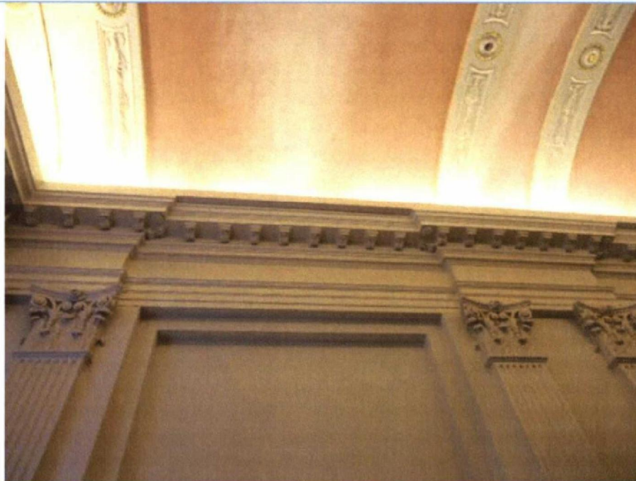
Foto 16: Hal 1 e verdieping. Sierlijst. Horizontale scheuren in stucijst. Geen verband met bodem trillingen.
