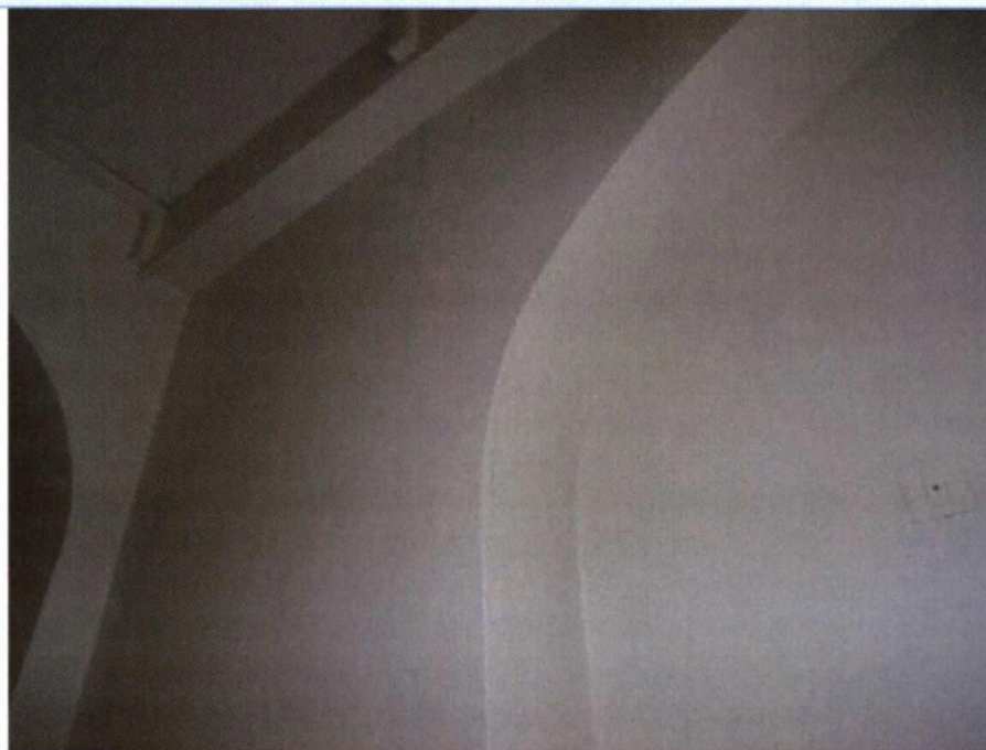
Foto 38: Scheuren bij overgang plafond-wand. Geen verband met bodemtrillingen.
