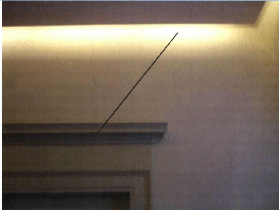
Foto 28: Hal 2 o verdieping. Scheuren in stucwerk. Scheuren uitkappen en loszittend stucwerk verwijderen. Scheur in achterliggend metselwerk herstellen met mortel van gelijke structuur en samenstelling als het omringende metselwerk. Wapeningsgaas aanbrengen en stucwerk en sauswerk herstellen.
