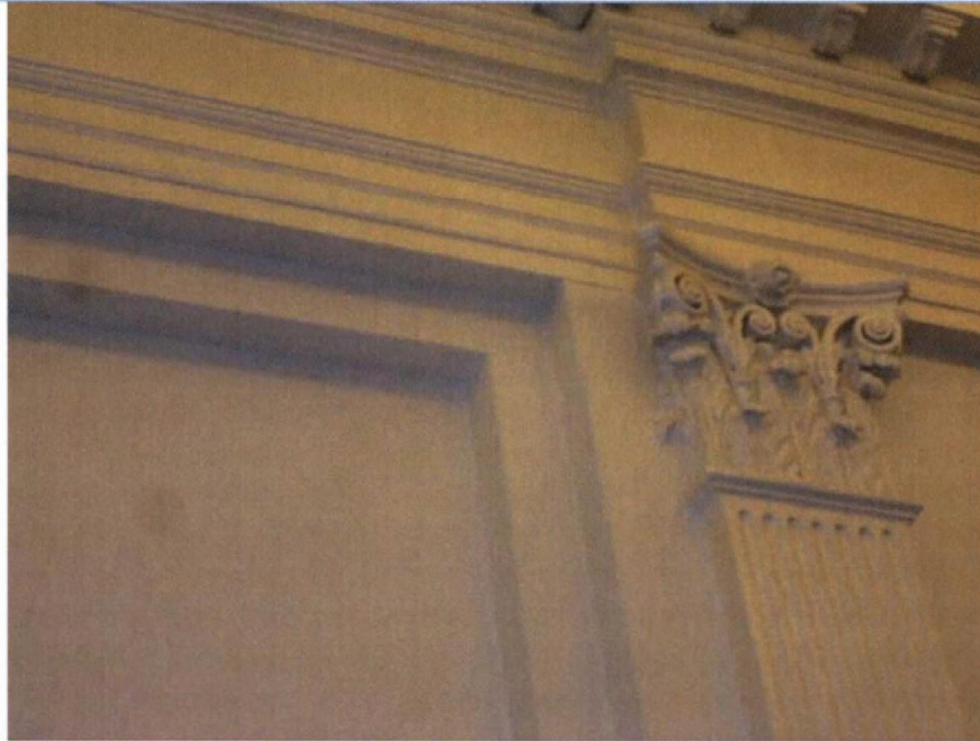
Foto 16: Hal 1 e verdieping. Sierlijst. Horizontale scheuren in stucijst. Geen verband met bodem trillingen.
