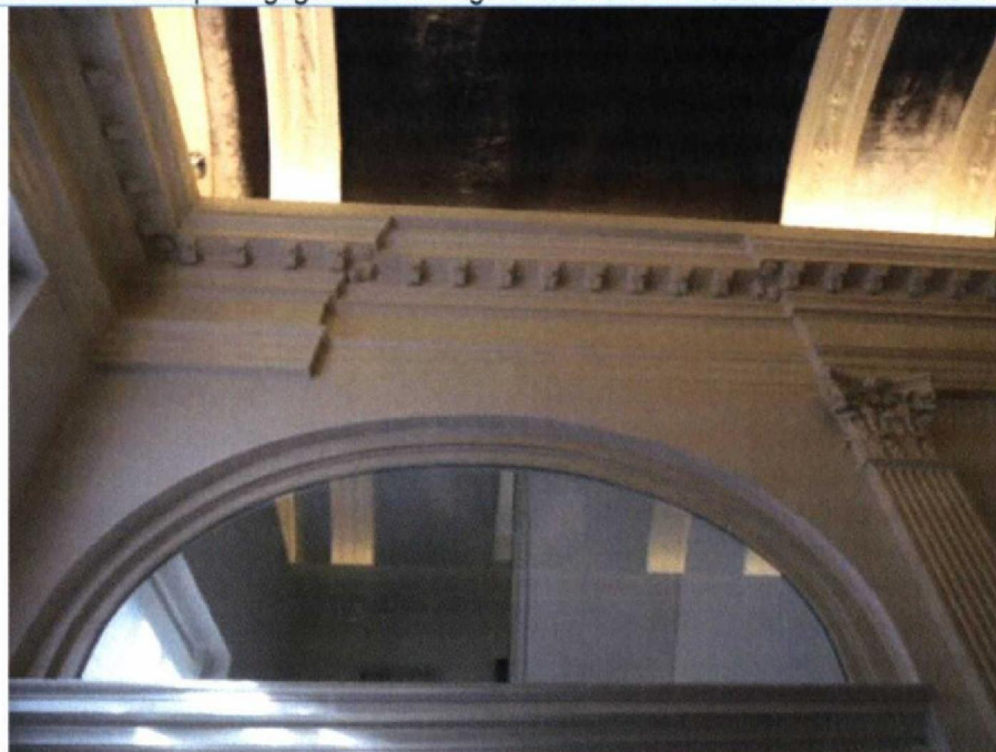
Foto 2: Hal 1 e verdieping. Scheuren in stucwerk. Scheuren uitkappen en loszittend stucwerk verwijderen. Scheur in achterliggend metselwerk herstellen met mortel van gelijke structuur en samenstelling als het omringende metselwerk. Wapeningsgaas aanbrengen en stucwerk en sauswerk herstellen.
