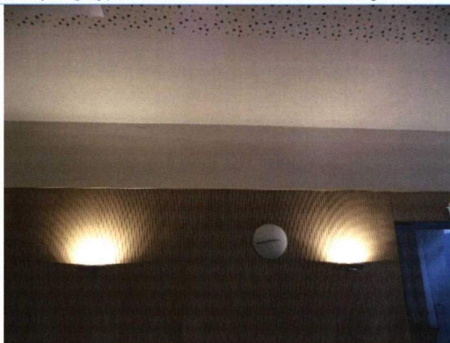
Foto 38: Scheuren bij overgang plafond-wand. Geen verband met bodemtrillingen.
