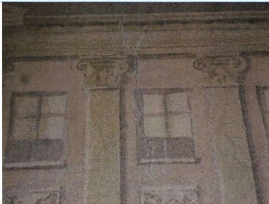
Foto 58: Scheuren in stucwerk. Scheuren uitkappen en loszittend stucwerk verwijderen. Scheur in achterliggend metselwerk herstellen met mortel van gelijke structuur en samenstelling als het omringende metselwerk. Wapeningsgaas aanbrengen en stucwerk en sauswerk herstellen.
