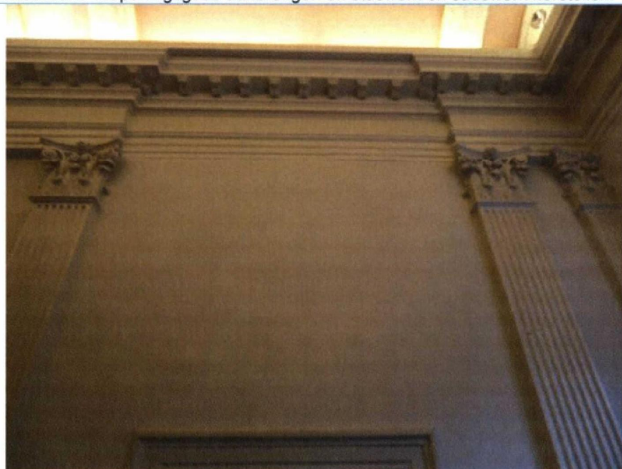
Foto 18: Hal 1 e verdieping. Scheuren in stucwerk. Scheuren uitkappen en loszittend stucwerk verwijderen. Scheur in achterliggend metselwerk herstellen met mortel van gelijke structuur en samenstelling als het omringende metselwerk. Wapeningsgaas aanbrengen en stucwerk en sauswerk herstellen.
