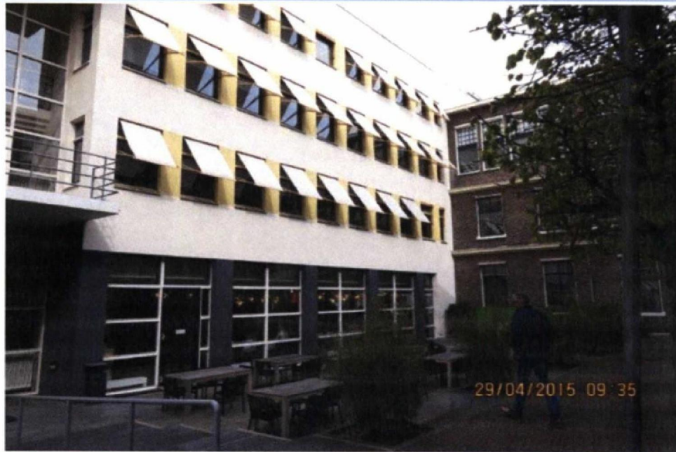
Foto 5. Linker zijgevel. Geen waarneembare schade.
