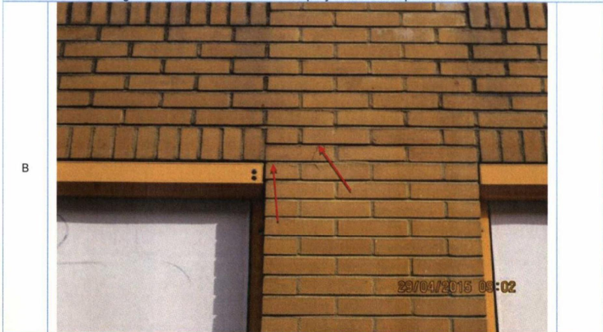
Foto 12. Verergerde scheurvorming in metselwerk. Gescheurde voegen diep uitkrabben en opnieuw aanbrengen. Voeg(mortel) toepassen die qua samenstelling, hardheid, kleur en uiterlijk gelijk is als rondom gelegen bestaande voeg. Gebroken stenen herstellen met epoxy vulmateriaal op kleur.
