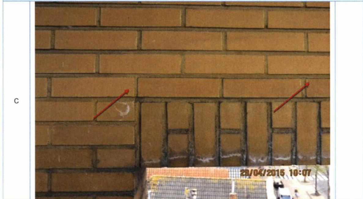
Foto 44. Verdere vervolg scheurvorming in voegen.
