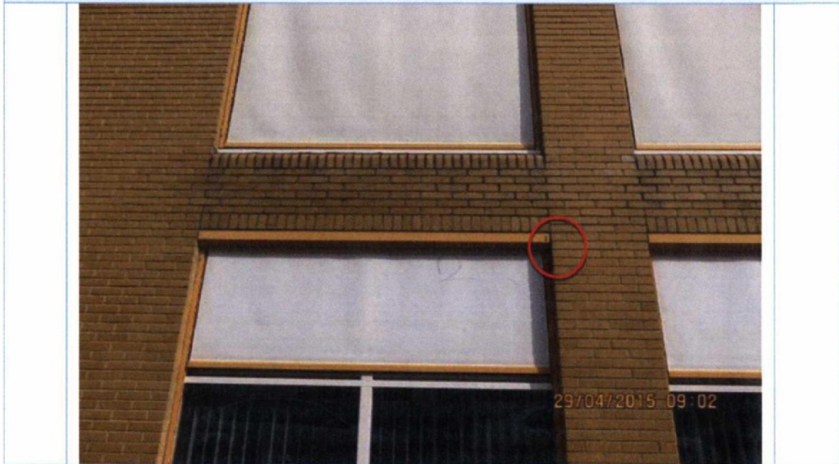
Foto 12. Verergerde scheurvorming in metselwerk. Gescheurde voegen diep uitkrabben en opnieuw aanbrengen. Voeg(mortel) toepassen die qua samenstelling, hardheid, kleur en uiterlijk gelijk is als rondom gelegen bestaande voeg. Gebroken stenen herstellen met epoxy vulmateriaal op kleur.
