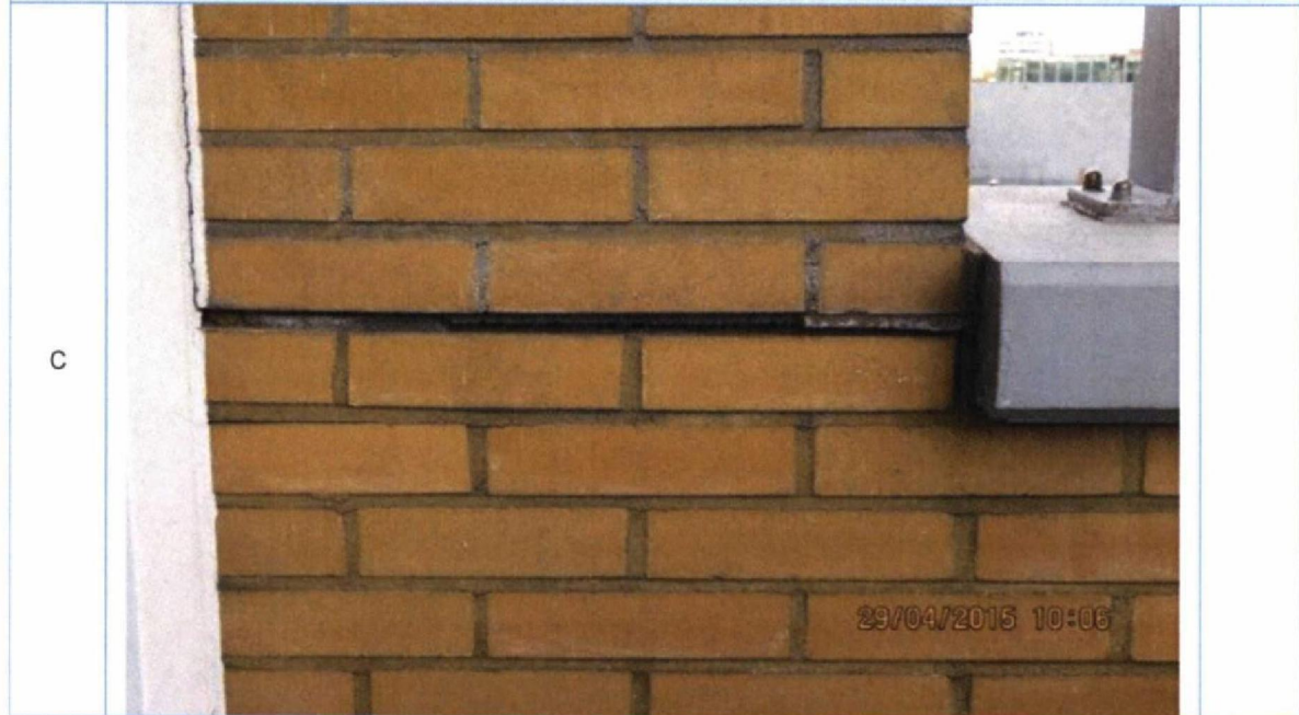
Foto 42. Scheurvorming in voegen. Geen gerelateerde bevestigsschade.
