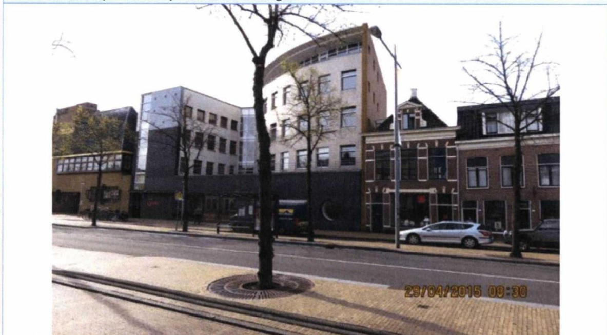
Overzicht / Gedempte Zuiderdiep 98 9711 HL Groningen
