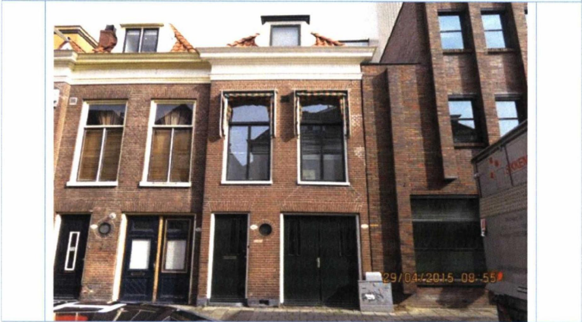
Foto 2. Reeds eerder hersteld voegwerk. Geen waarneembare schade.
