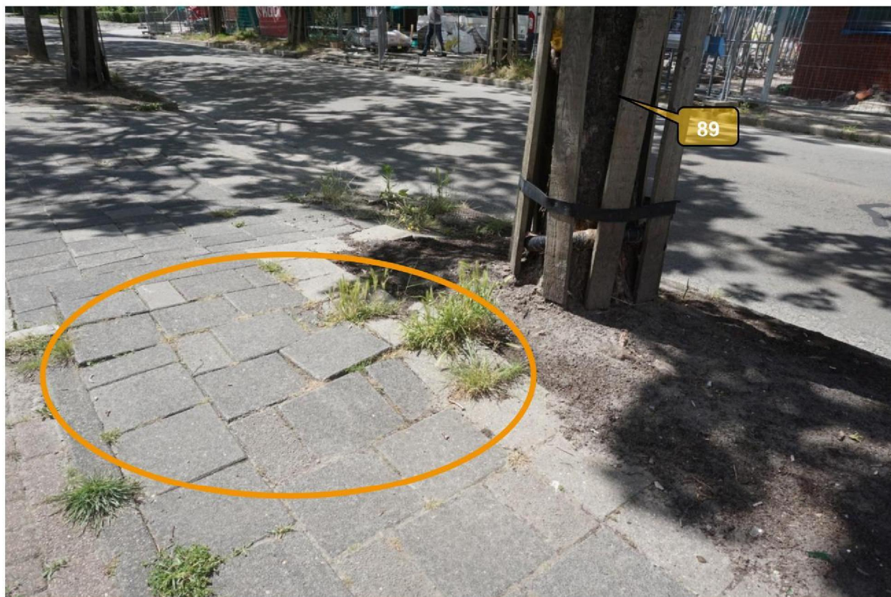
Foto 15: Ernstige opdruk van de verharding van de stoep bij de esdoorn met boomnummer 89 in de Jullensstraat, aangegeven met oranje cirkel.
