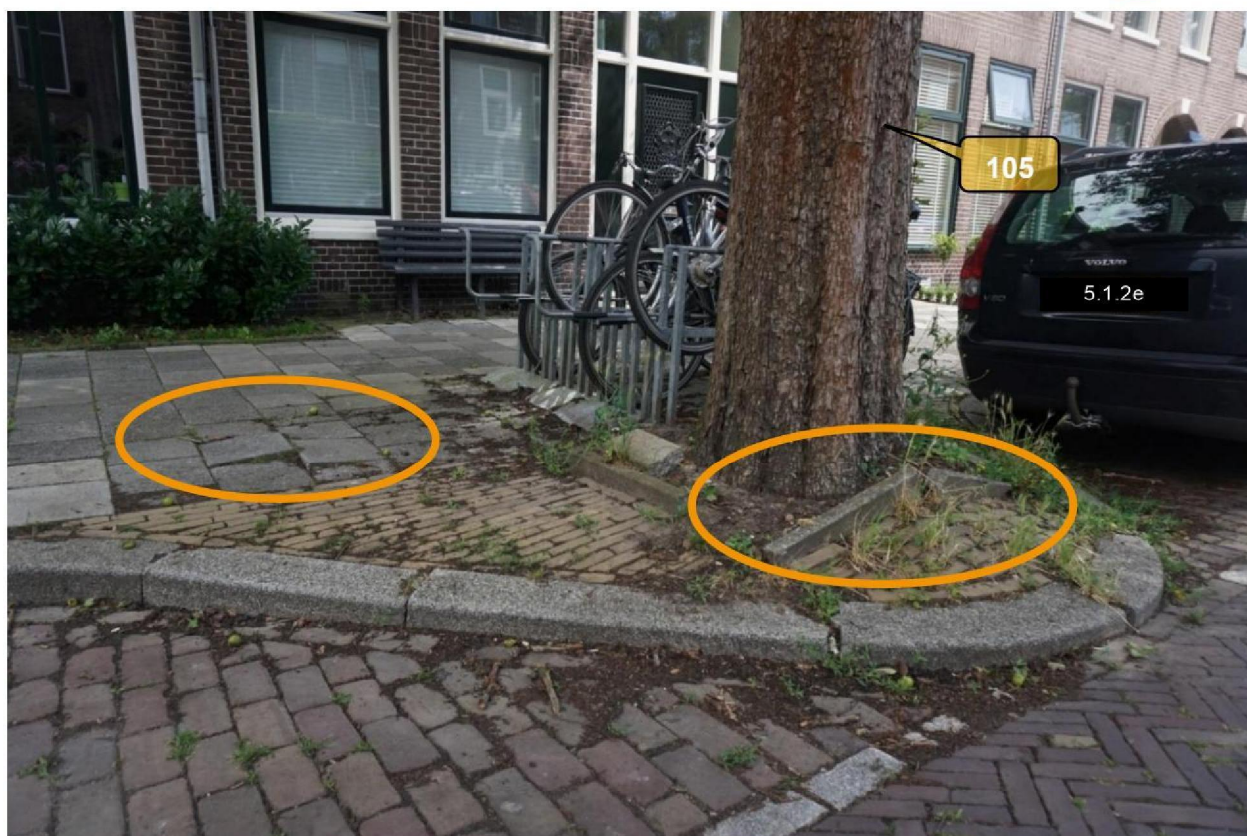
Foto 14: Ernstige opdruk van de verharding bij de peer met boomnummer 105 in de Helper Weststraat, aangegeven met oranje cirkels.
