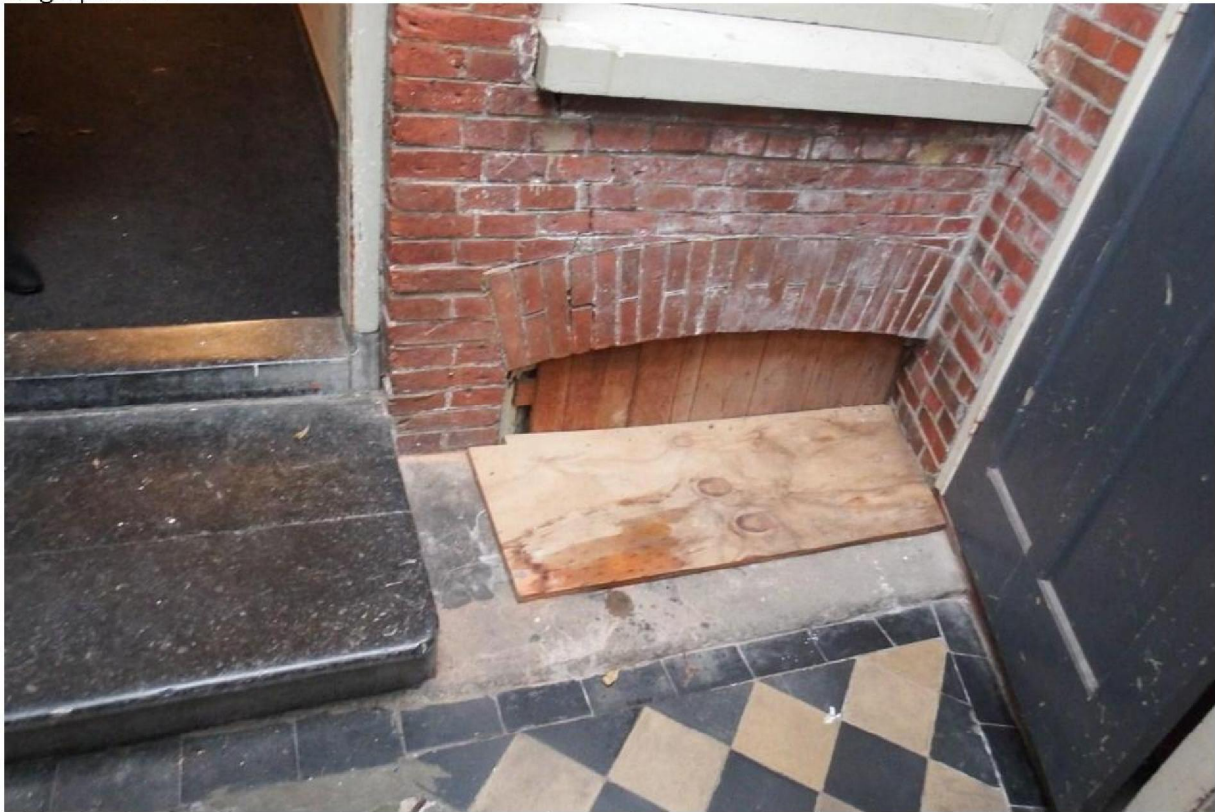
Afb. 26: Gedeelte van de achtergevel van bouwdeel A in bouwdeel B (serre). Centraal het afgeplate kelderlicht met daarboven de dorpel van het keukenvenster. Links de hardstenen stoep voor de deuropening naar de gang; rechts de paneeldeur naar het toilet.
