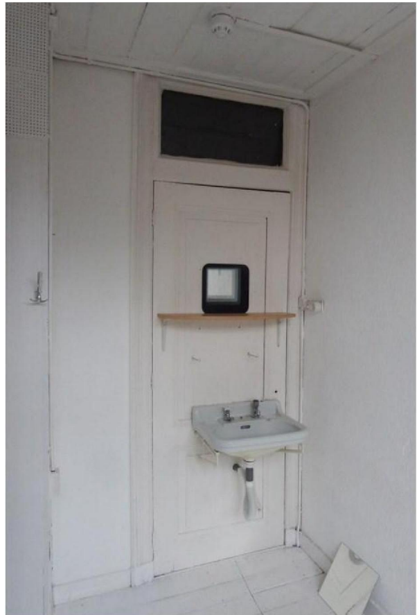
Afb. 31: Gaskachel met aansluiting op de hangschouw in KAMER 4 (links). Deurkozijn met bovenlicht en paneeldeur in het rechter gedeelte van KAMER 6 die ooit toegankelijk was vanaf de overloop. Aan de zijde van de overloop is deze deur niet zichtbaar door beplating.
