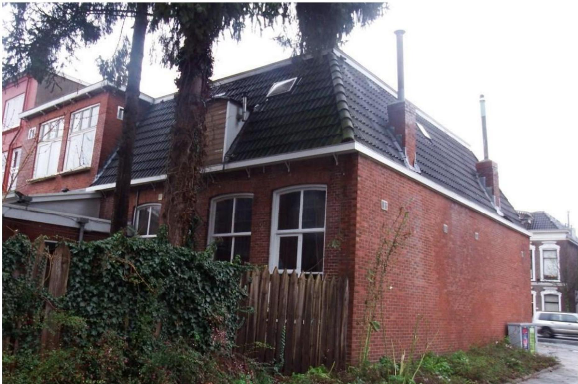
Afb. 22: Zuidelijke zijgevel en aansluitende achtergevel van huisnummer 61. Geheel links de bouwdelen C, B en het dakhuis van bouwdeel A behorende bij huisnummer 59.
