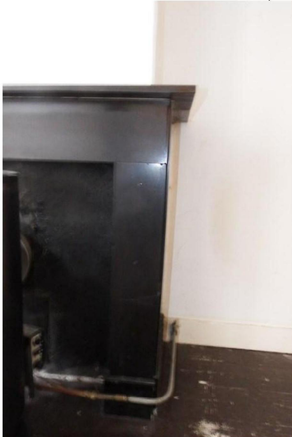
Afb. 29: Eenvoudige omlijsting stookplaats in zwart natuursteen (links). Ingebouwde kast (alkoof) waarin de zoldertrap is geplaatst. Dubbele deuren zijn in de ruimte vlak; kastzijde gepaneeld met klampen en spiegelklampen (rechts).
