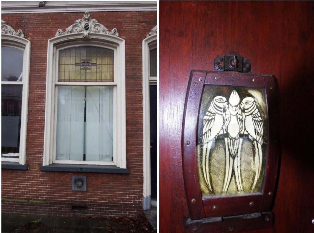
Afb. 21: 2-ruits schuifvenster van huisnummer 59 met omlijsting en bovenlicht voorzien van glas in lood (links). Loket in paneeldeur van huisnummer 59 met gebrandschilderde papegaaien (rechts).
