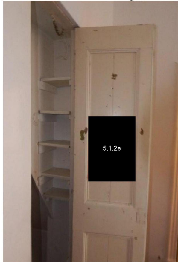
Afb. 29: Eenvoudige omlijsting stookplaats in zwart natuursteen (links). Ingebouwde kast (alkoof) waarin de zoldertrap is geplaatst. Dubbele deuren zijn in de ruimte vlak; kastzijde gepaneeld met klampen en spiegelklampen (rechts).
