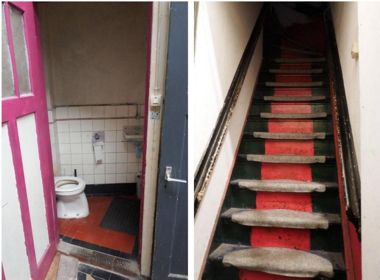
Afb. 27: Toiletruimte van huisnummer 59 met betegelde vloer en gedeeltelijk betegelde wand met sierstrip (links). Trap naar de zolder met geschilderde loper (rechts).
