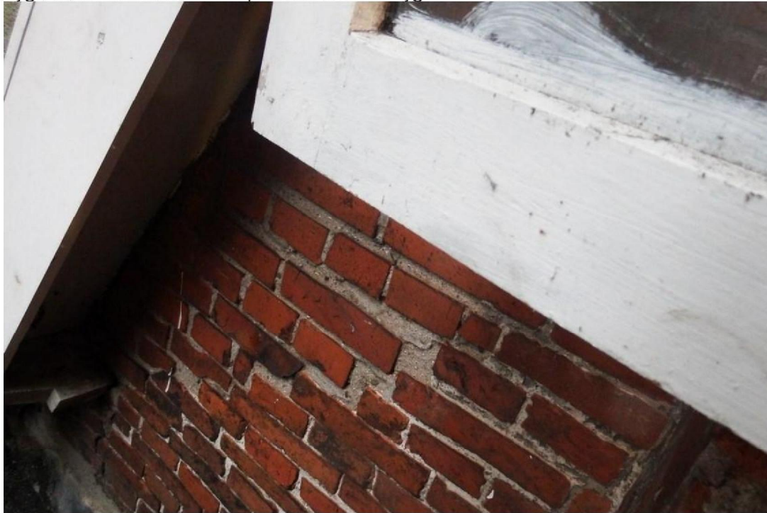
Afb. 13: Achtergevel onder dakschild van rechter zijgevel en diezelfde gevel van het dakhuis met twee verschillende soorten metselwerk, waarin een diagonale aansluiting is te herkennen
