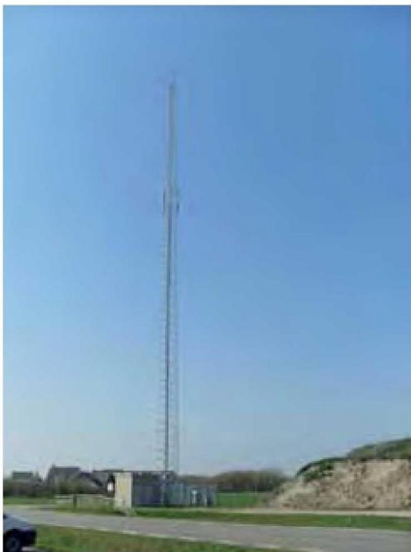
Figuur 3.28 C2000 mast (voorbeeld)
