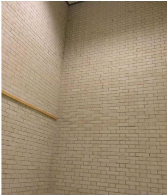
Figuur 22 Hoge metselwerk wand in ruimte kb 05
