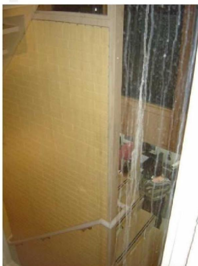
Figuur 23: Vrijstaande halfsteens muur in schalmgat van trap
