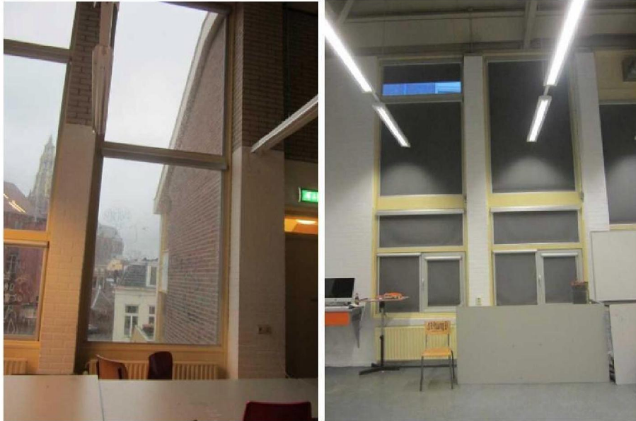
Figuur 21 Hoge metselwerk penanten tbv steunen kozijnen
