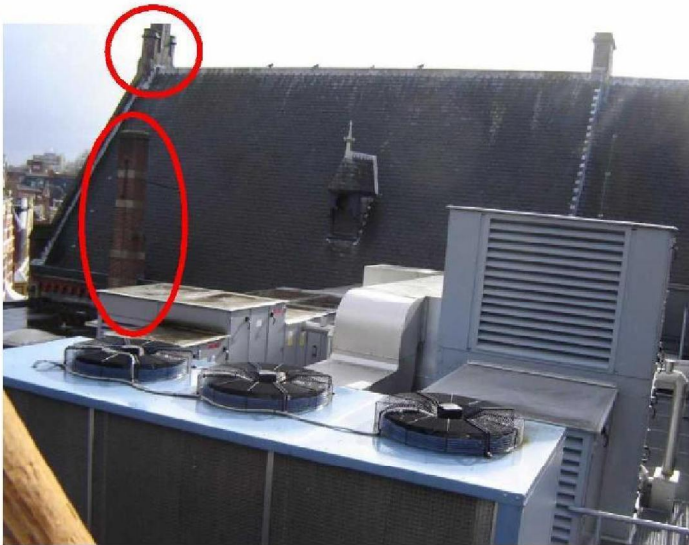
Figuur 17: Gemetselde schoorstenen
