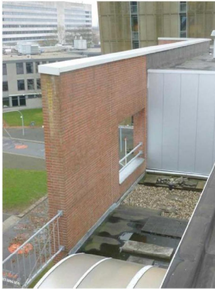
Figuur 3: Ommetselde vrijstaande stalen frames
