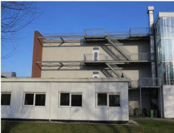
Figuur 2: Vrijstaand afzuigkanaal op het dak
