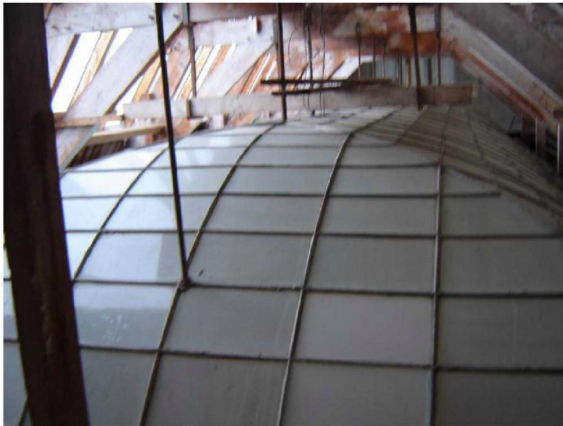
Figuur 20: Bovenkant glazen plafondkoepel expositieruimte, links is de lichtstraat van draadglasplaten te zien
