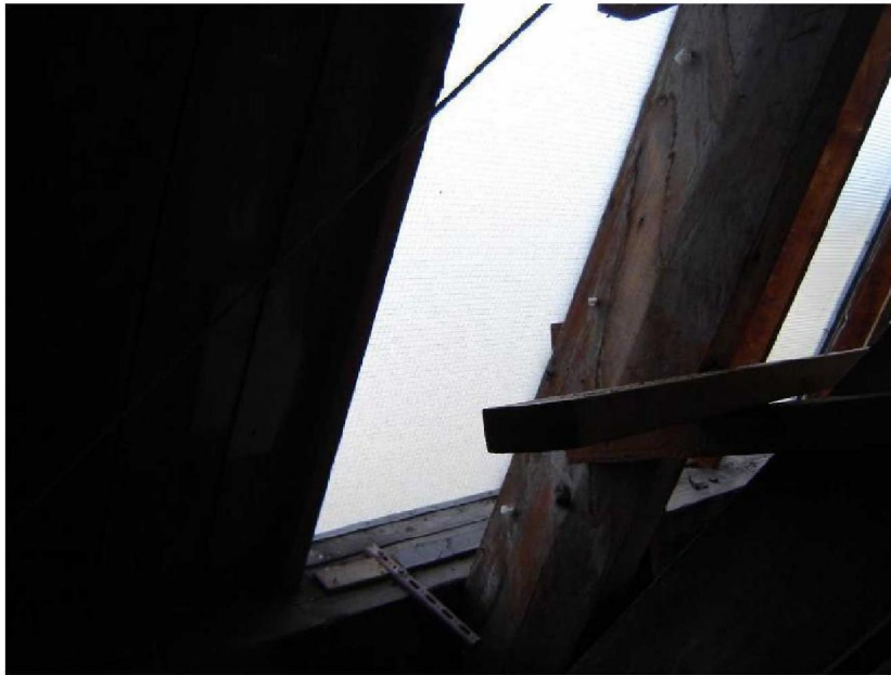
Figuur 19: Lichtstraat van draadglasplaten van binnenuit gezien
