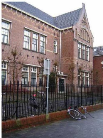
Figuur 8: Niet gesteunde metselwerk delen en aan de topgevel
