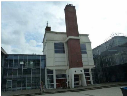
Figuur 24 Schoorsteen Wiebenga
