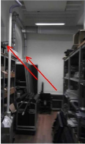
Figuur 12: Metselwerk kolommen begane grond
