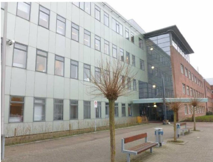
Figuur 6: Stalen luifel t.p.v. de entree
