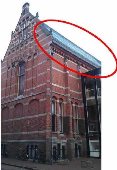
Figuur 18: Lichtstraat van draadglasplaten
