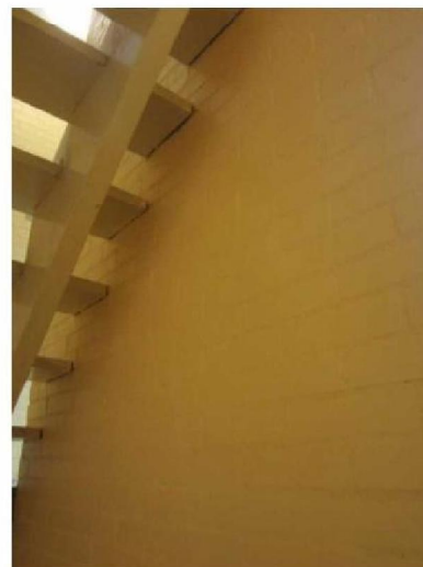
Figuur 23: Vrijstaande halfsteens muur in schalmgat van trap
