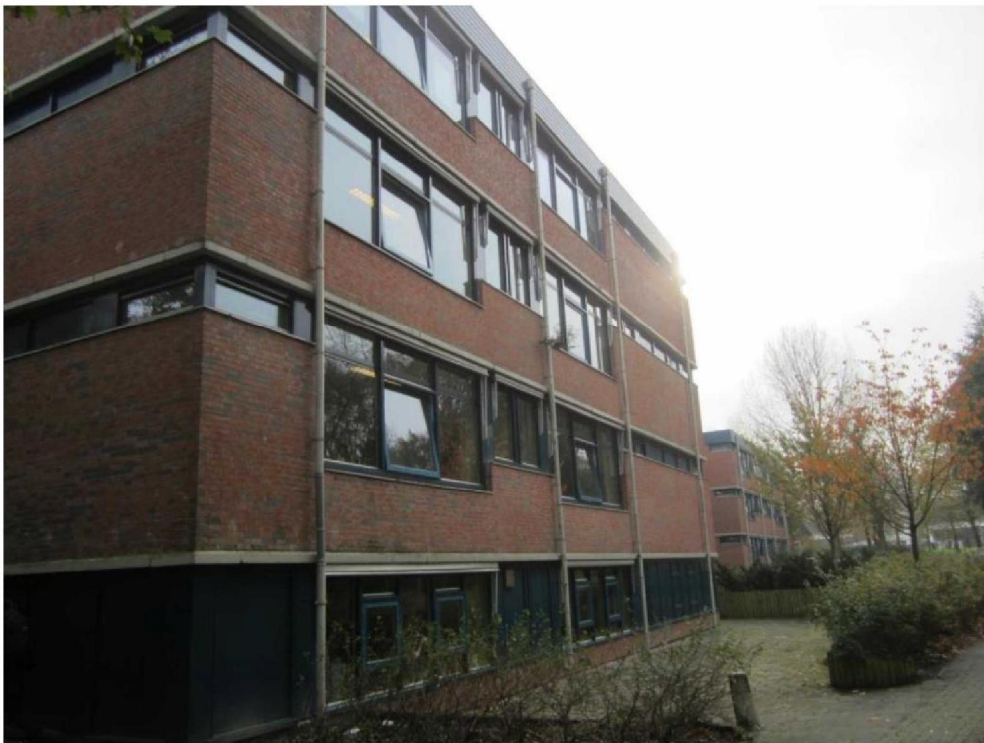
Foto B2: Overzicht Westgevel.
