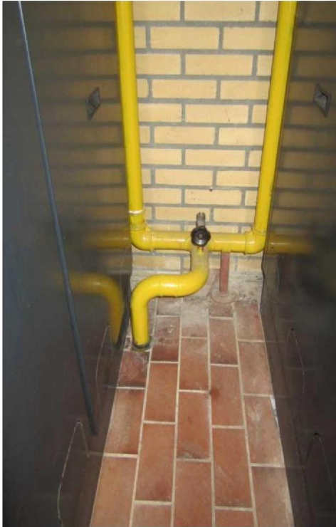
Foto B13: Gas en verwarmingsleidingen door beganegrondvloer.
