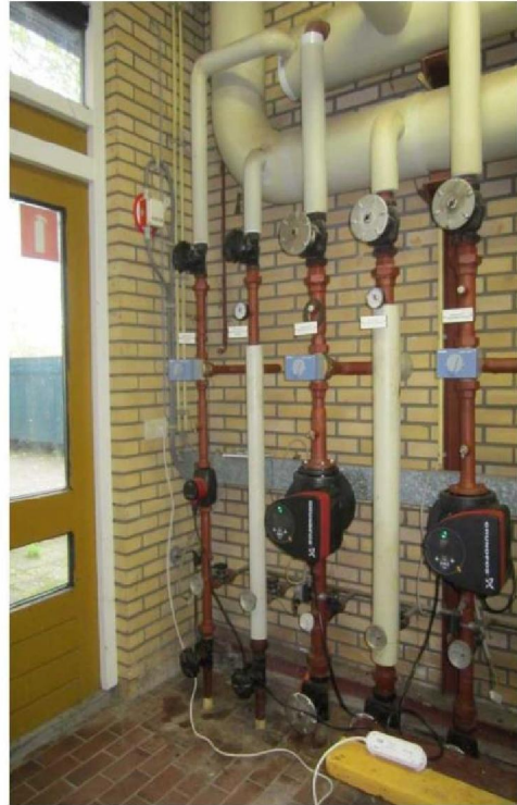
Foto B13: Gas en verwarmingsleidingen door beganegrondvloer.
