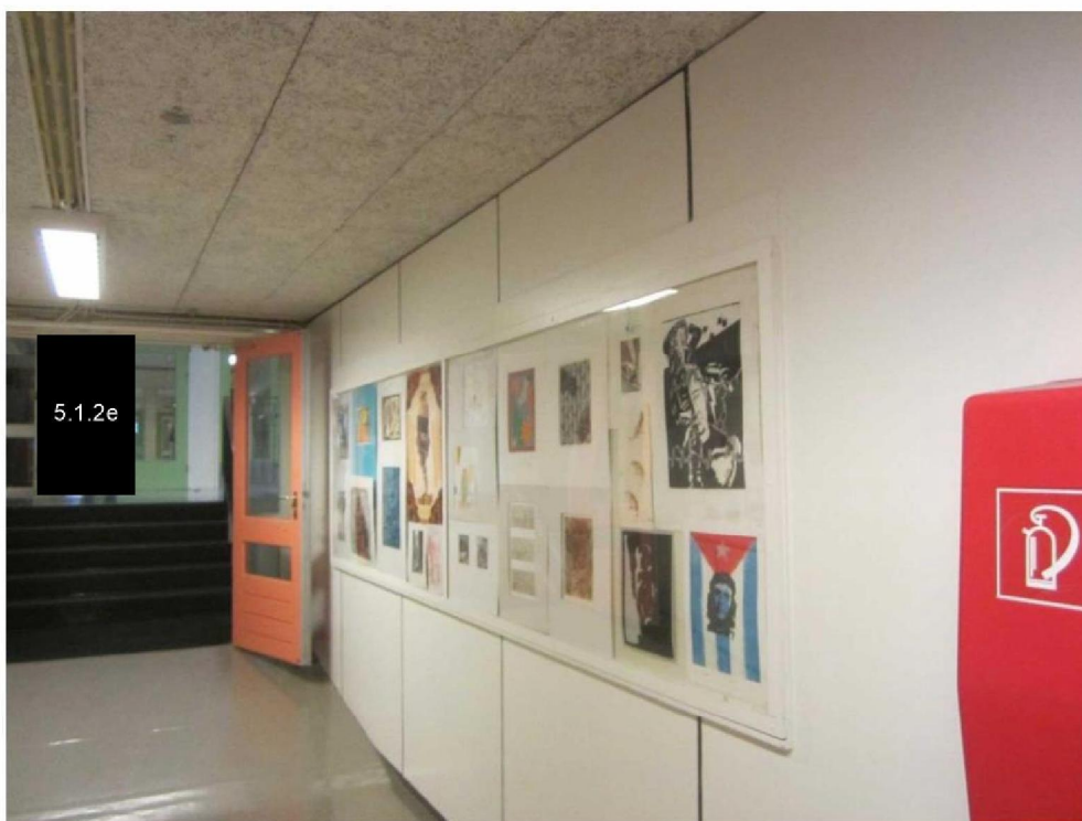
Foto B10: Paneelwanden en houtwolcement platen plafond, kelder.
