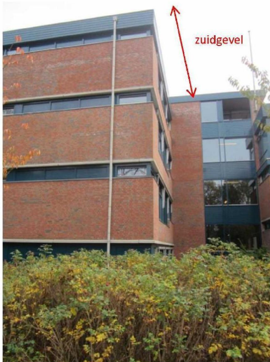
Foto B3: Overzicht Zuidgevel.
