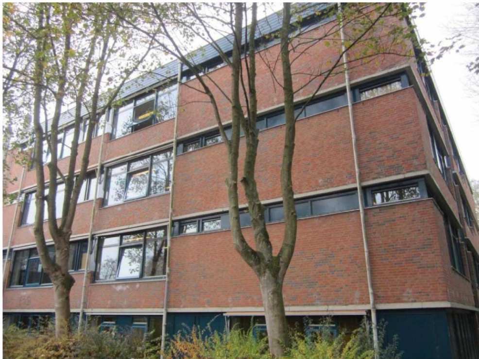
Foto B4: Overzicht Oostgevel.
