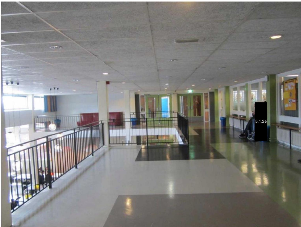
Foto C6: Vide in de aula (aangrenzend bouwdeel).
