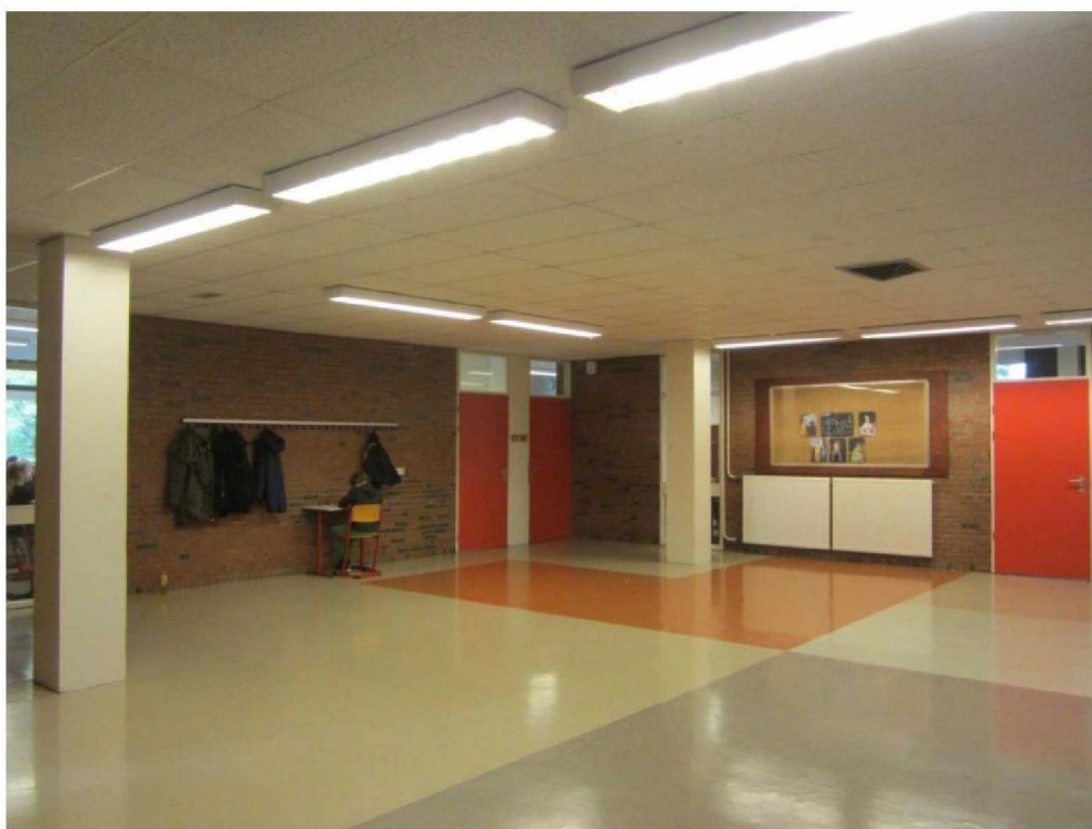
Foto B9: Gemetselde niet dragende binnenwanden.
