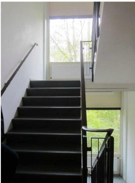
Foto C2: Trappenhuis tussen de betonnen stabiliteitswanden.
