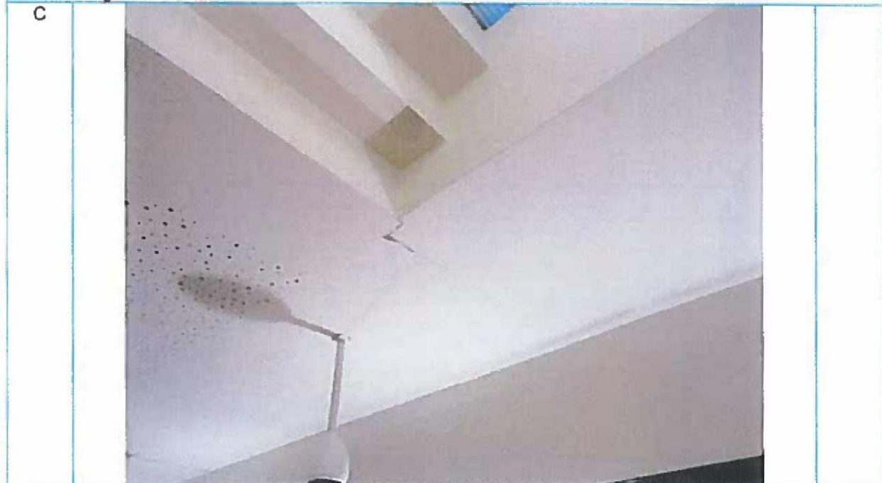
Foto 44: Scheuren in het plafond bij de aansluitingen van de plafondplaten onderling. Geen verband met bodemtrillingen.
