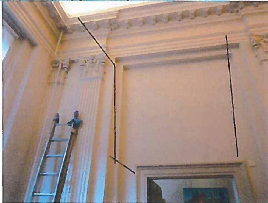
Foto 12: Hal 1 de verdieping. Scheuren in stucwerk. Scheuren uitkappen en loszittend stucwerk verwijderen. Scheur in achterliggend metselwerk herstellen met mortel van gelijke structuur en samenstelling als het omliggende metselwerk. Wapeningsgaas aanbrengen en stucwerk en sauswerk herstellen.
