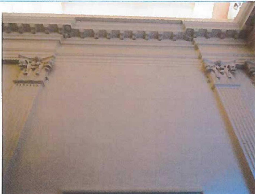
Foto 22: Raadzaal. Scheuren in tableau. Herstel door restauratieschilder.
