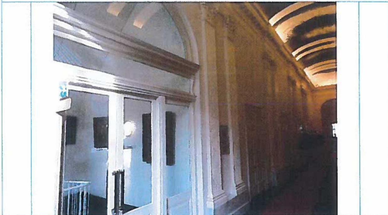
Foto 6: Kamer van de burgemeester. Scheuren in stucwerk. Scheuren uitkappen en loszittend stucwerk verwijderen. Scheur in achterliggend metselwerk herstellen met mortel van gelijke structuur en samenstelling als het omringende metselwerk. Wapeningsgaas aanbrengen en stucwerk en sauswerk herstellen.
