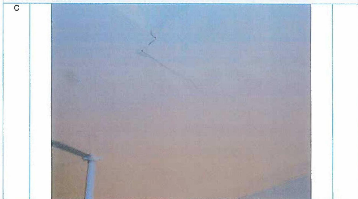
Foto 46: Scheuren in stucwerk. Scheuren uitkappen en loszittend stucwerk verwijderen. Scheur in achterliggend metselwerk herstellen met mortel van gelijke structuur en samenstelling als het omringende metselwerk. Wapeningsgaas aanbrengen en stucwerk en sauswerk herstellen.
