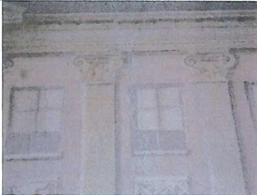
Foto 58: Scheuren in stucwerk. Scheuren uitkappen en loszittend stucwerk verwijderen. Scheur in achterliggend metselwerk herstellen met mortel van gelijke structuur en samenstelling als het omringende metselwerk. Wapeningsgaas aanbrengen en stucwerk en sauswerk herstellen.
