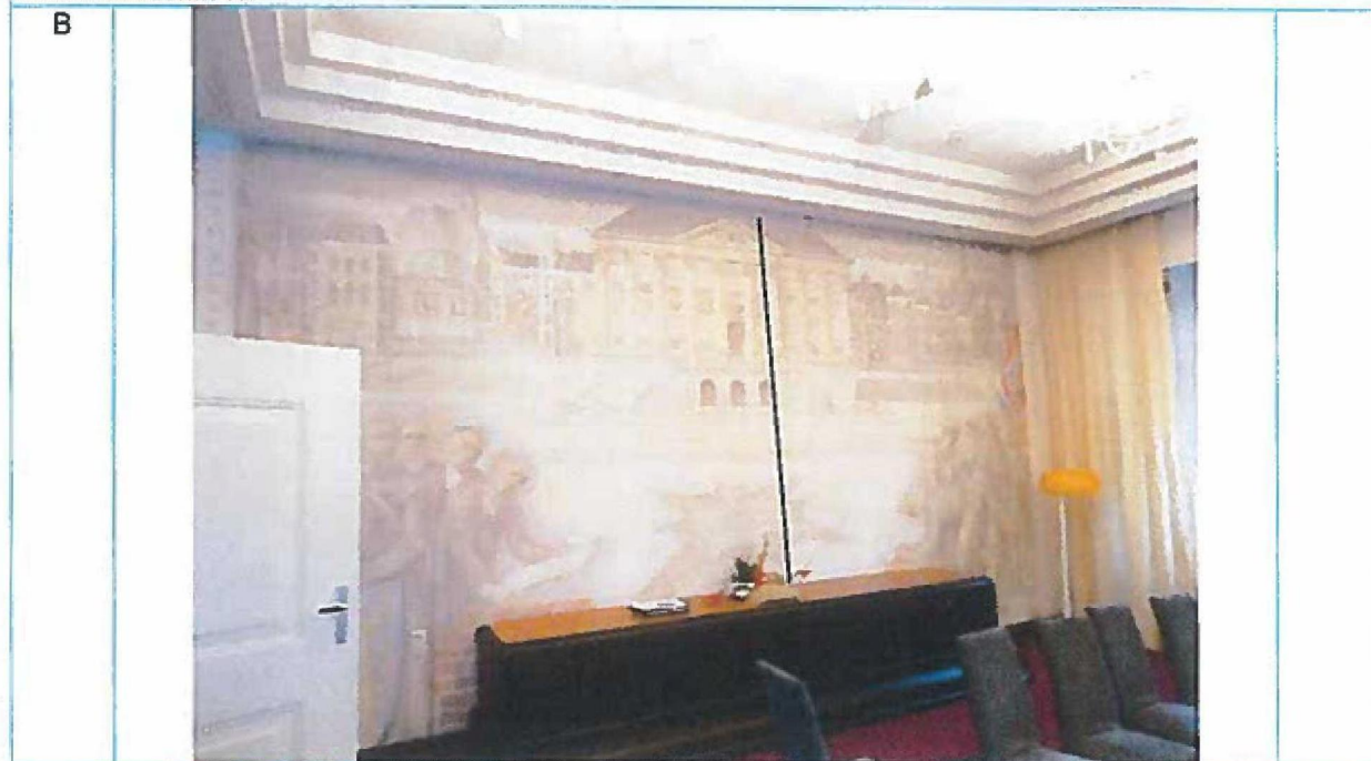
Foto 52: Begane grond . Trouwzaal. Scheur in wand overeenkomstig met scheur foto 48. Herstel door restauratieschilder.
