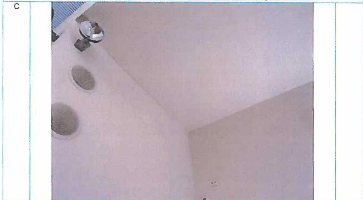
Foto 44: Scheuren in het plafond bij de aansluitingen van de plafondplaten onderling. Geen verband met bodemtrillingen.
