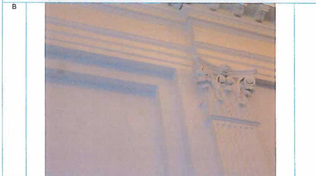
Foto 16: Hal 1 e verdieping. Sierlijst. Horizontale scheuren in stuclijst. Geen verband met bodem trillingen.
