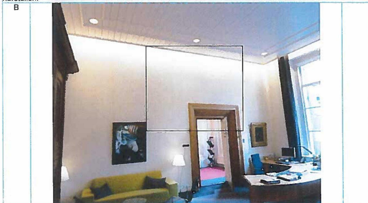
Foto 6: Kamer van de burgemeester. Scheuren in stucwerk. Scheuren uitkappen en loszittend stucwerk verwijderen. Scheur in achterliggend metselwerk herstellen met mortel van gelijke structuur en samenstelling als het omringende metselwerk. Wapeningsgaas aanbrengen en stucwerk en sauswerk herstellen.
