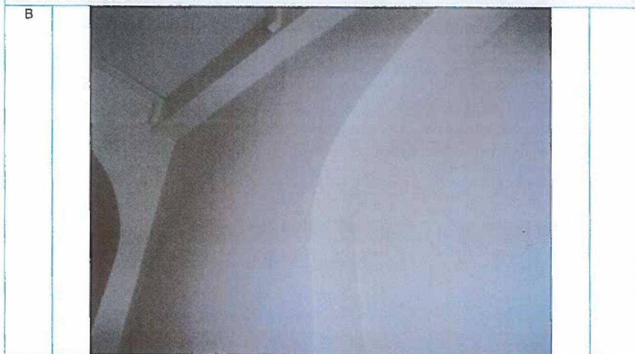
Foto 38: Scheuren bij overgang plafond-wand. Geen verband met bodemtrillingen.
