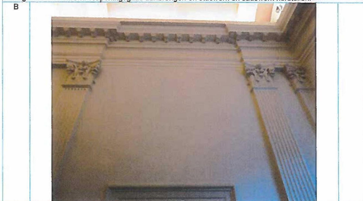
Foto 18: Hal 1 e verdieping. Scheuren in stucwerk. Scheuren uitkappen en loszittend stucwerk verwijderen. Scheur in achterliggend metselwerk herstellen met mortel van gelijke structuur en samenstelling als het omringende metselwerk. Wapeningsgaas aanbrengen en stucwerk en sauswerk herstellen.
