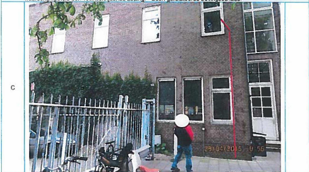
Foto 39. Verloop scheurvorming.
