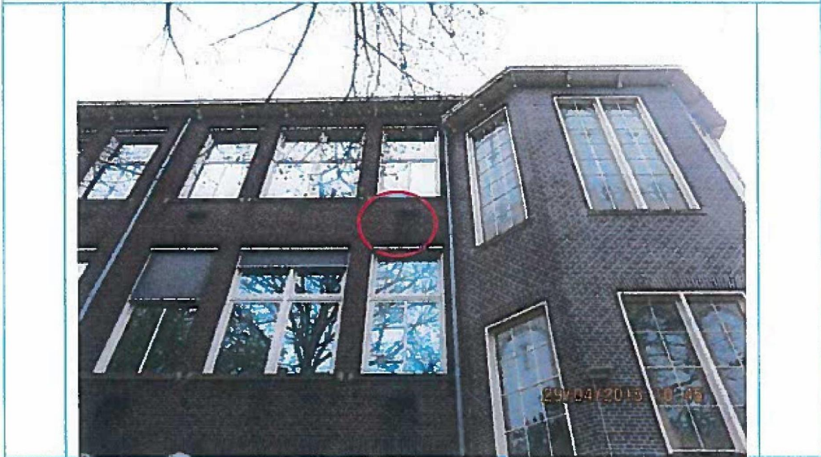
Foto 26. Detail foto 25. "Oude" scheurvorming in metselwerk. Geen gerelateerde bevestigingschade. Naar alle waarschijnlijkheid zetting. Niet significant toegenomen.
