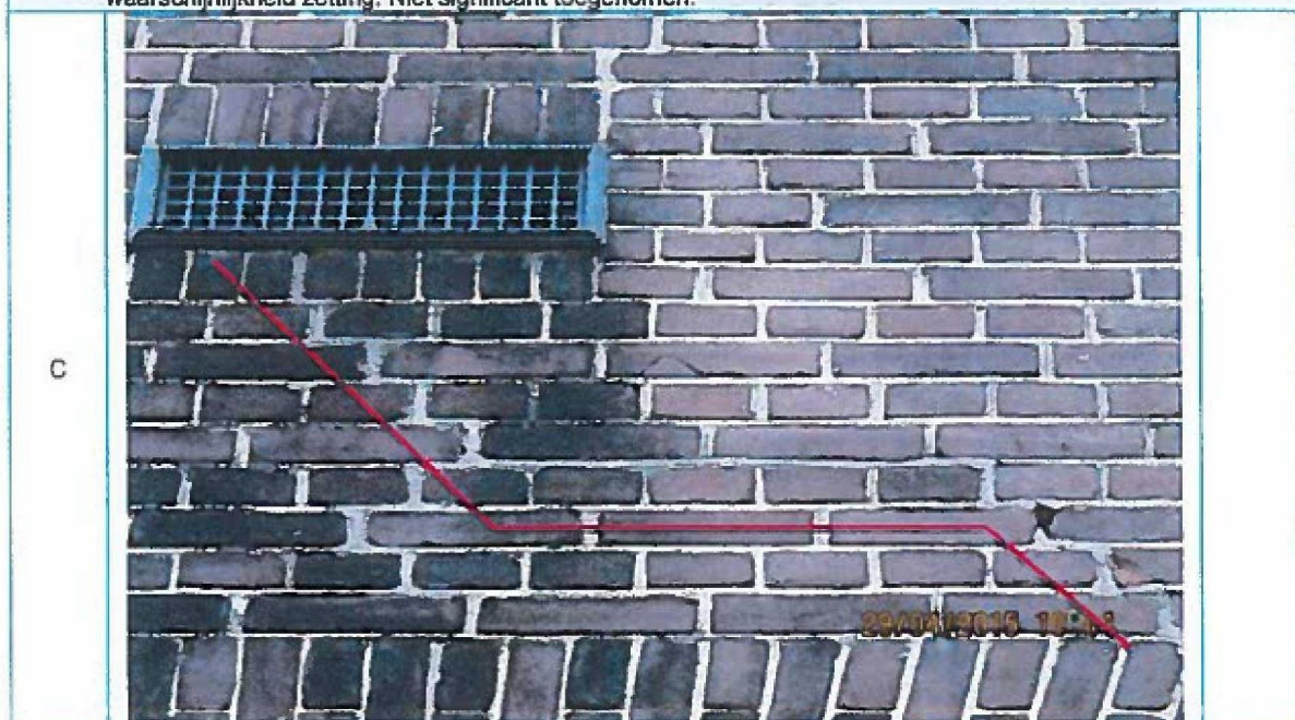
Foto 24. Detail foto 23. "Oude" scheurvorming in metselwerk. Geen beving gerelateerde schade. Naar alle waarschijnlijkheid zetting. Niet significant toegenomen.
