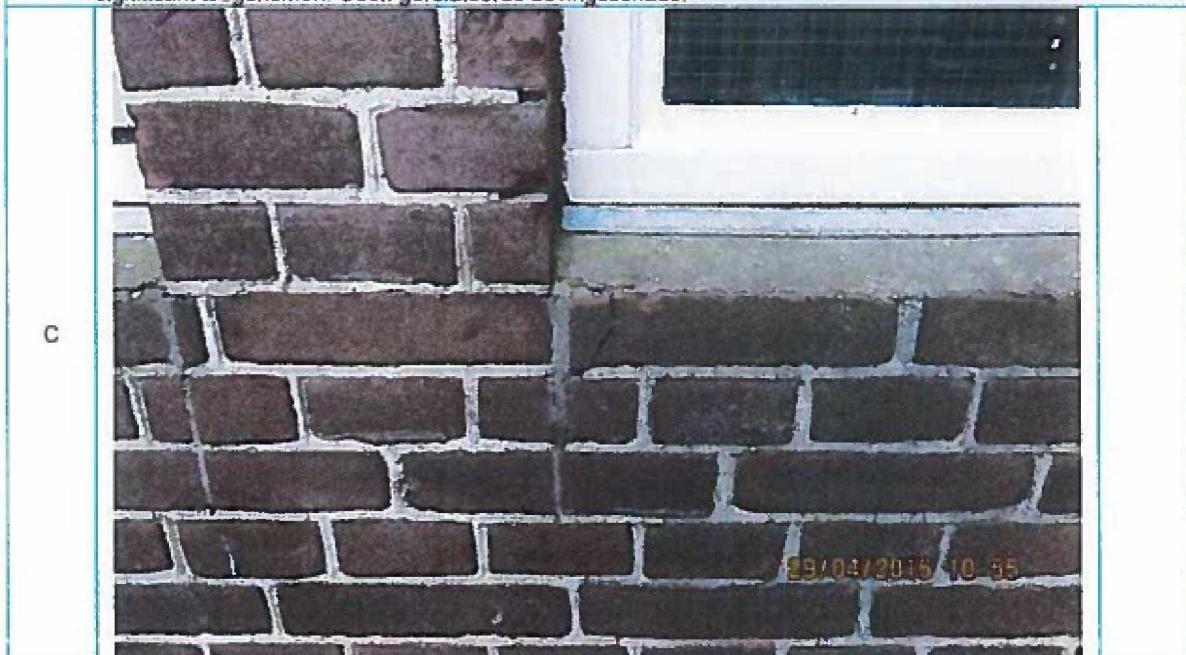
Foto 38. Detail foto 37. "Oude"scheurvorming in metselwerk. Reeds eerder hersteld. Niet hernieuwd, dan wel significant toegenomen. Geen gerelateerde bevestigingschade.
