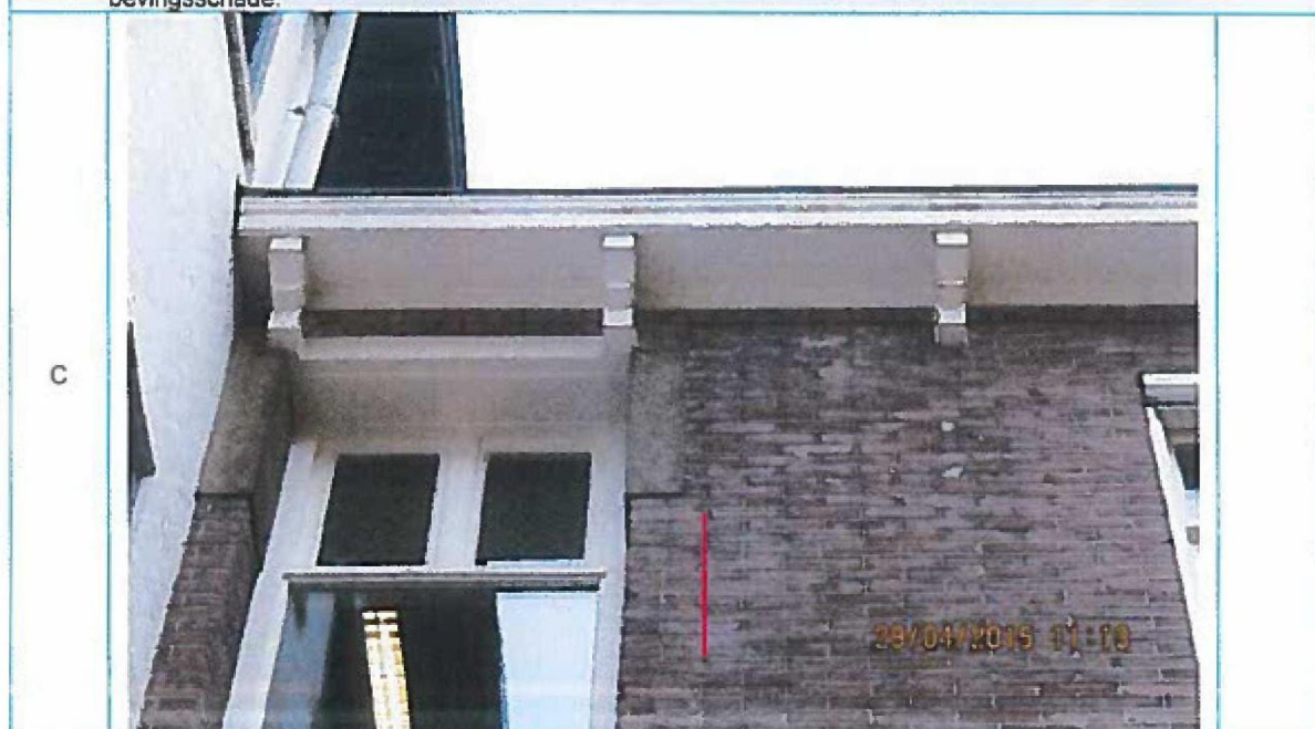
Foto 63. Detail foto 62. "Oude" scheurvorming in metselwerk. Niet significant toegenomen. Geen gerelateerde bevestigsschade.
