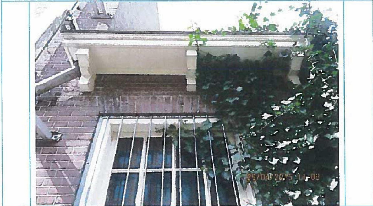
Foto 59. Detail foto 58. "Oude" scheurvorming in voegen. Niet significant toegenomen. Geen gerelateerde bevestigingschade.
