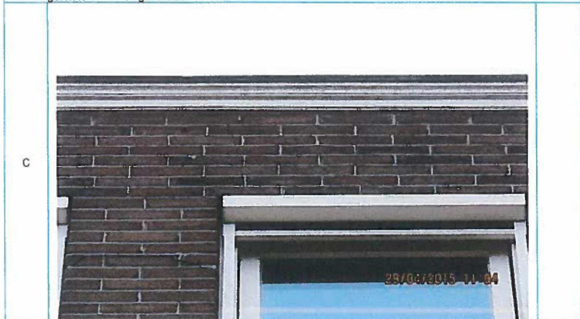
Foto 55. Detail foto 55. "Oude" scheurvorming en naar buiten gedrukt metselwerk. Niet significant toegenomen. Geen gerelateerde bevestigingschade.
