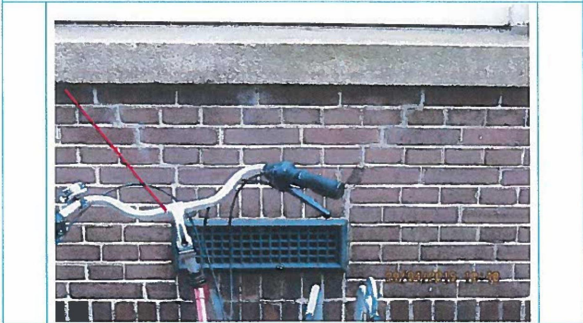
Foto 30. Detail foto 27. Hernieuwde scheurvorming in voegwerk, deels zetting. (recente scheur). Gescheurde voegen diep uitkrabben en opnieuw aanbrengen. Voeg(mortel) toepassen die qua samenstelling, hardheid, kleur en uiterlijk gelijk is als rondom gelegen bestaande voeg. Gebroken steen herstellen met epoxy vulmateriaal op kleur.
