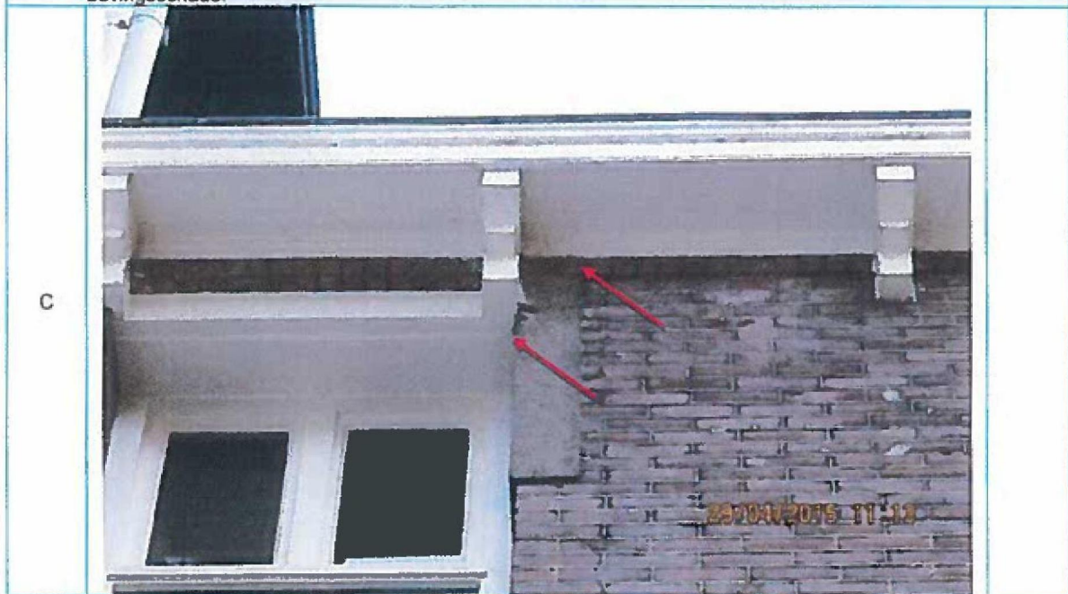
Foto 63. Detail foto 62. "Oude" scheurvorming in metselwerk. Niet significant toegenomen. Geen gerelateerde bevestigsschade.
