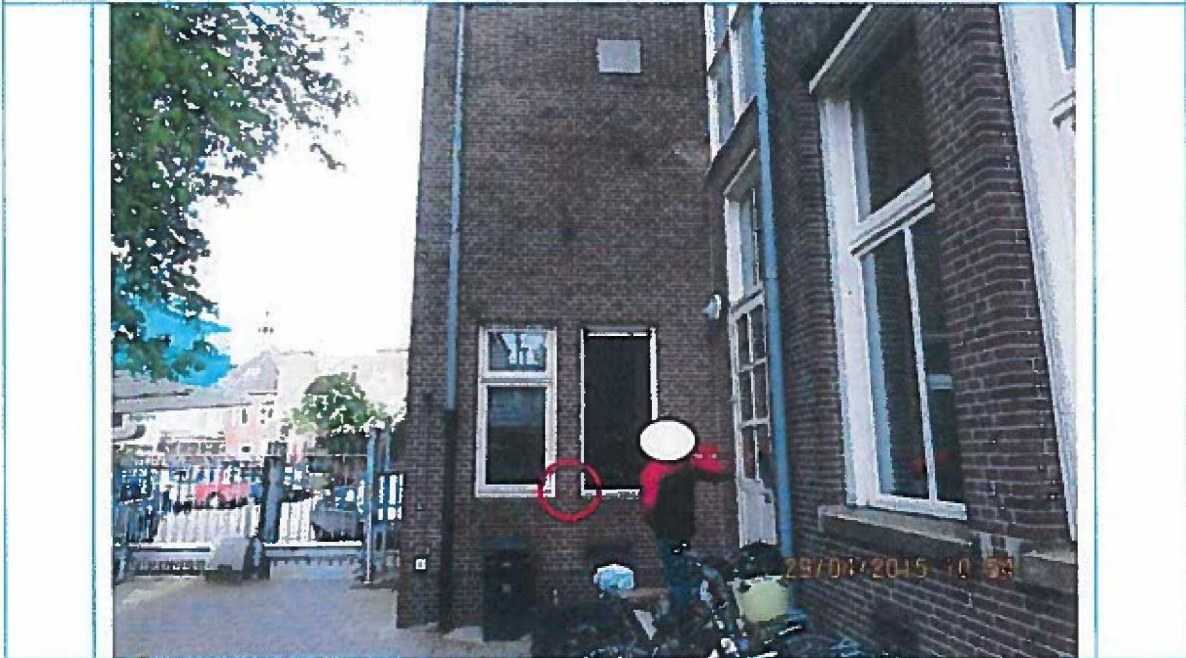
Foto 38. Detail foto 37. "Oude"scheurvorming in metselwerk. Reeds eerder hersteld. Niet hernieuwd, dan wel significant toegenomen. Geen gerelateerde bevestigingschade.
