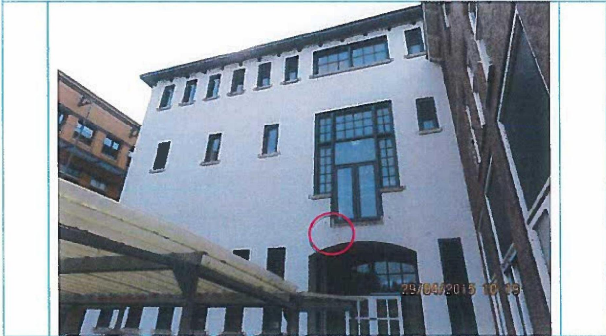
Foto 2. Detail foto 1. "Oude" scheurvorming in metselwerk. Geen gerelateerde bevestigsschade. Naar alle waarschijnlijkheid zetting. Niet significant toegenomen.
