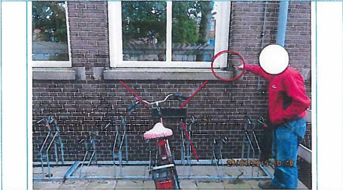
Foto 28. Reeds herstelde scheurvorming, bijgekleurde gevelstenen. Niet hernieuwd, dan wel significant toegenomen. Geen gerelateerde bevestigingschade.
