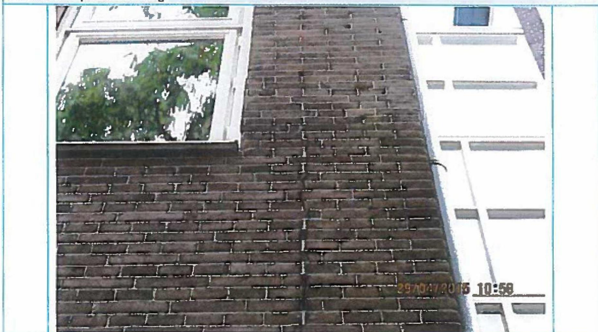
Foto 39. Verloop scheurvorming.
