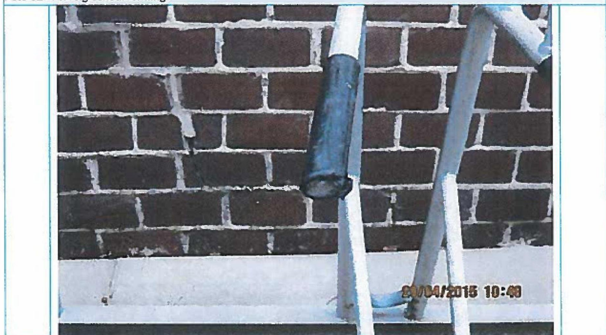
Foto 32. Vervolg scheurvorming.
