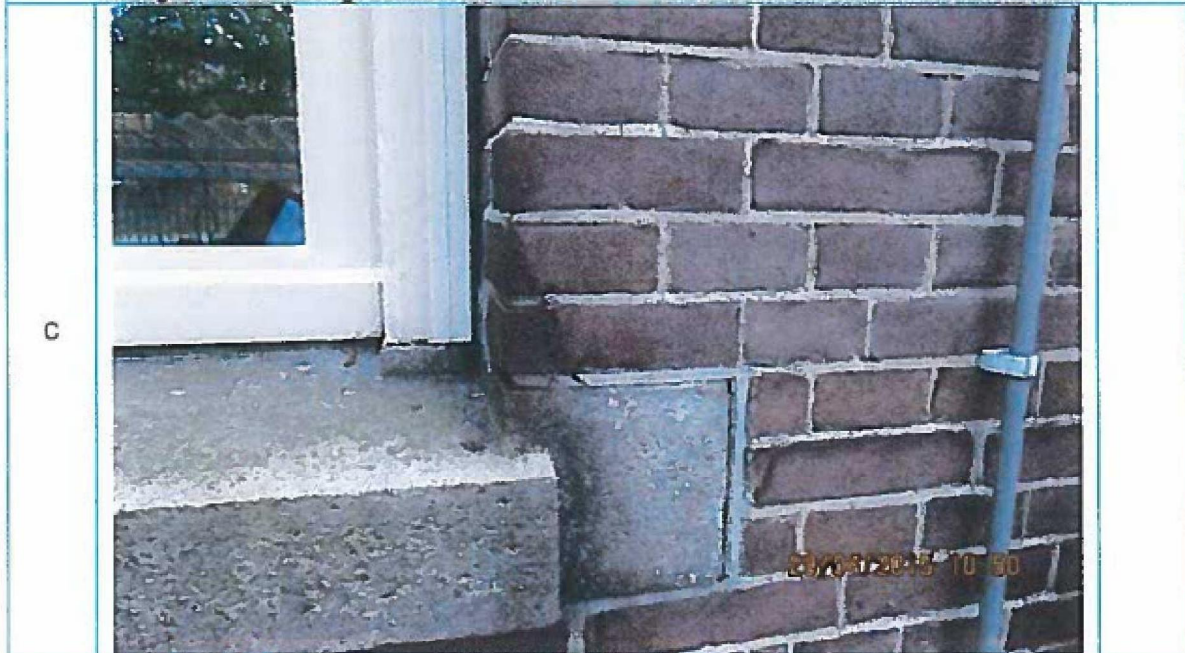
Foto 28. Reeds herstelde scheurvorming, bijgekleurde gevelstenen. Niet hernieuwd, dan wel significant toegenomen. Geen gerelateerde bevestigingschade.
