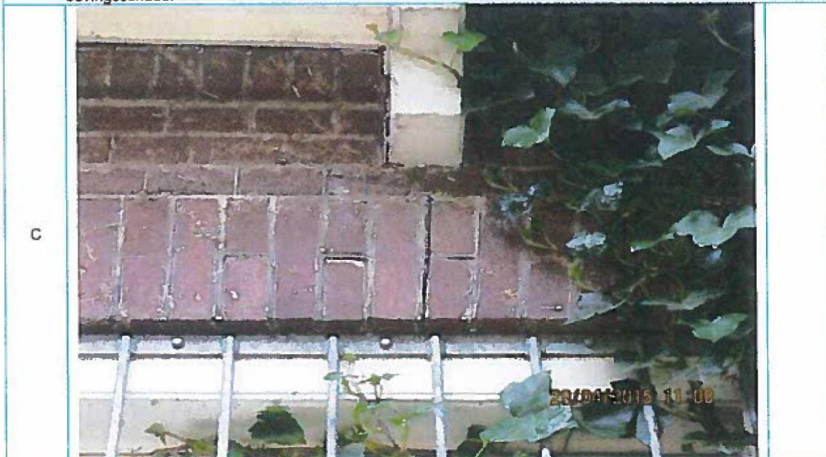
Foto 59. Detail foto 58. "Oude" scheurvorming in voegen. Niet significant toegenomen. Geen gerelateerde bevestigingschade.
