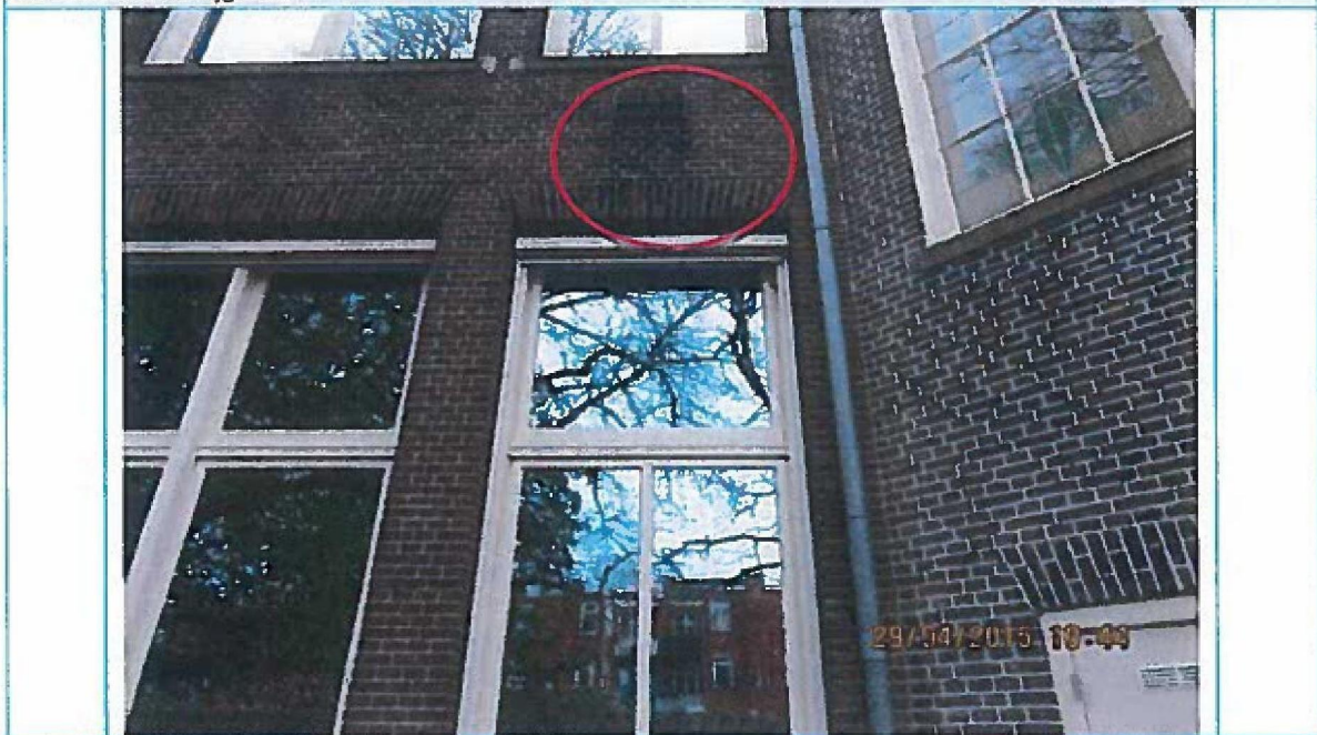
Foto 24. Detail foto 23. "Oude" scheurvorming in metselwerk. Geen beving gerelateerde schade. Naar alle waarschijnlijkheid zetting. Niet significant toegenomen.
