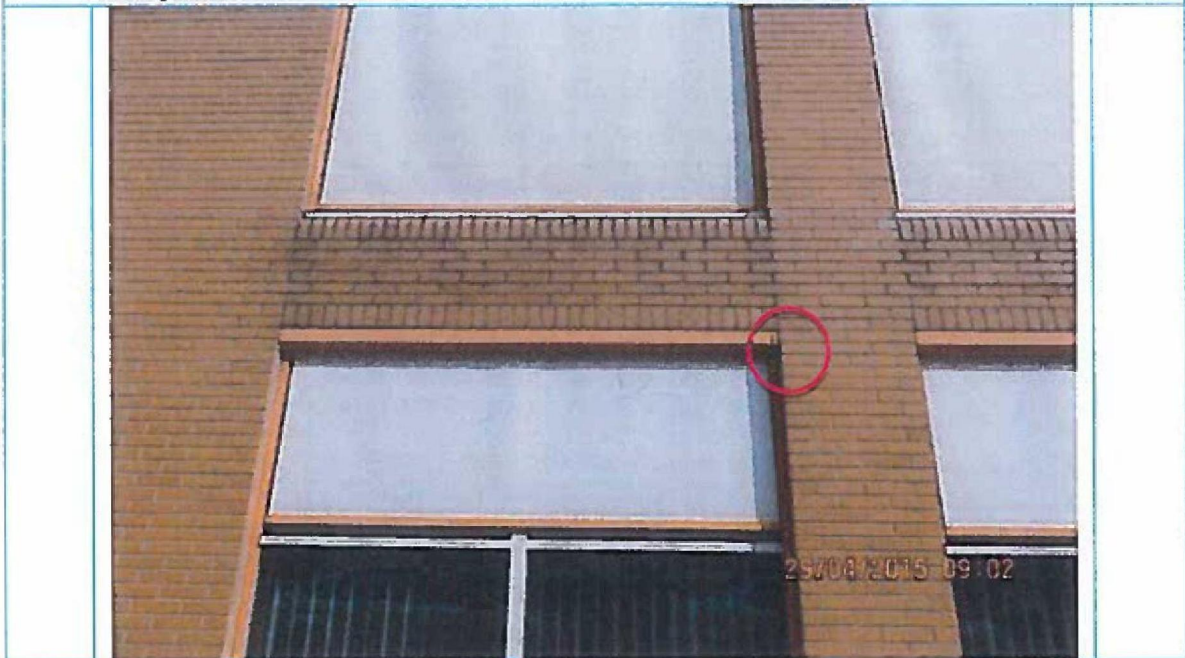
Foto 12. Vergerde scheurvorming in metselwerk. Gescheurde voegen diep uitkrabben en opnieuw aanbrengen. Voeg(mortel) toepassen die qua samenstelling, hardheid, kleur en uiterlijk gelijk is als rondom gelegen bestaande voeg. Gebroken stenen herstellen met epoxy vulmateriaal op kleur.
