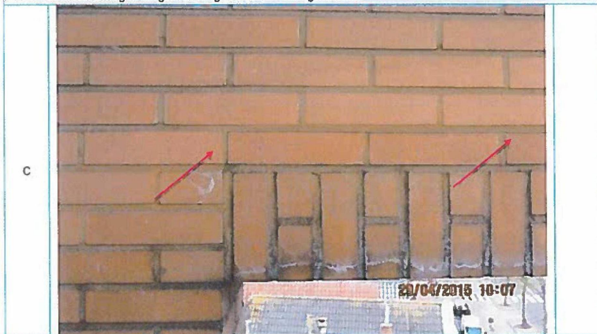
Foto 44. Verdere vervolg scheurvorming in voegen.
