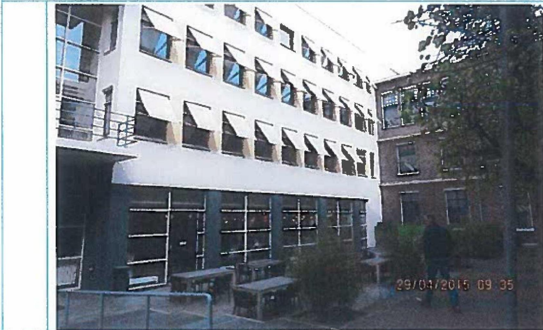
Foto 5. Linker zijgevel. Geen waarneembare schade
