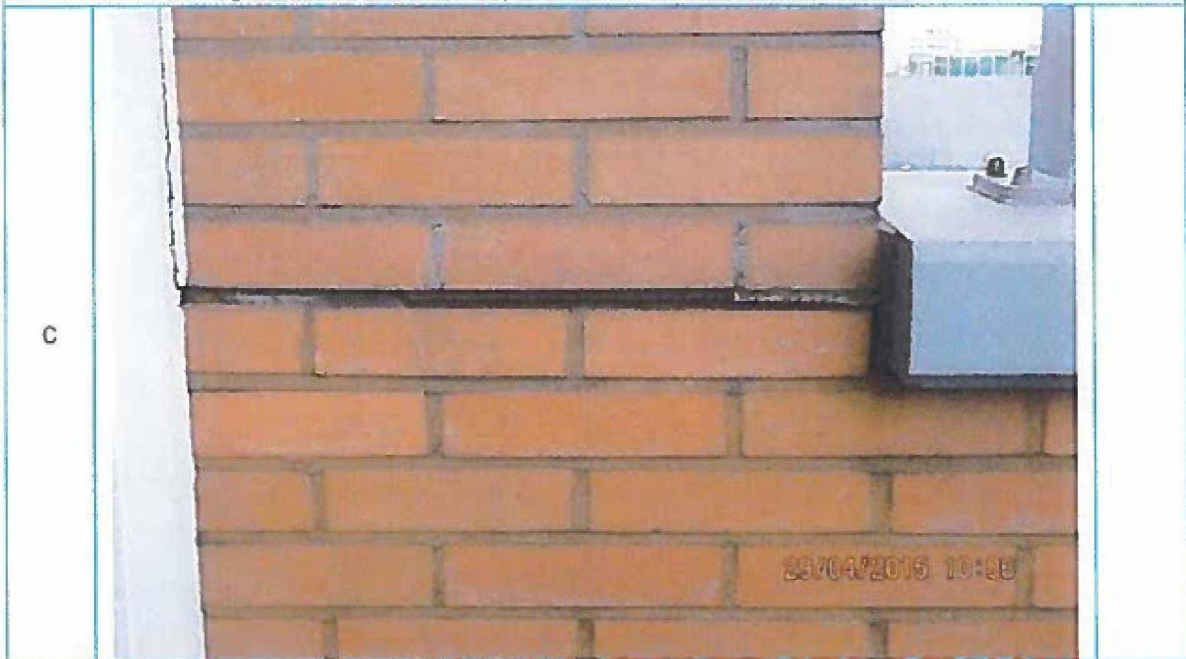
Foto 42. Scheurvorming in voegen. Geen gerelateerde bevestigsschade.
