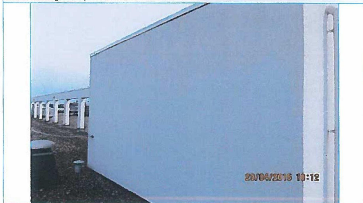
Foto 52. Rechtegevel liftopbouw. Geen waarneembare schade.
