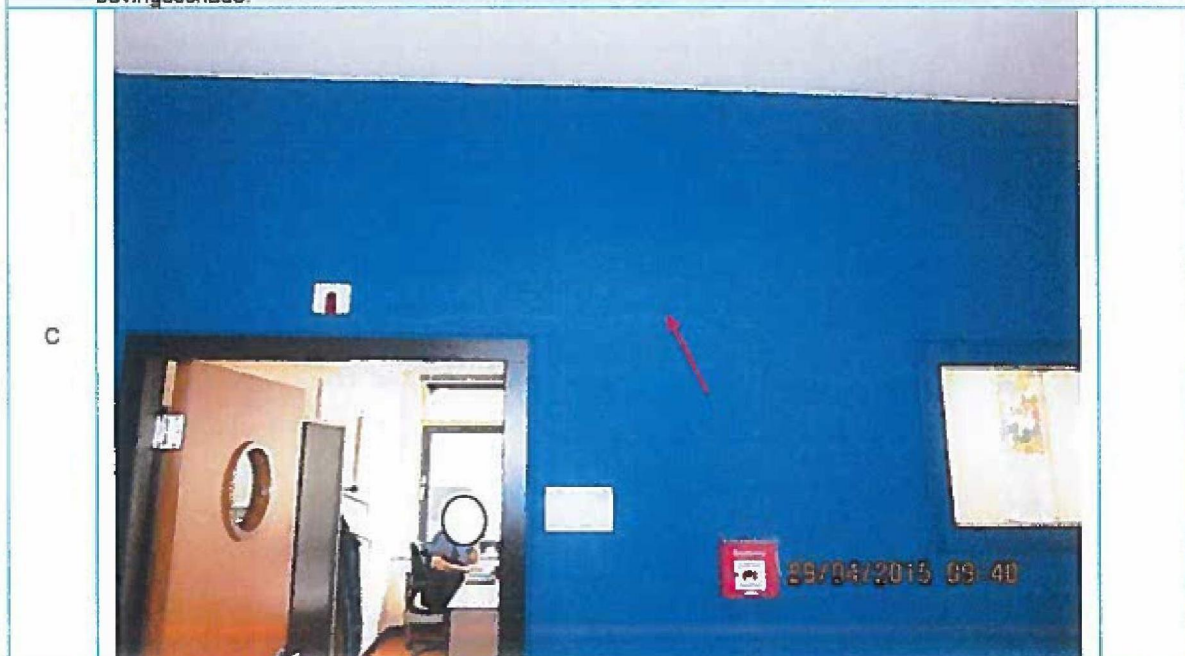
Foto 26. 1 o Verdieping, kantoor 1.04. Scheurvorming in stucwerk. Lengte ca. 0,80 meter. Geen gerelateerde bevestigingschade.
