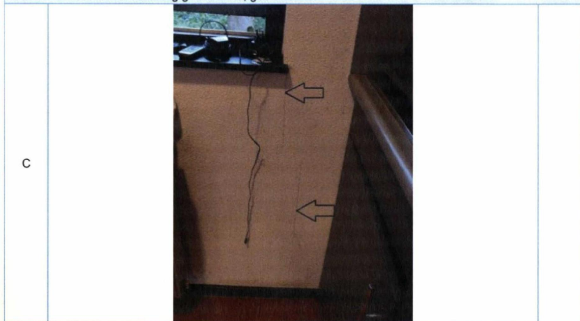
Foto 56. Scheur niet aardbeving gerelateerd, geen herstel.
