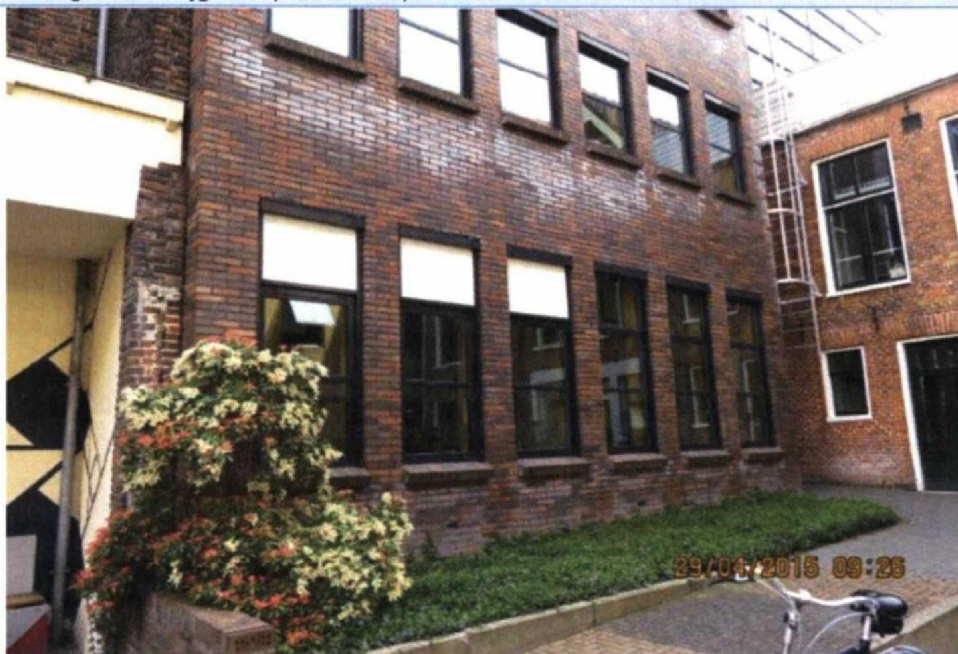
Foto 39. Vervolg rechter zijgevel. (nieuwbouw) Geen waarneembare schade.
