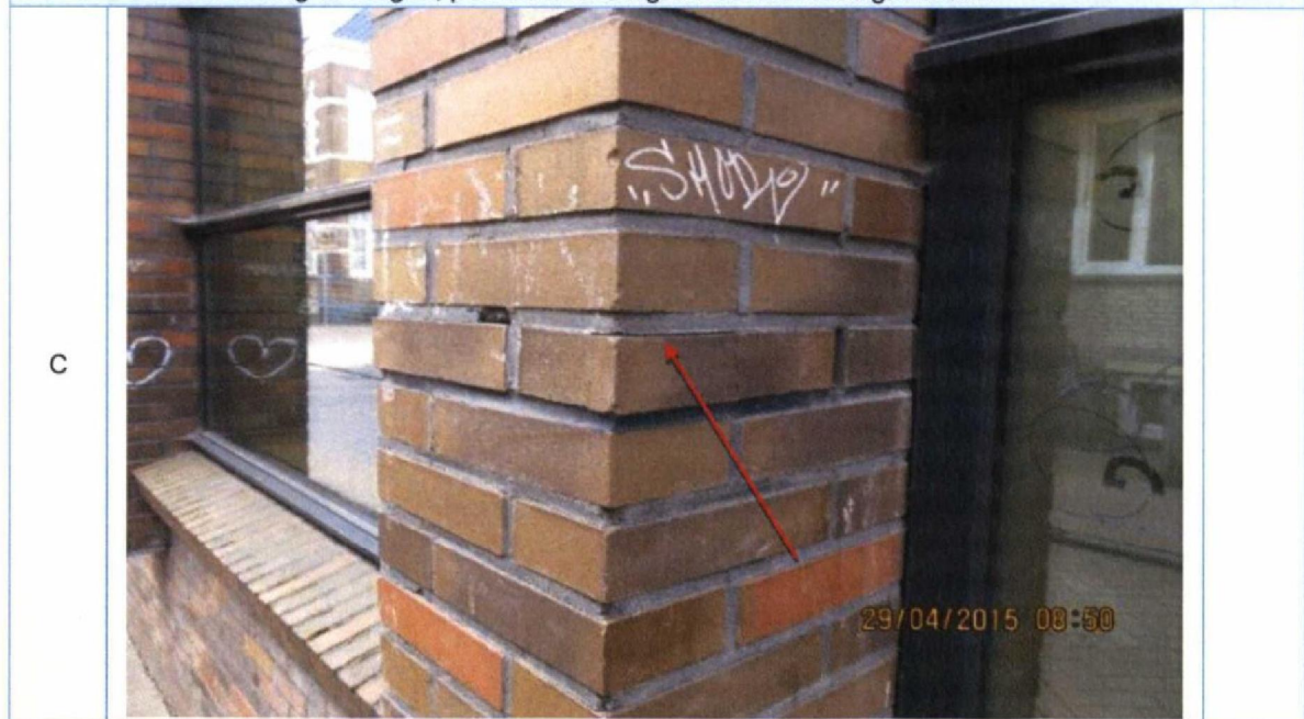
Foto 14. Scheurvorming in voegen, penant 5. Geen gerelateerde bevestigsschade.
