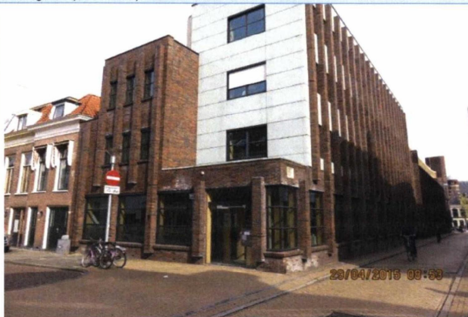
Foto 17. Achtergevel. (nieuwbouw) Geen waarneembare schade.
