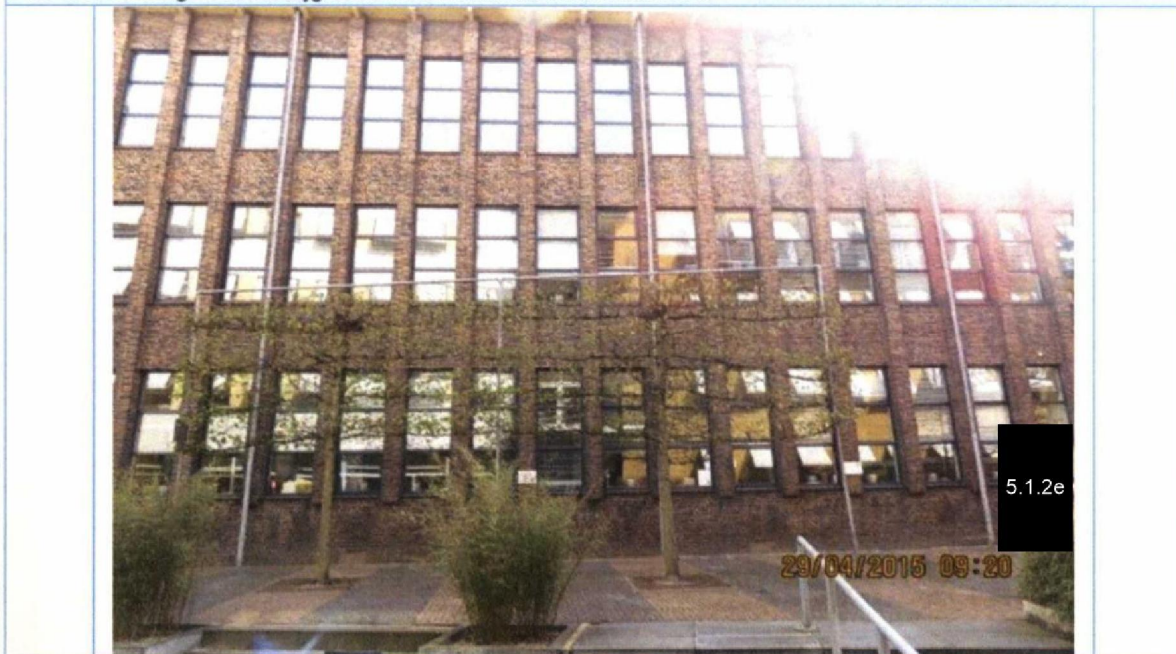
Foto 30. Vervolg rechter zijgevel. Geen waarneembare schade.
