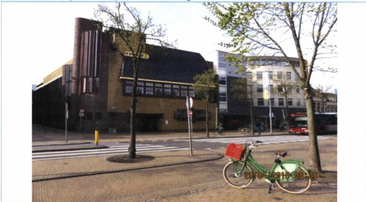
Overzicht / Gedempte Zuiderdiep 96 9711 HL Groningen
