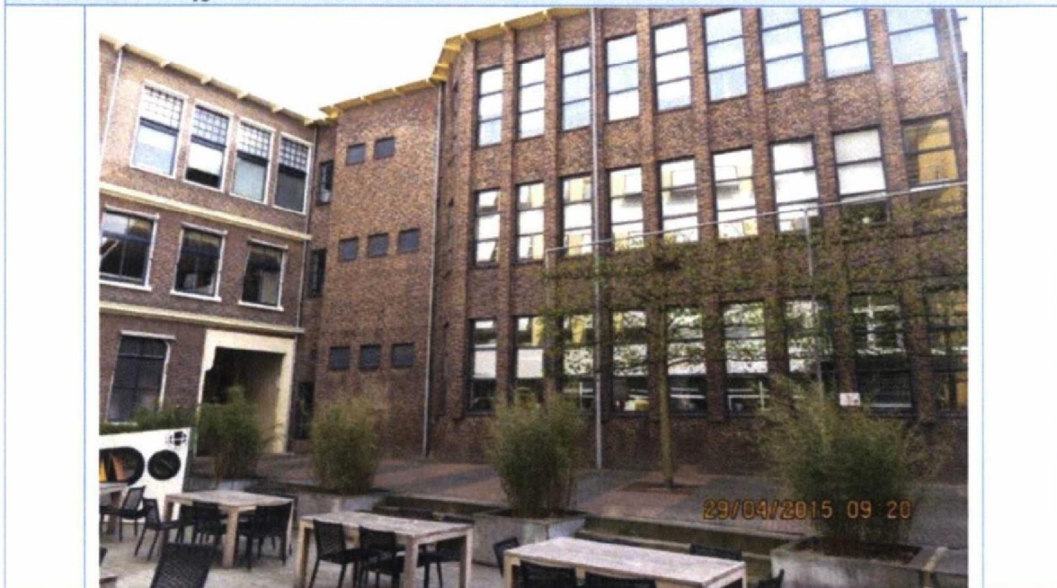
Foto 29. Rechter zijgevel. Geen waarneembare schade.
