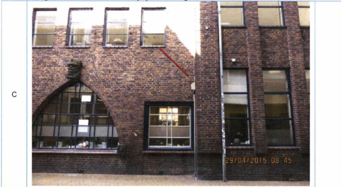
Foto 8. "Oude" scheurvorming in metselwerk. Niet significant toegenomen. Geen gerelateerde bevestigingschade. Naar alle waarschijnlijkheid zetting.
