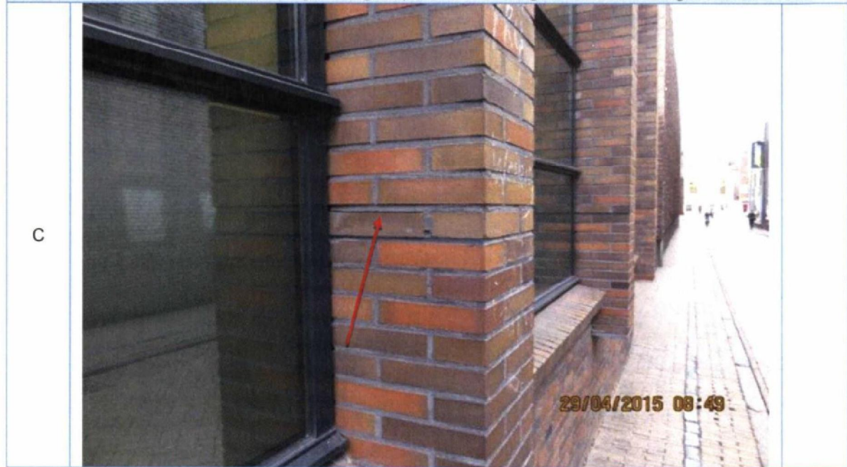
Foto 14. Scheurvorming in voegen, penant 5. Geen gerelateerde bevestigsschade.
