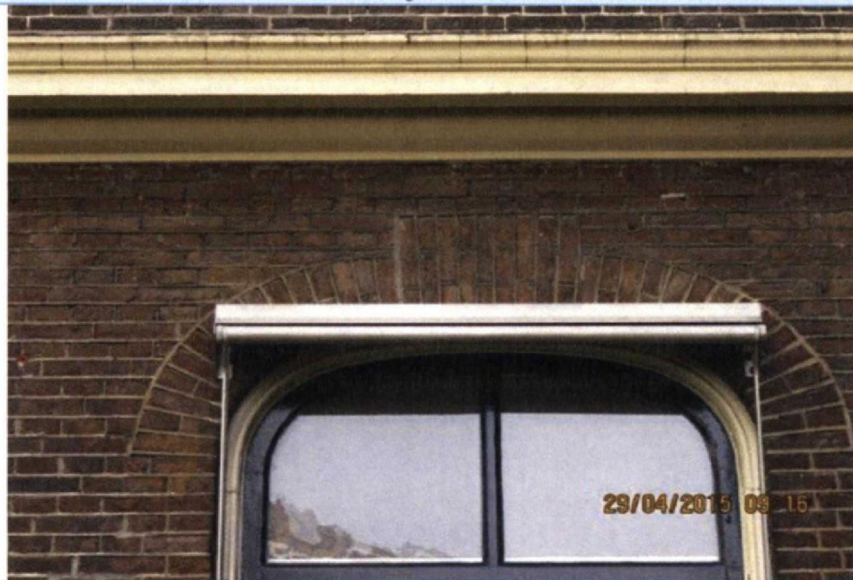
Foto 21. Detail foto 20. Reeds eerder hersteld voegwerk. Geen waarneembare schade.
