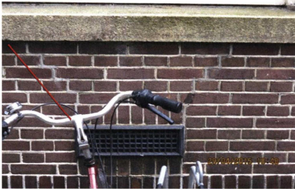
Foto 30. Detail foto 27. Hernieuwde scheurvorming in voegwerk, deels zetting. (recente scheur). Gescheurde voegen diep uitkrabben en opnieuw aanbrengen. Voeg(mortel) toepassen die qua samenstelling, hardheid, kleur en uiterlijk gelijk is als rondom gelegen bestaande voeg. Gebroken steen herstellen met epoxy vulmateriaal op kleur.
