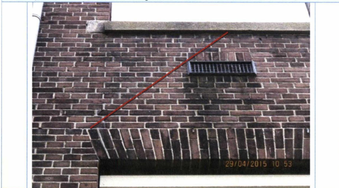
Foto 36. Detail foto 35. Reeds eerder hersteld voegwerk. Geen waarneembare schade.
