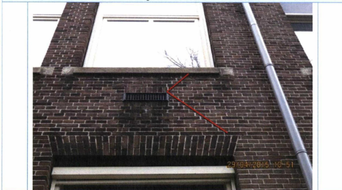
Foto 34. Detail foto 33. Reeds eerder hersteld voegwerk. Geen waarneembare schade.
