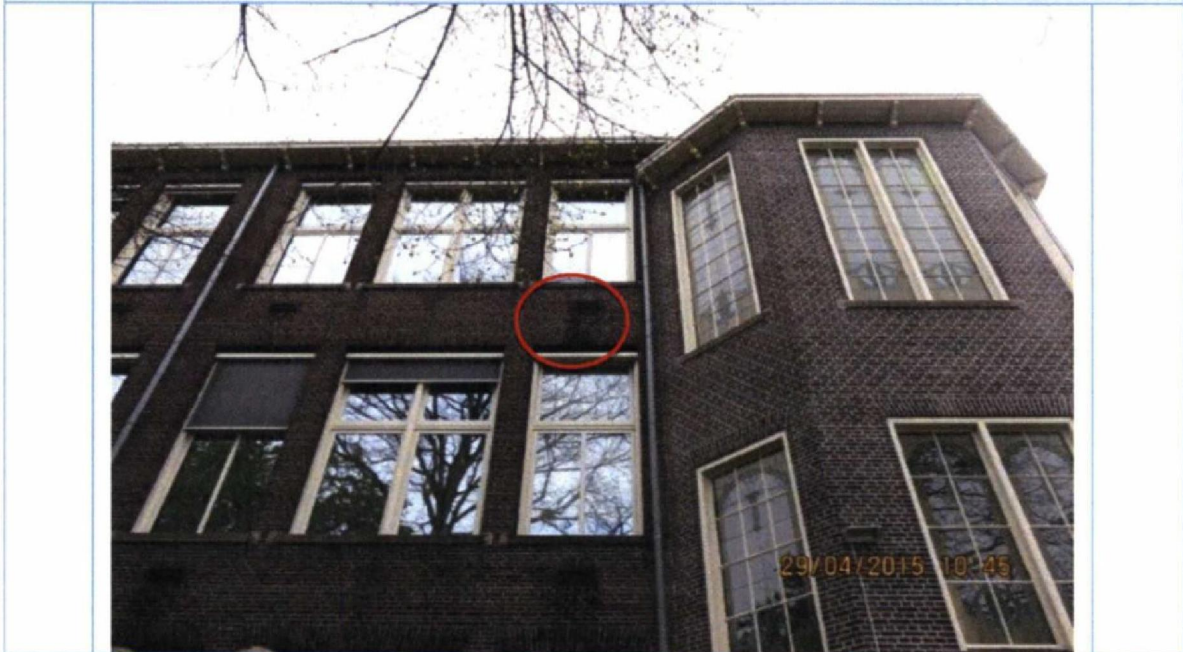
Foto 26. Detail foto 25. "Oude" scheurvorming in metselwerk. Geen gerelateerde bevestigsschade. Naar alle waarschijnlijkheid zetting. Niet significant toegenomen.
