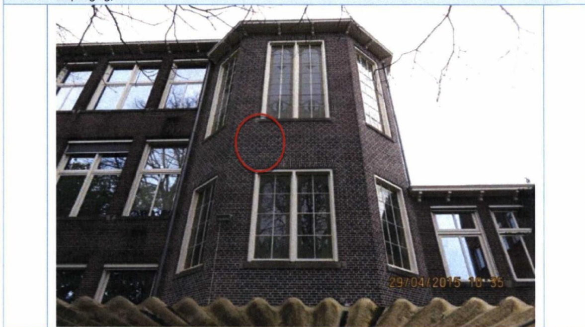
Foto 16. Detail foto 15. "Oude" scheurvorming in metselwerk. Voegwerk reeds eerder hersteld, geen hernieuwde scheurvorming. Geen beving gerelateerde schade.
