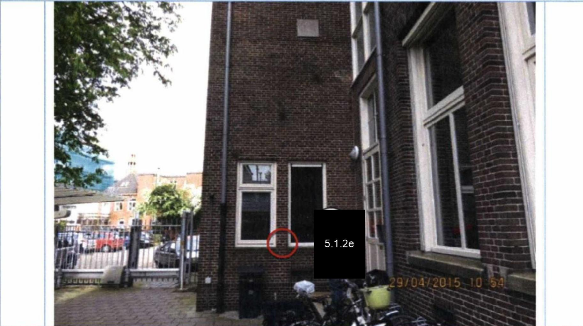
Foto 38. Detail foto 37. "Oude"scheurvorming in metselwerk. Reeds eerder hersteld. Niet hernieuwd, dan wel significant toegenomen. Geen gerelateerde bevestigsschade.
