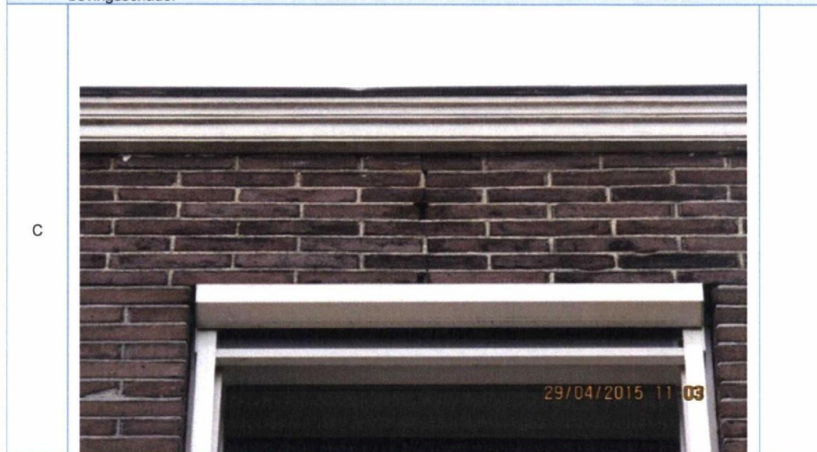
Foto 53. Detail foto 52. Naar buiten gedrukte gevelsteen. Geen gerelateerde bevestigsschade.
