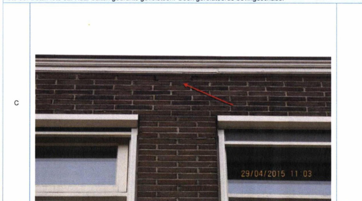
Foto 53. Detail foto 52. Naar buiten gedrukte gevelsteen. Geen gerelateerde bevestigsschade.
