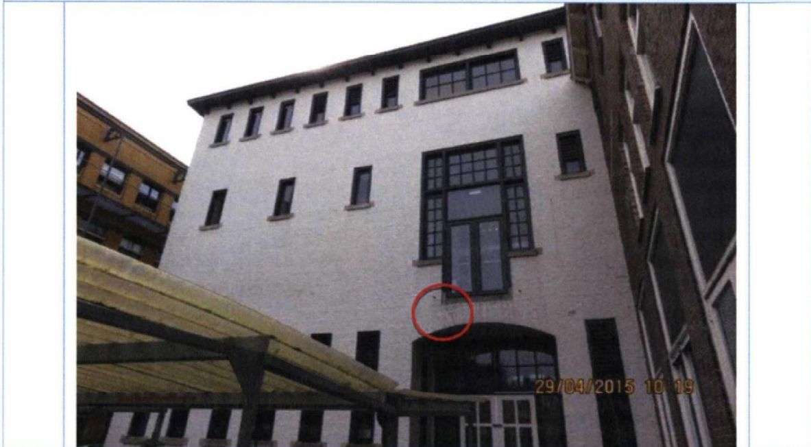
Foto 2. Detail foto 1. "Oude" scheurvorming in metselwerk. Geen gerelateerde bevestigingschade. Naar alle waarschijnlijkheid zetting. Niet significant toegenomen.
