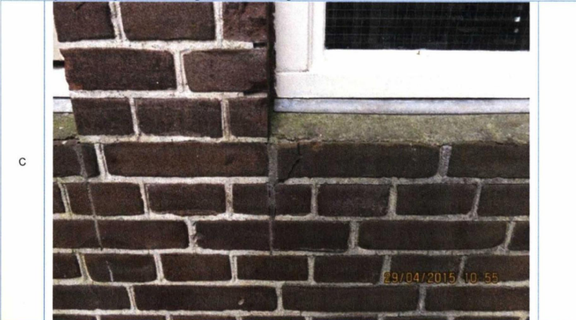
Foto 38. Detail foto 37. "Oude"scheurvorming in metselwerk. Reeds eerder hersteld. Niet hernieuwd, dan wel significant toegenomen. Geen gerelateerde bevestigsschade.
