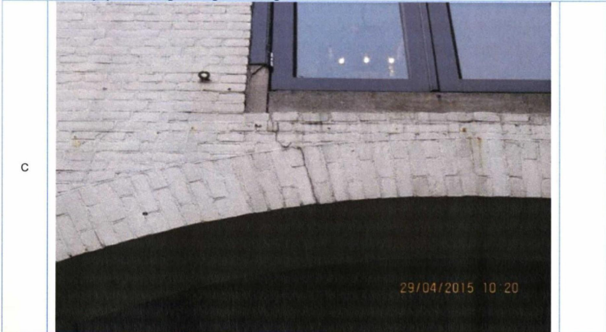
Foto 2. Detail foto 1. "Oude" scheurvorming in metselwerk. Geen gerelateerde bevestigingschade. Naar alle waarschijnlijkheid zetting. Niet significant toegenomen.
