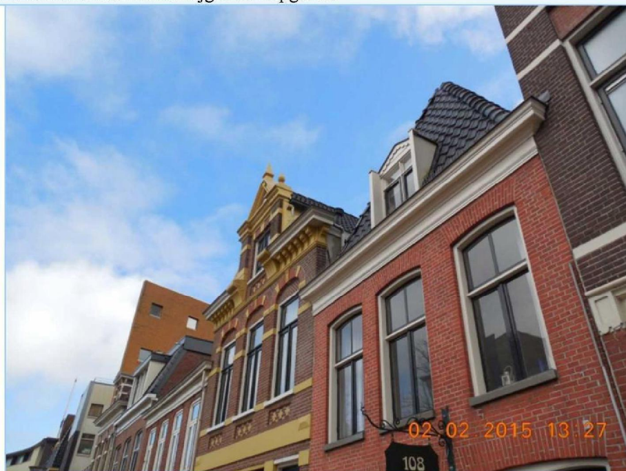
Foto 2. Overzichtsfoto rechterzijgevel. Topgevel.
