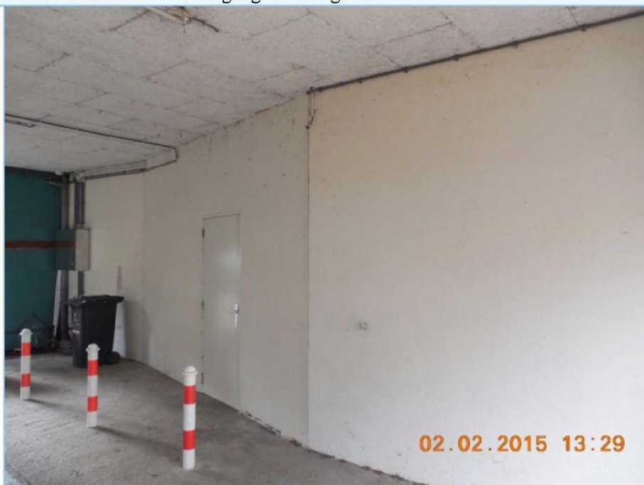
Foto 8. Overzichtsfoto onderdoorgang. Linker gevel.
