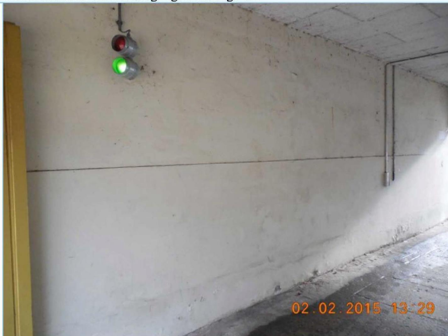
Foto 7. Overzichtsfoto onderdoorgang. Linker gevel.
