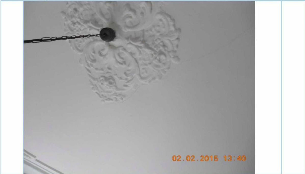
Foto 45. Vervolg van scheur van foto 43
