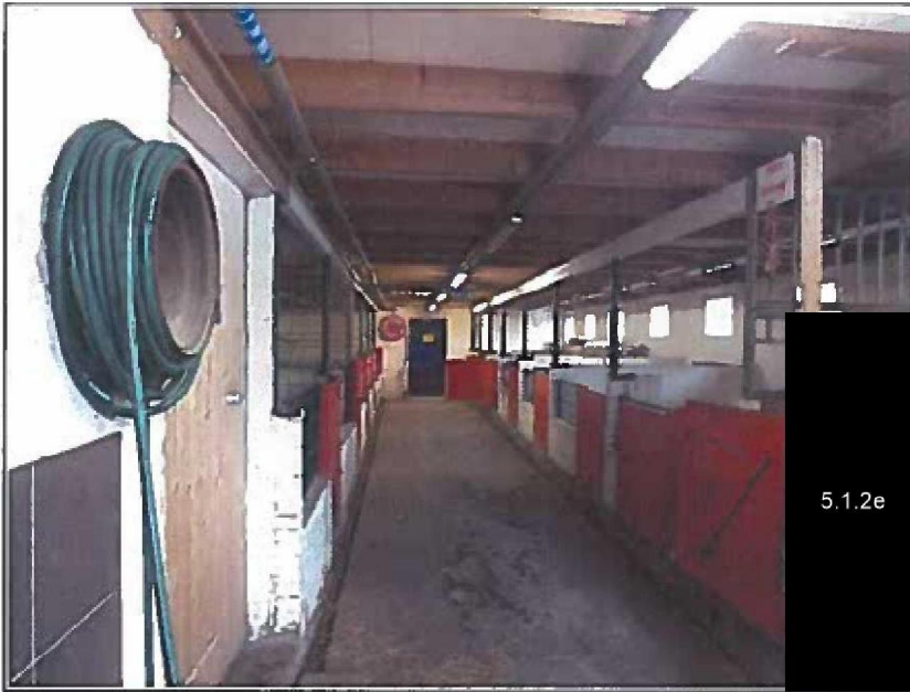
Schade 3, Scheurvorming in betonvloer. (IMG_8259)
