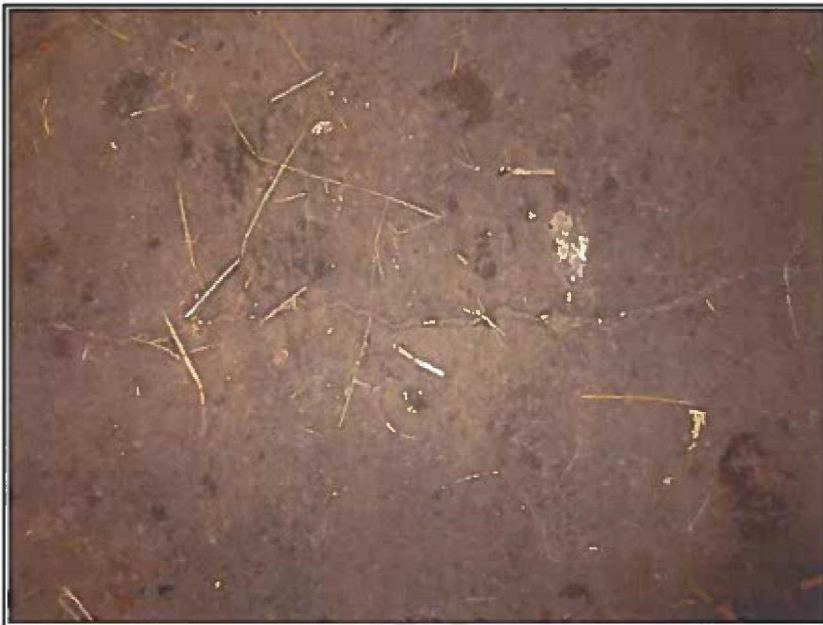
Schade 5, Scheurvorming in betonvloer. (IMG_1149)
