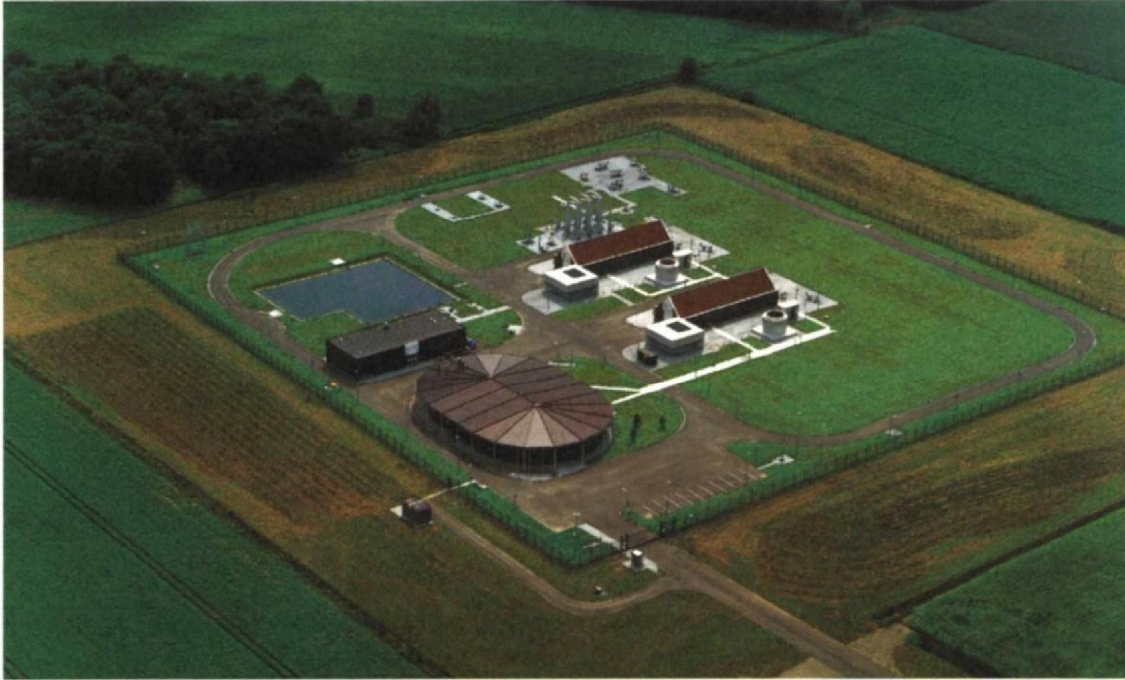
Ruimtelijke inpassing van een gasontvangstation
