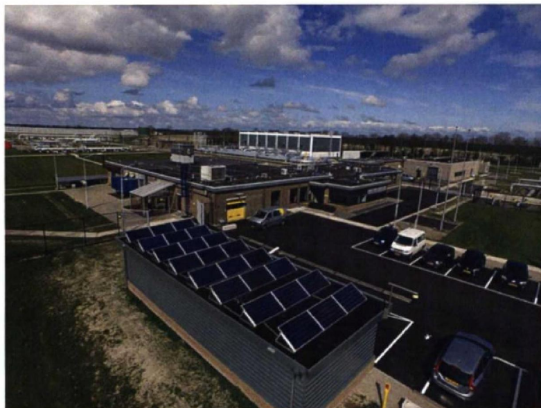
Foto: Hal Wieringermeer voorzien van zonnepanelen
