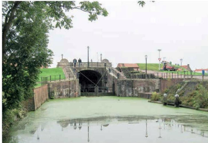
Termunterzijl | Sluis en brug over Zijldiep Rijksmonument
