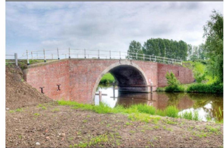
Aduard | Aduarderdiep | Steentil | Rijksmonument
