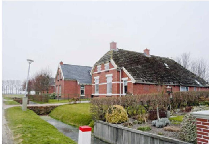
Stedum | Lellensterweg 4 | Landarbeidershuizen
