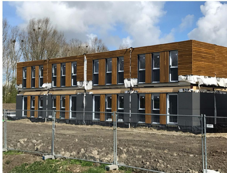
In aanbouw zijnde woningen in Ten Post
