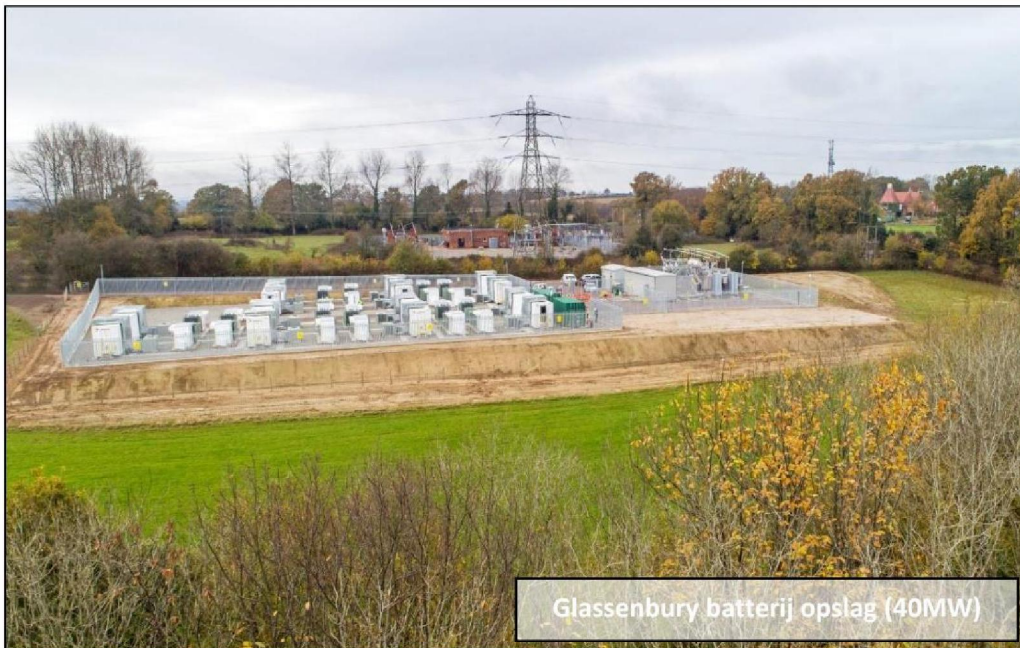
Afbeelding 5. De grootschalige batterij opslag bij Glassenbury: de foto is direct na de aanleg genomen. De opslag is nog niet landschappelijk ingepast.
