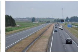
zicht op A7, met plangebied aan linkerzijde
