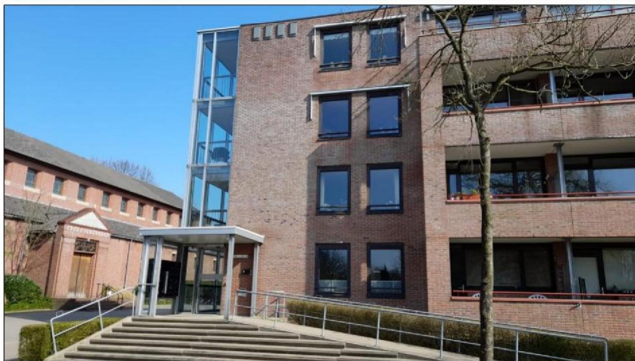
Figuur 7. Geplaatste tijdelijke voorzieningen aan de gevel.
