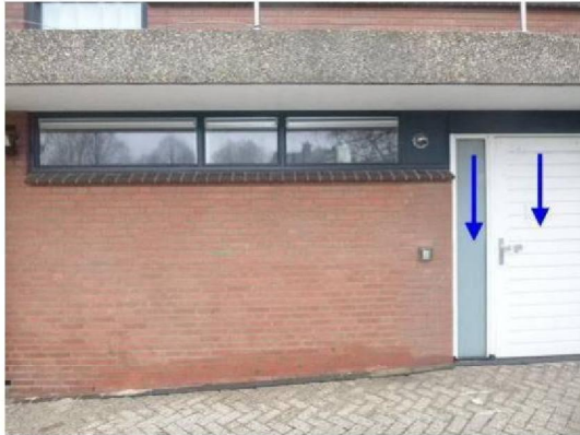
Nieuw kozijn met deur achtergevel
