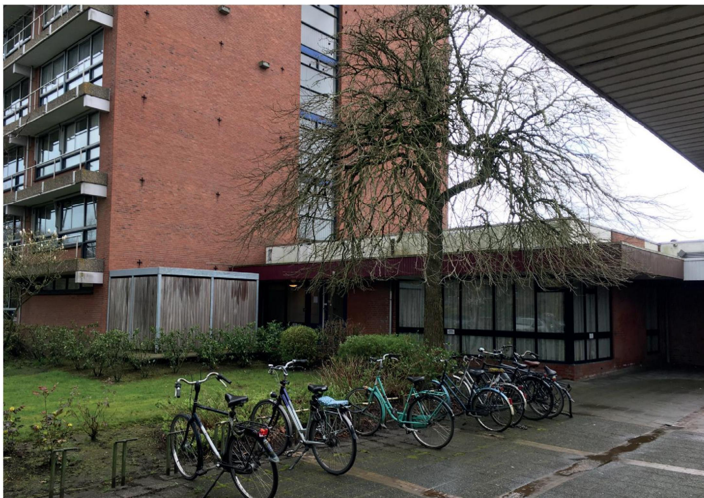
Noordgevel Zuiderflat met aanbouw
