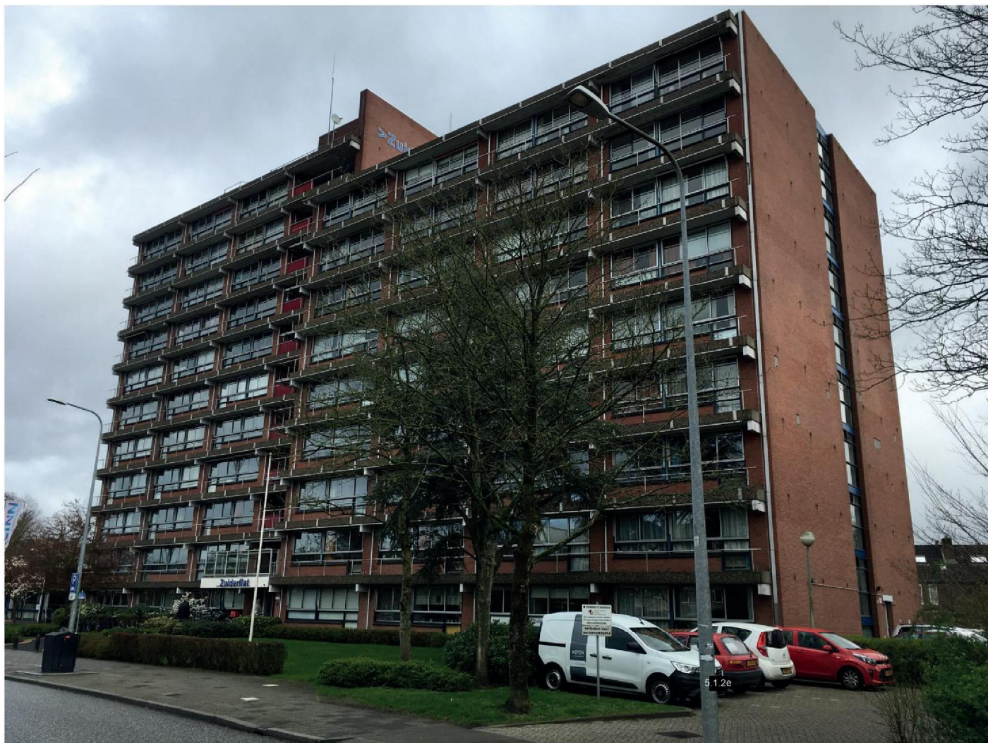
West- en zuidgevel
