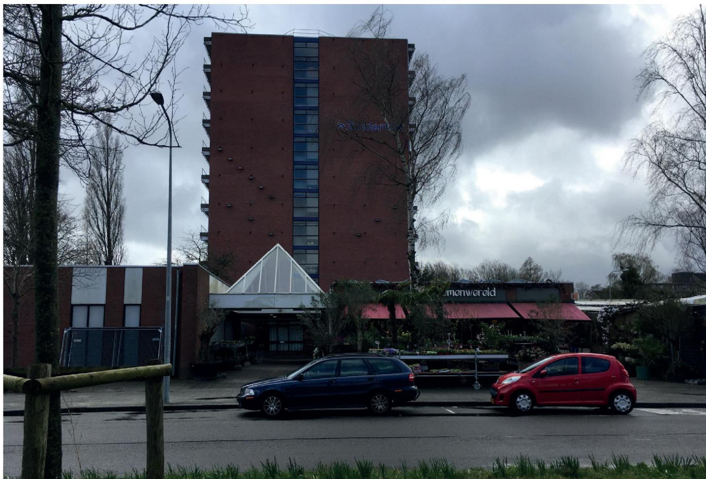
Belendende bebouwing met daarachter de noordgevel van de Zuiderflat
