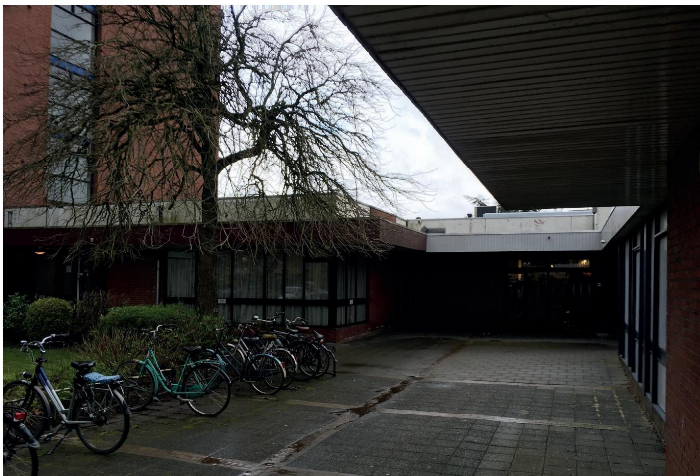
Oostgevels aanbouw en belendende bebouwing
