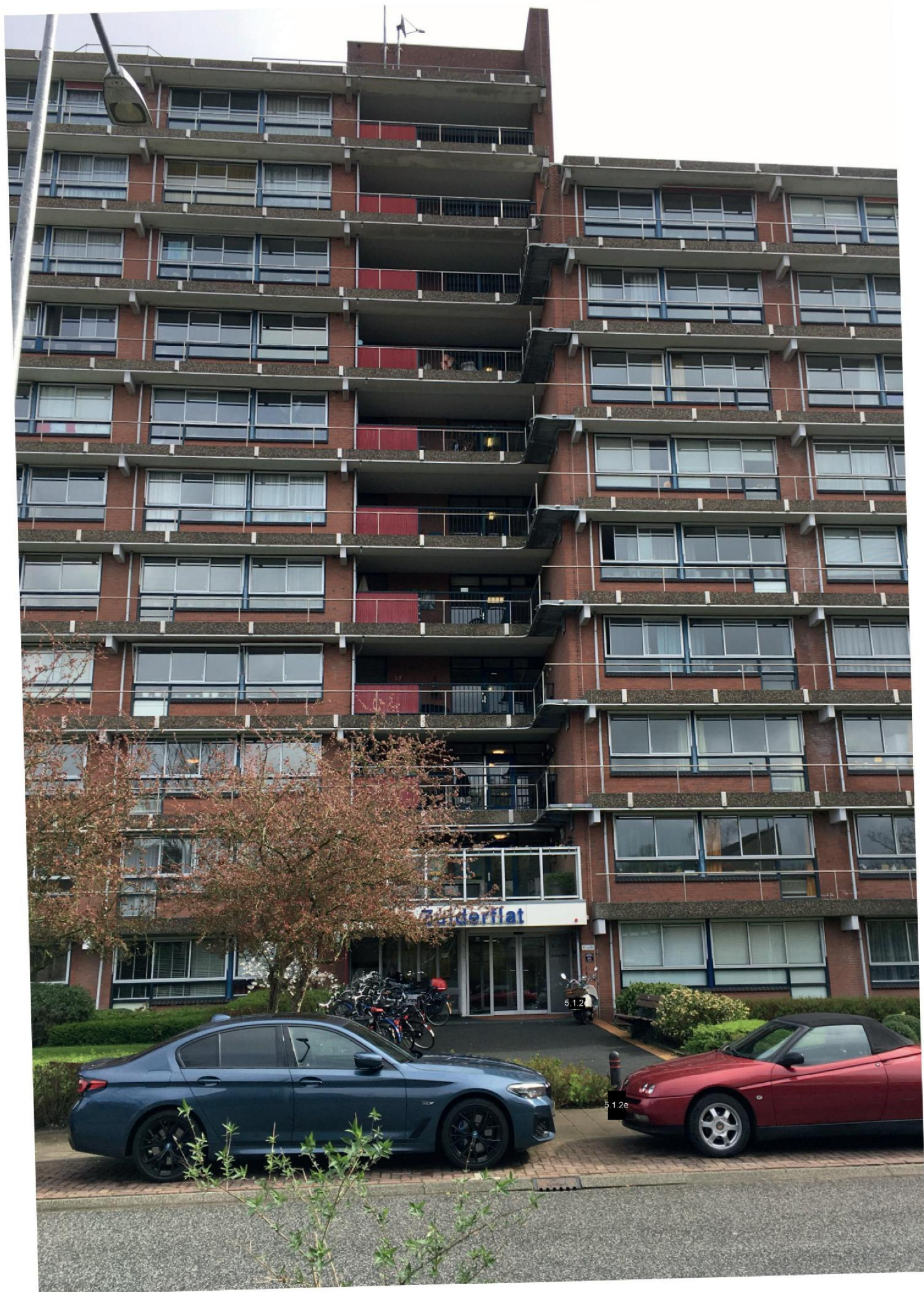
Westgevel met hoofdentree
