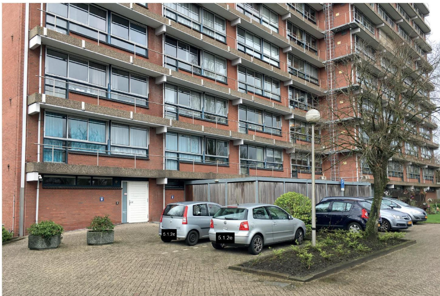
Zuid- en oostgevel
