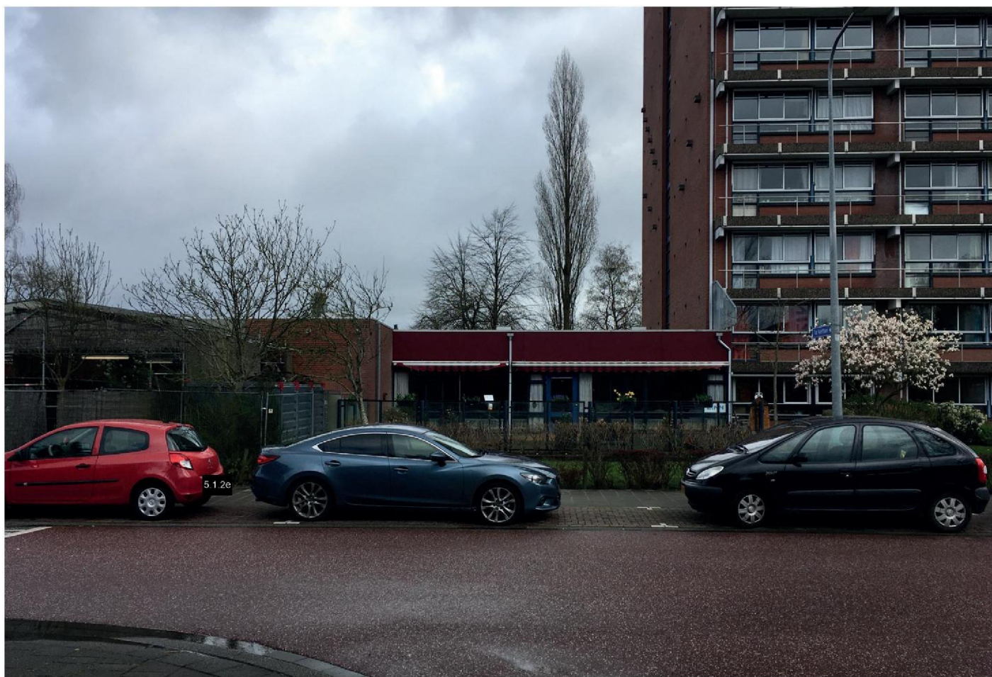
Westgevels van de belendende bebouwing en de aanbouw
