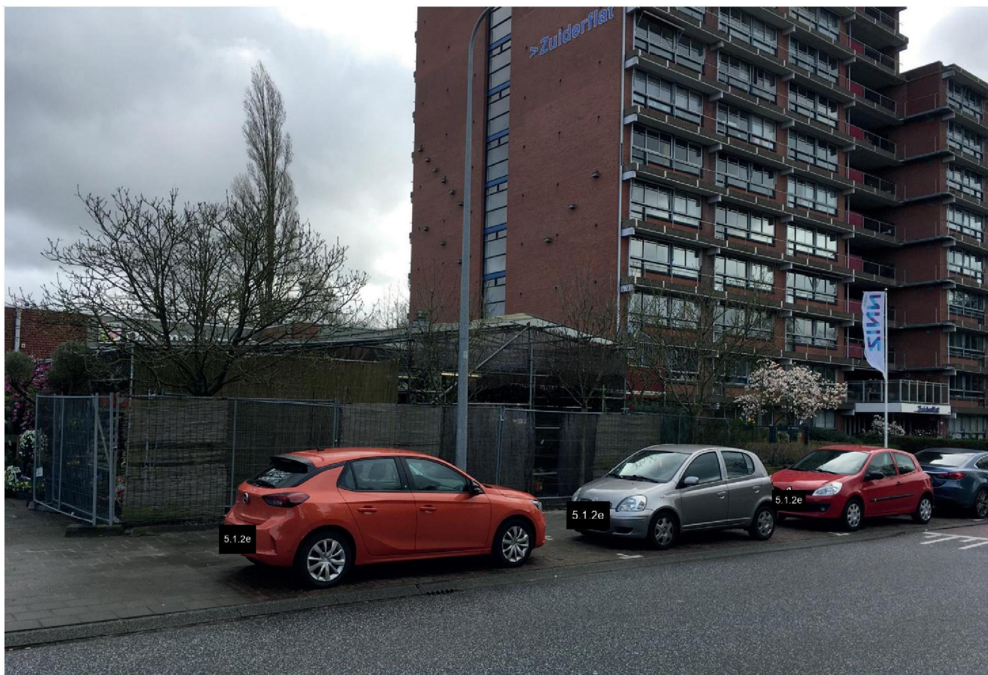
Belendende bebouwing met daarachter de noord- en westgevel van de Zuiderflat
