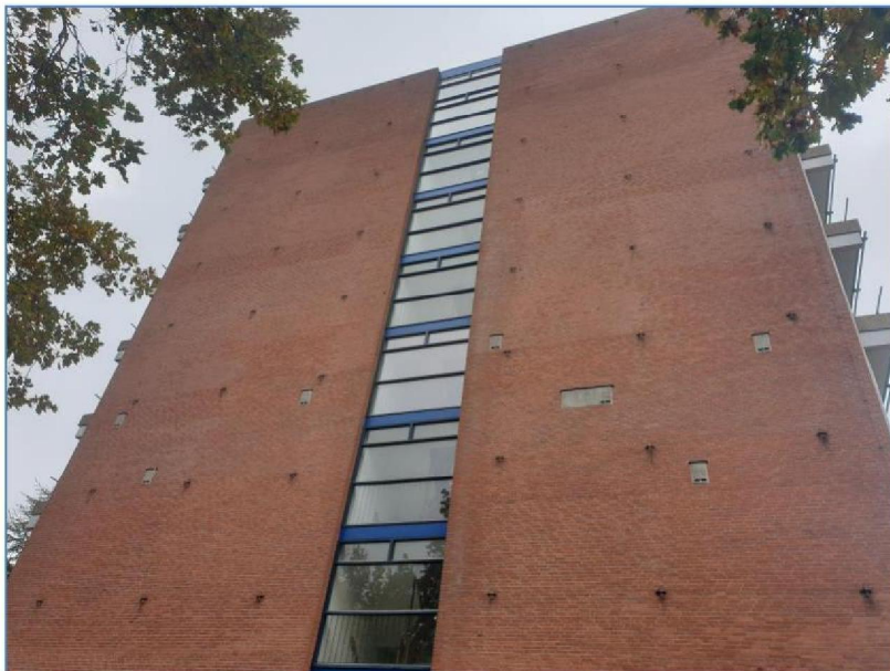
Figuur 4. Aanwezige vleermuis inbouwkasten ter plaatse van de zuidgevel.
