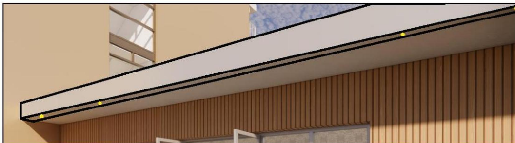
Figuur 14. Voorbeeld creëren van een spleet aan de rand van de boeiboorden (zwart omlijnd) en voorzien van toegangsopeningen van 25 millimeter Ø.
