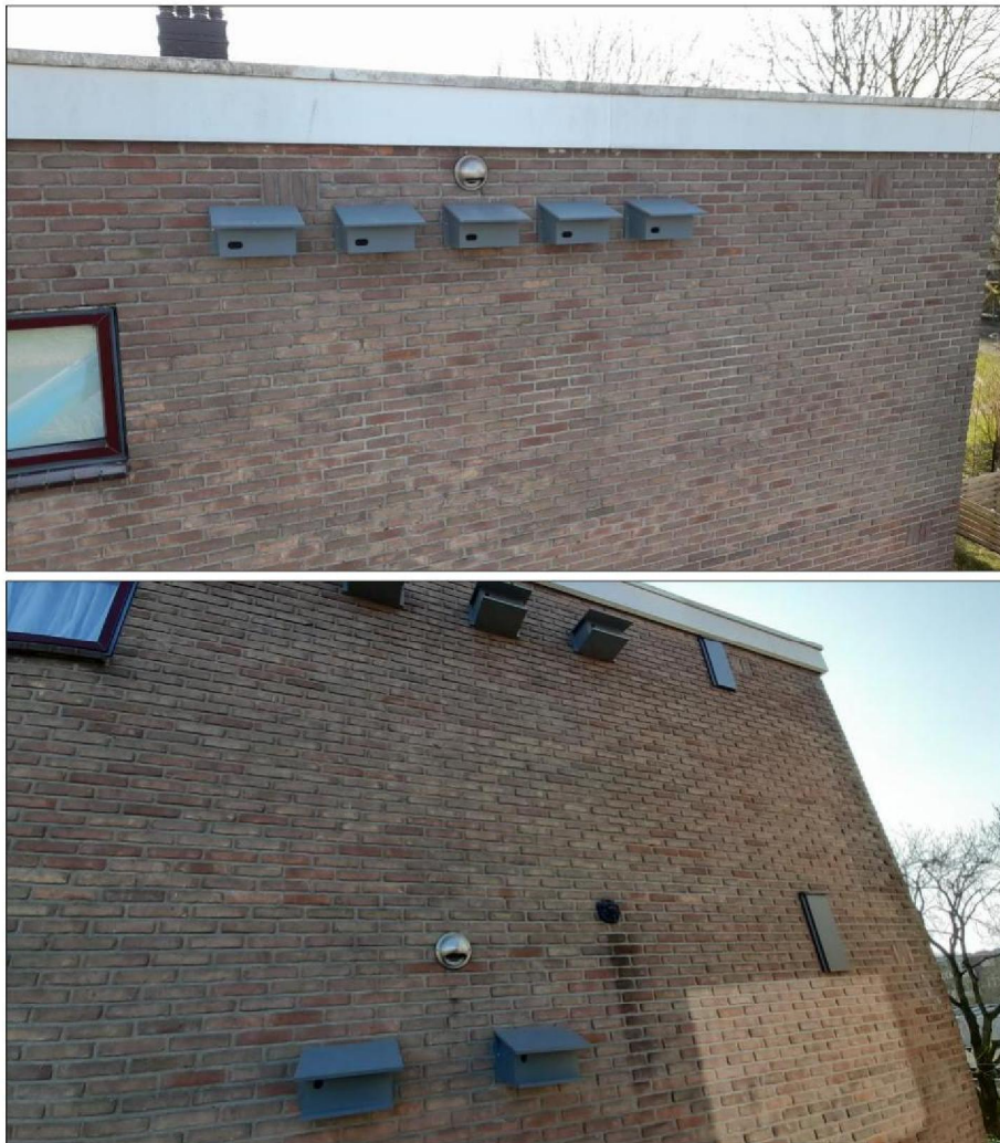
Figuur 6. Geplaatste tijdelijke voorzieningen aan de kopgevel.
