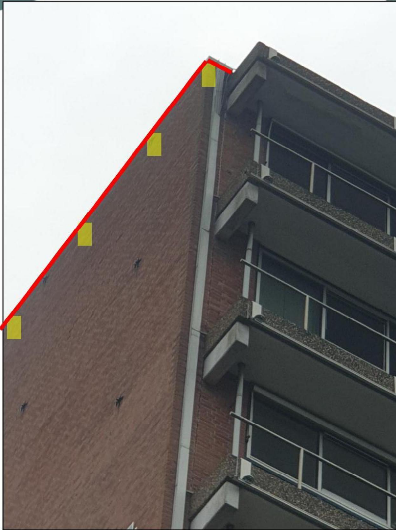
Figuur 10. Foto voorbeeld natuurvrij maken specifiek onderdeel vleermuizen (rode lijn – kieren bij dakrand met plaatsing exclusion flap (gele vierkant).
